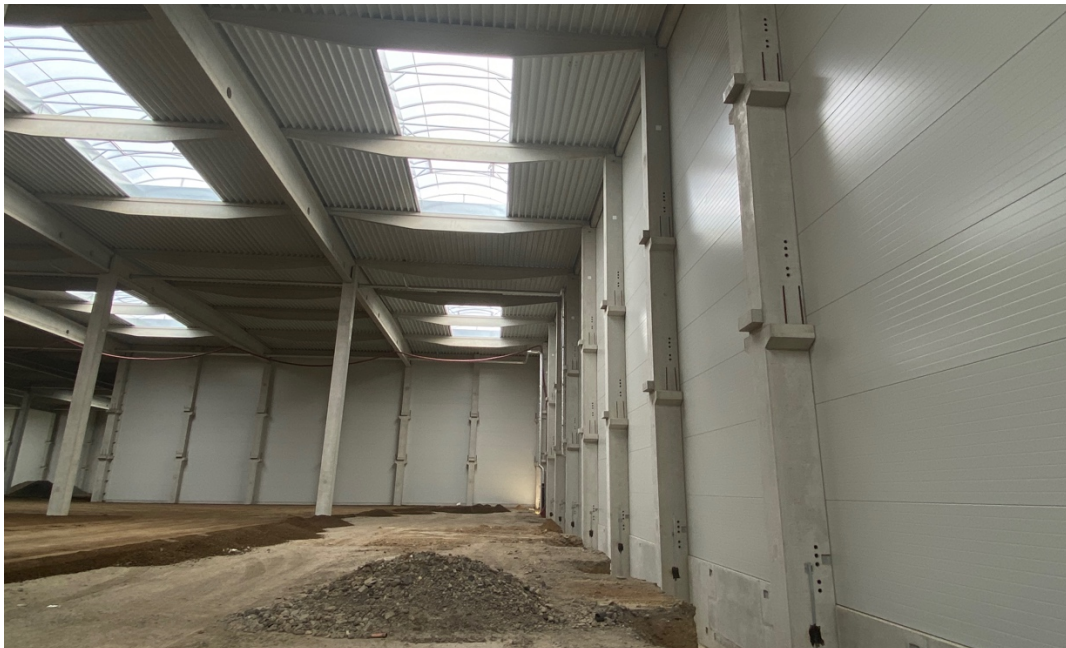
Obr. 11: Dokončení hrubé stavby – interiér haly (foto) [zdroj autor]
