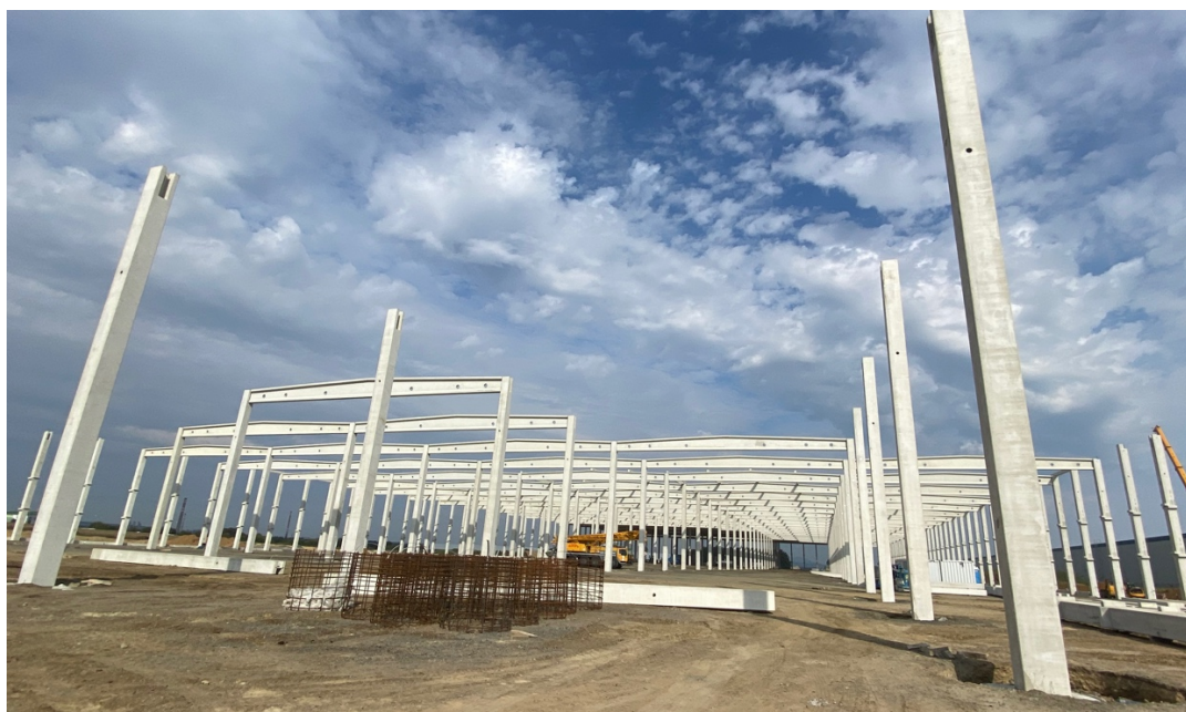
Obr. 9: Skeletový prefabrikovaný konstrukční systém haly (foto) [zdroj autor]
