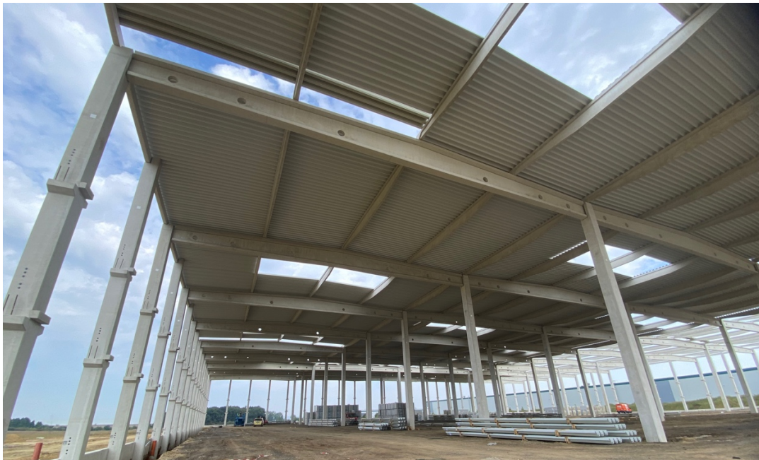
Obr. 8: Skeletový prefabrikovaný konstrukční systém haly (foto) [zdroj autor]
