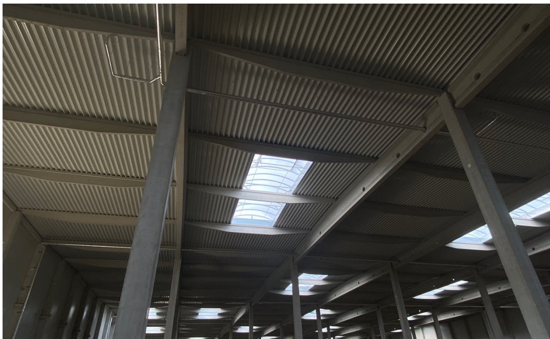
Obr. 12: Pohled na polykarbonátové střešní světlíky (foto) [zdroj autor]
