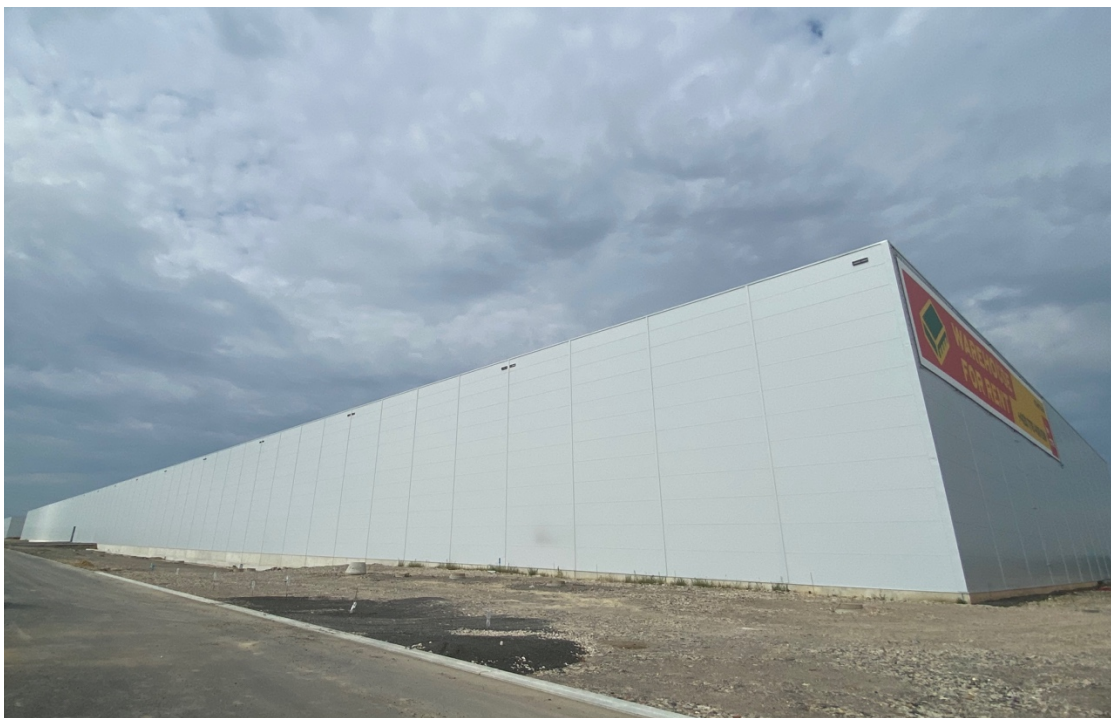
Obr. 7: Pohled fasádu haly (foto) [zdroj autor]
