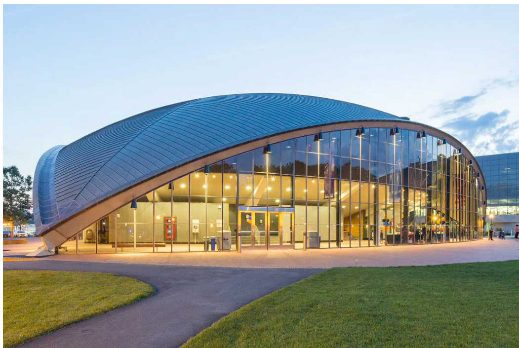
Obrázek 2.2.5: Kresgeho auditorium, MIT, USA [31].
