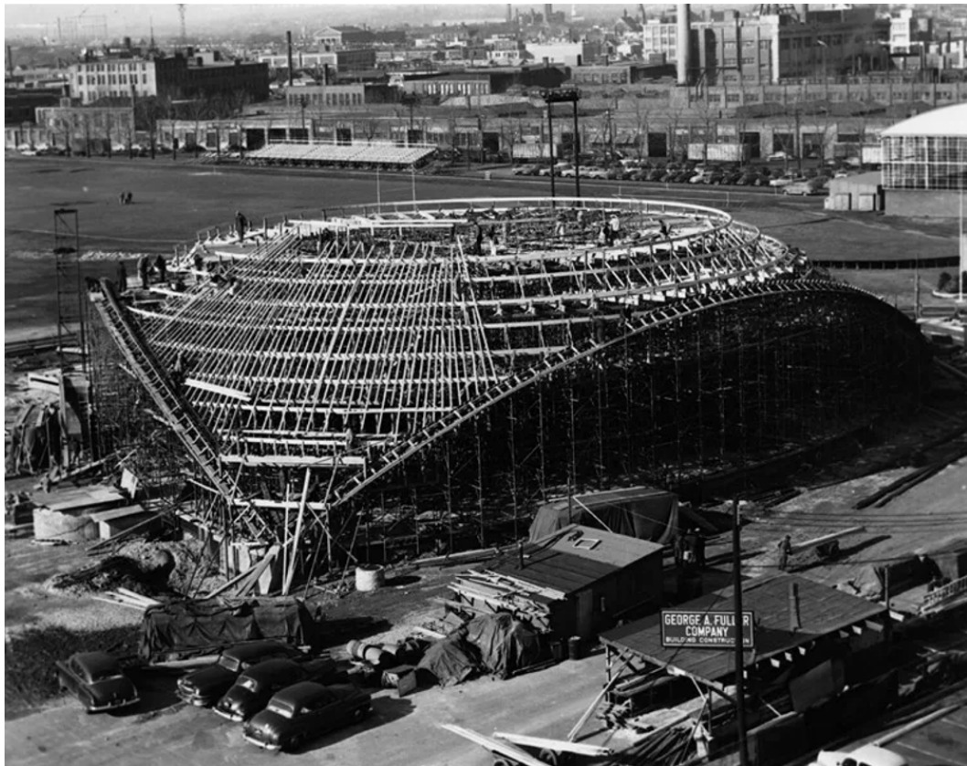
Obrázek 2.2.6: Kresgeho auditorium, MIT – průběh výstavby [38].
