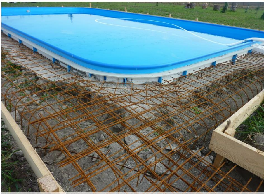
Obrázek 2.3.4 – Příprava plastového bazénu k zabetonování [17]
