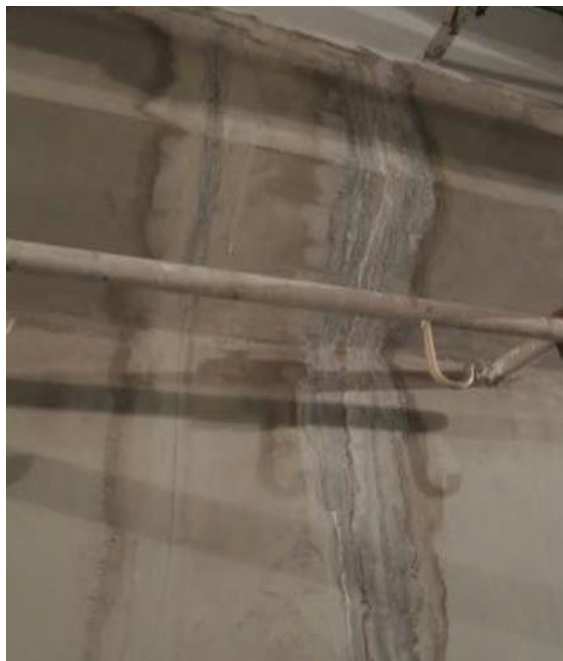
Obrázek 2.8.5 – Průsak bazénu [32]
