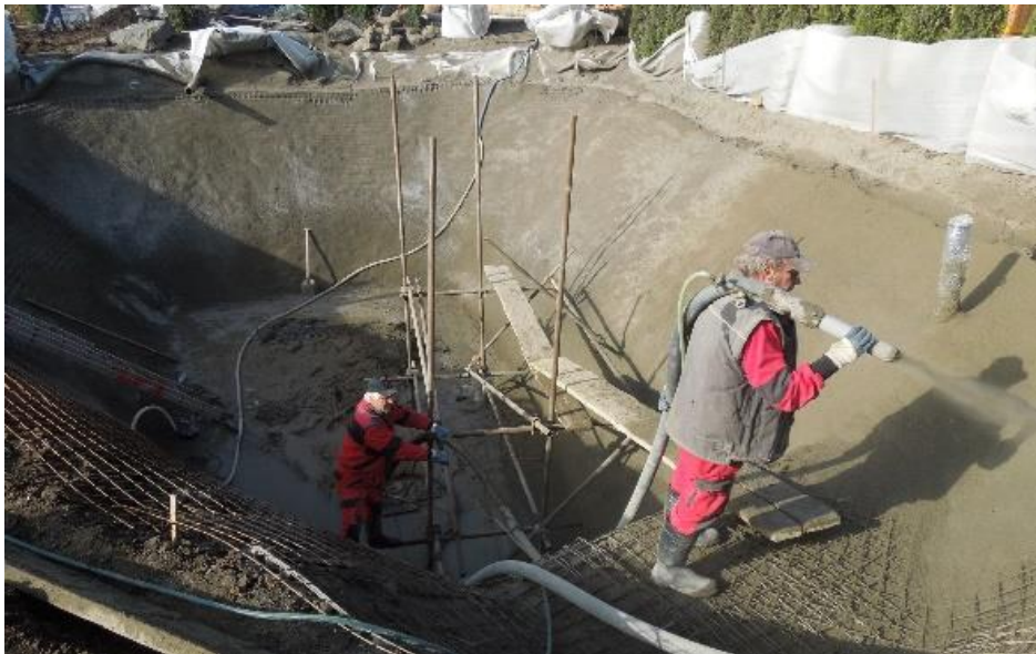
Obrázek 2.3.3 – Ukázka stříkaného betonu [15]
