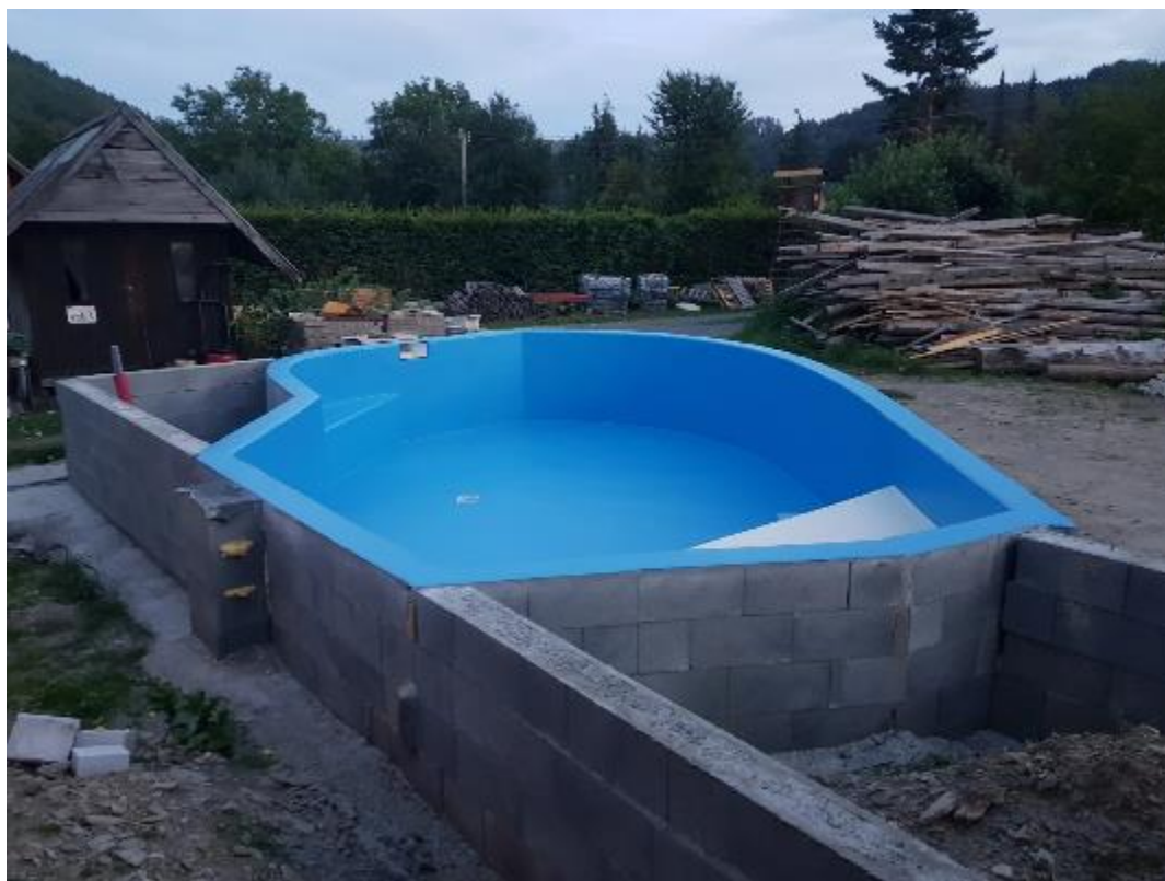
Obrázek 2.3.2 – Bazén z tvárnic ztraceného bednění [14]
