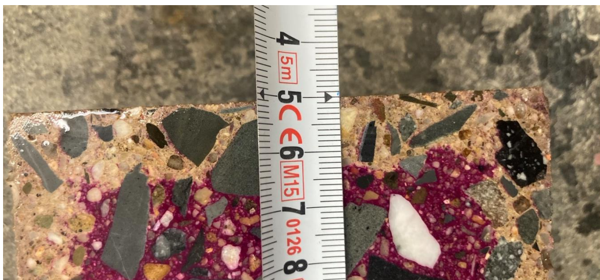
Obr. 55 - Měření hloubky zkarbonatované vrstvy
