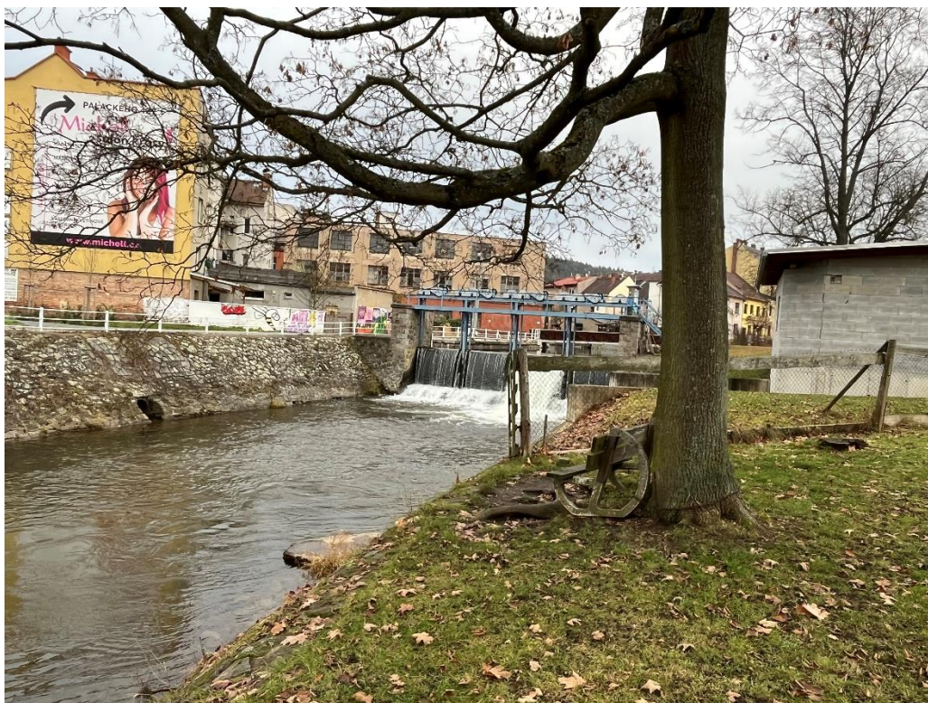
Foto 5: Pohled na místo vstupu budoucího rybího přechodu
