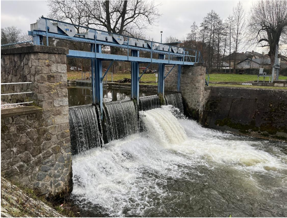
Foto 1: Pohled na stávající stavidlový jez
