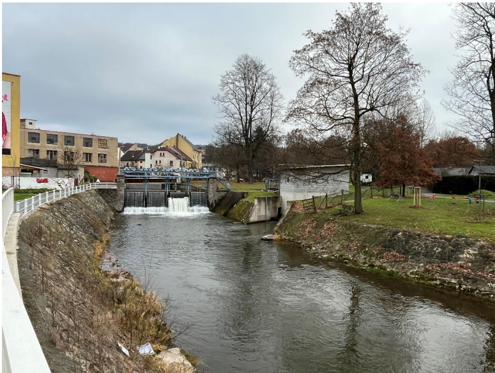
Foto 2: Celkový pohled z podjezí na VD Freiwald
