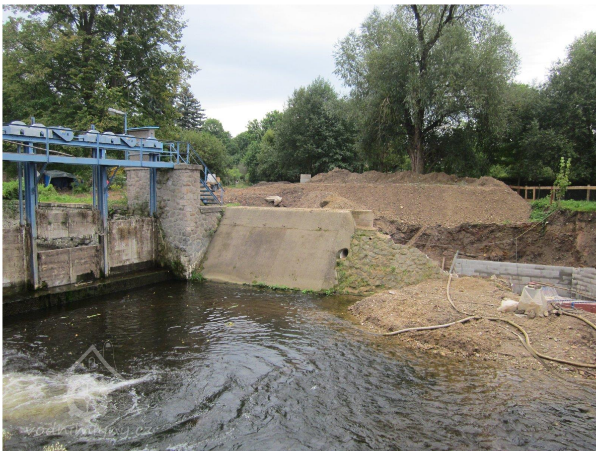
Obrázek 16: Výstavba současné MVE, rok 2014 [14]
