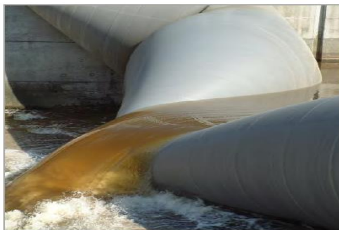
Obrázek 2: V-efekt, kolaps vakového uzávěru [2]
