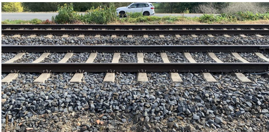
Obrázek 55: Detail železniční trati 90.
