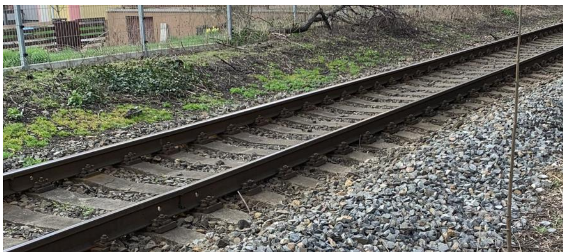
Obrázek 59: Detail železniční trati 120.
