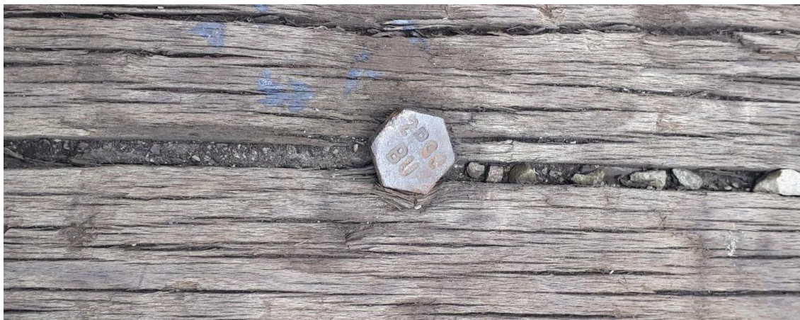
Obr. 3: Označení dřevěného pražce pražcovým hřebem [Zdroj: Autor]
