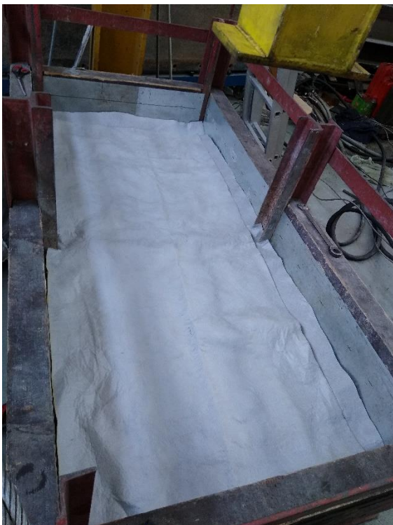
Obr. 24: Uložení geotextilie na první vrstvu štěrku [Zdroj: Autor]
