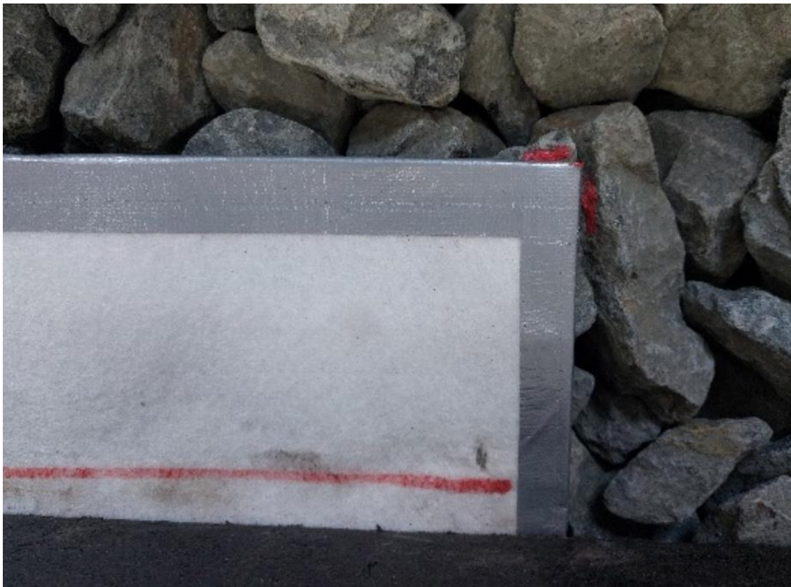
Obr. 28: Označení místa pro uložení tlakové podložky a pro uložení pražce [Zdroj: Autor]
