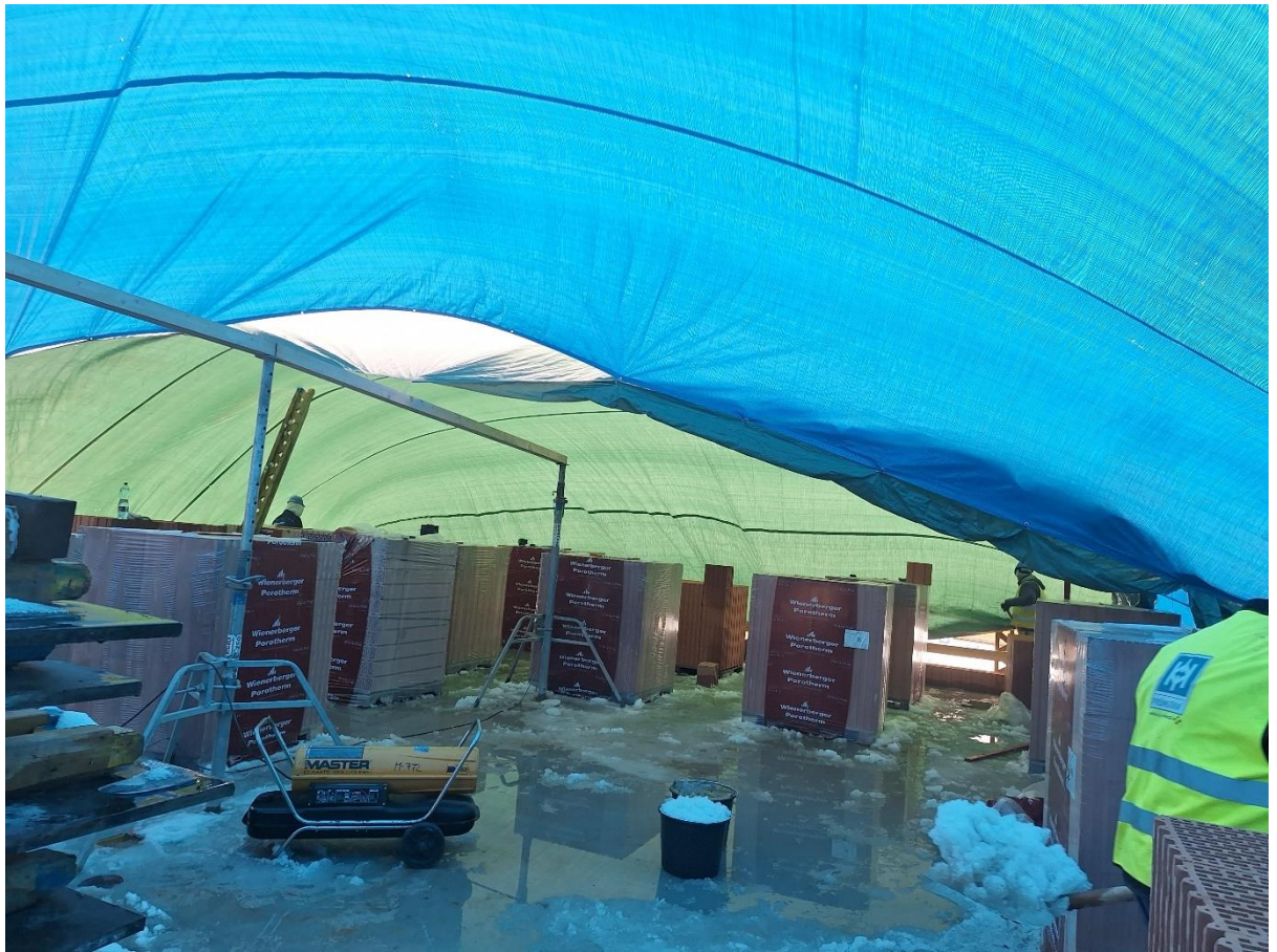
Obrázek 24: Zdění pod plachtou
