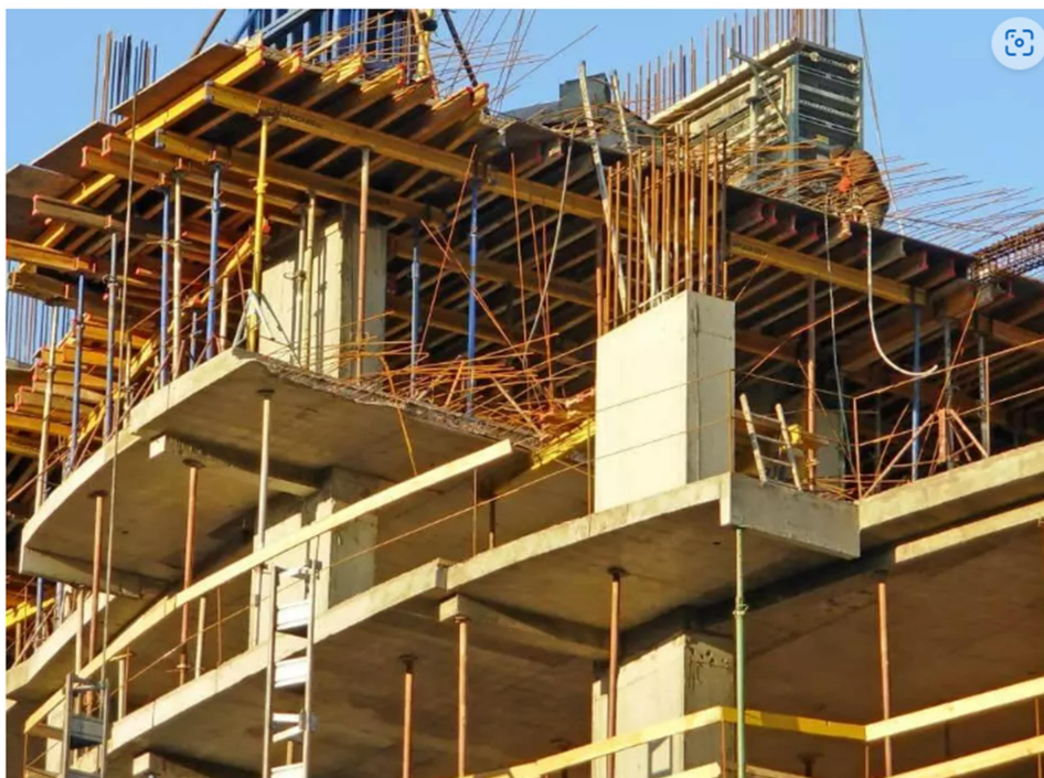
Obrázek 8 - Pohled na monolitickou konstrukci (Zdroj: 8)
