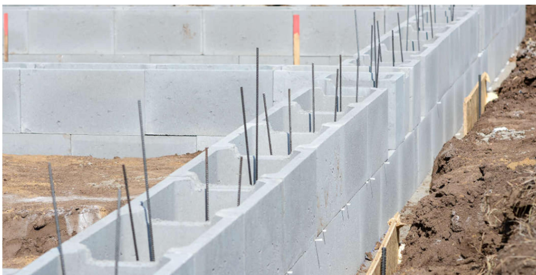
Obrázek 11 - Ukázka zdi ze ztraceného bednění (Zdroj: 11)
