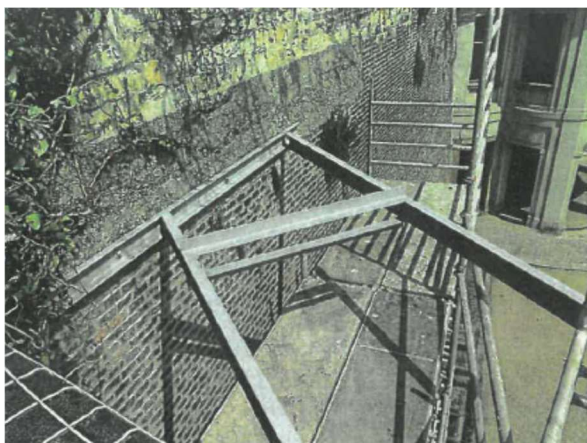
Obr. 29 – Zajištění ohradní zdi [29]
