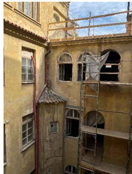
Obr. 15 – Fasáda řešeného objektu [15]
