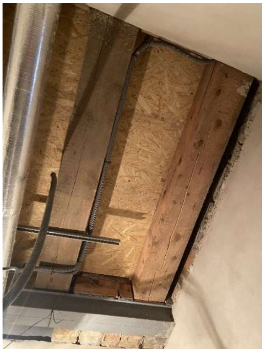
Obr. 44 – Provedení nového stropu nad místností č. 3.13 [44]
