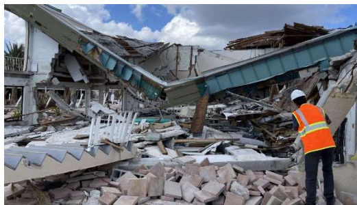
Obr. 1 – Budova poničená hurikánem [1]
