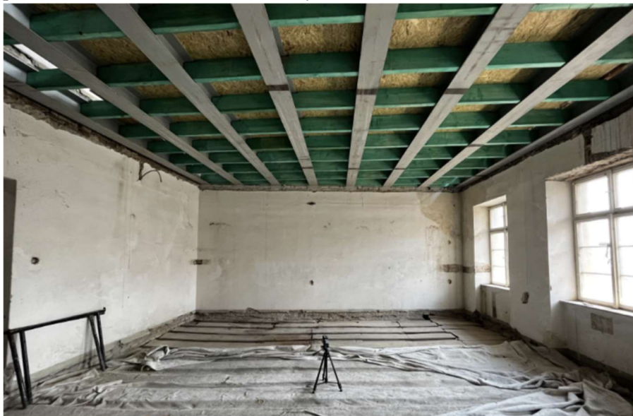
Obr. 19 – Nový strop nad 4.NP [19]
