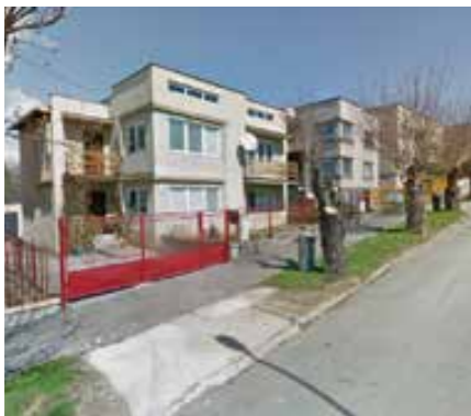
Nová Dúbrava socialistická zástavba rodinných domov a halových objektov, prímestský vidiek Zdroj [Google Street View]
