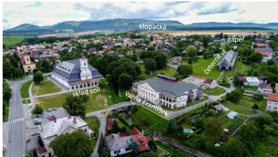
2 | Solivar | komplex technických objektov zo 17. storočia na čerpanie a varenie soli zo soľanky, skladište soli, varňa František, čerpanie (rezervoáre soľanky), gápel (nad šachtou Leopold), klopačka a kaplnka sv. Rócha, v roku 1572 sa začalo s hlbinnou ťažbou soli, po zatopení baní v roku 1752 sa začalo s čerpaním soľanky z podzemia v kožených mechoch obrázok - Zdroj [61]
