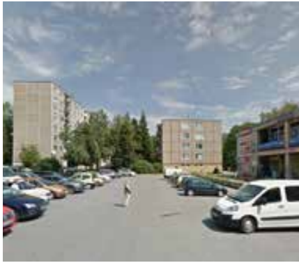
Sídliisko III - Družba rôzna typológia panelových bytových domov Zdroj [Google Street View]
