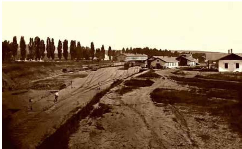
železničná stanica, pohľad smerom na juh, 1876 Zdroj [39]
