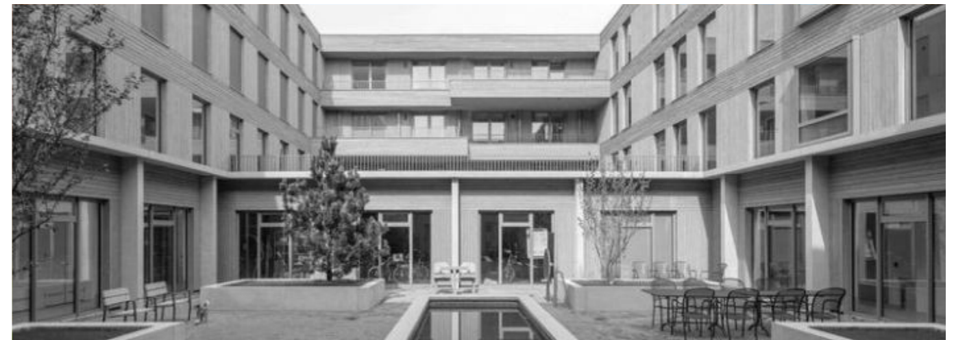
Pečovatel'ský dům Rotterdam (Rotterdam, Nizozemsko, KAW)
