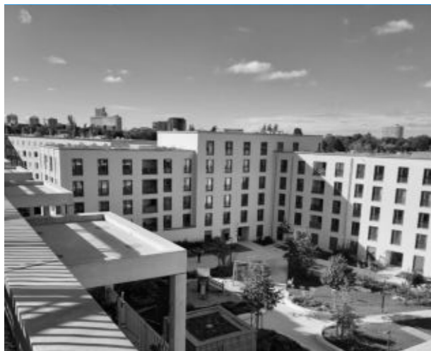
Otevřený blok v bytovém komplexu Prinz Eugen-Park (München, Německo, GSP architekten)
