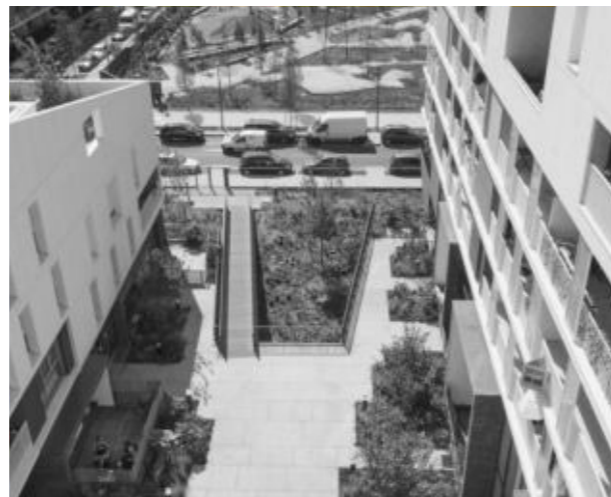
ZAC Chandon République (Gennevilliers, Francie, MFR Architectes)
