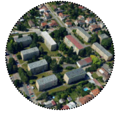
Sídliště 70. léta nižší zástavba
