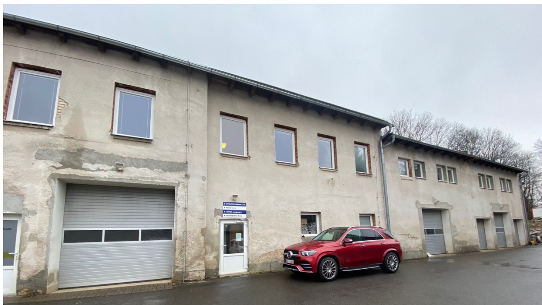
Obr.19 Fotka stávajícího stavu objektu, zdroj: vlastní
