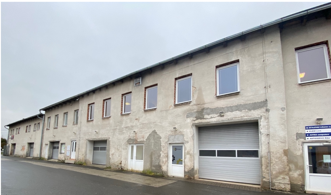
Obr.18 Fotka stávajícího stavu objektu, zdroj: vlastní
