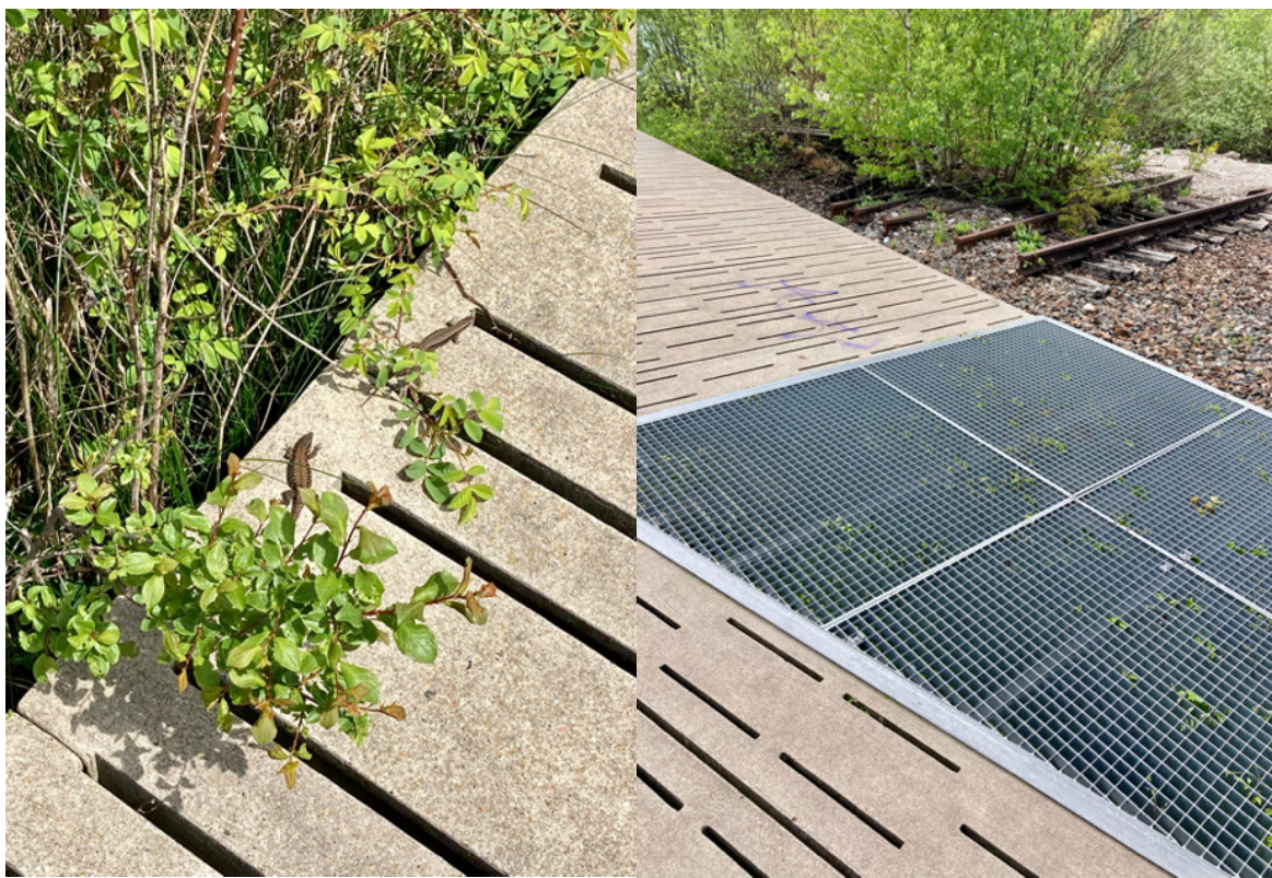
Obrázek 68: Pochozí betonová lávka s drenážními drážkami a biodiverzita (vlastní snímek)
