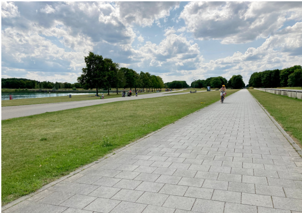
Obrázek 82: Cesty z propustných a polo-propustných povrchů napříč parkem (vlastní snímek)
