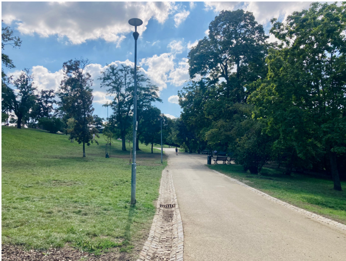
Obrázek 9: Rekonstrukce cest, odvádění srážkových vod, Riegrových sady (vlastní snímek)
