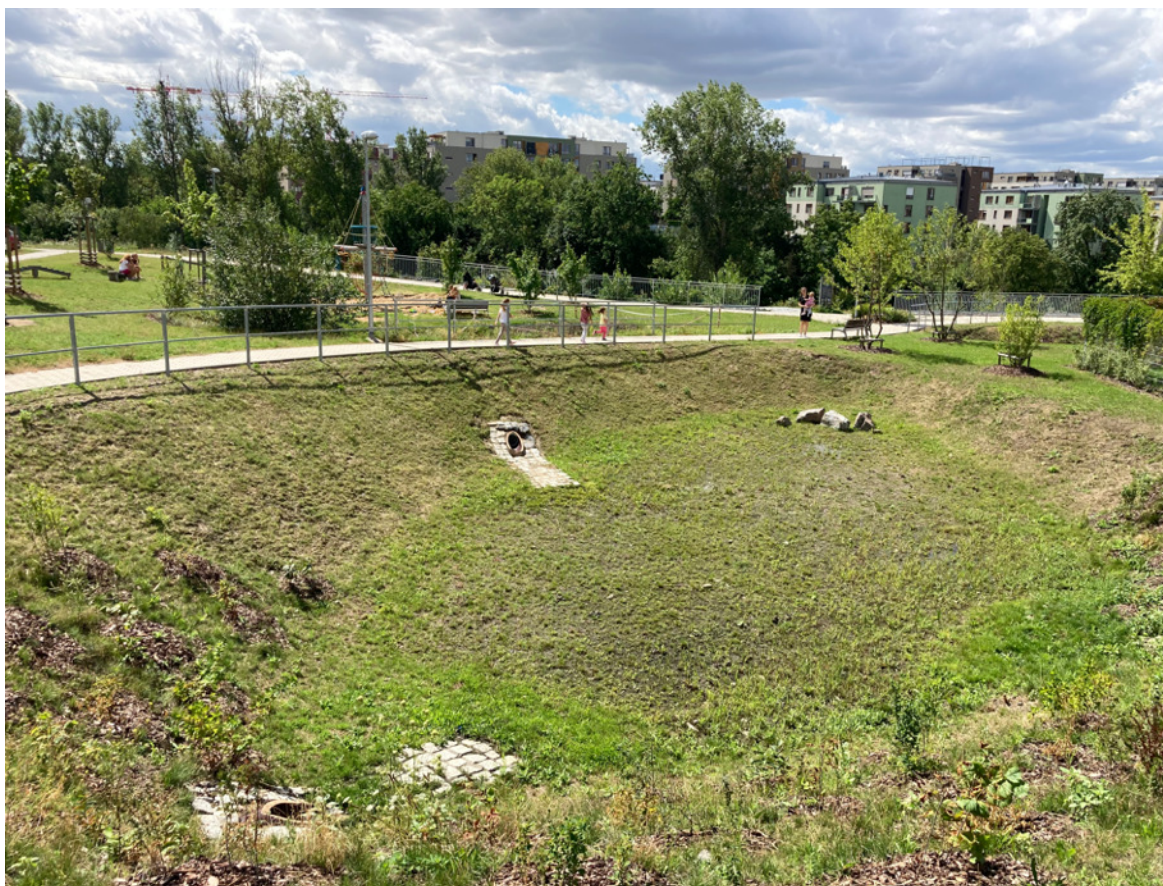
Obrázek 23: Nejvýše položená vsakovací nádrž (vlastní snímek)
