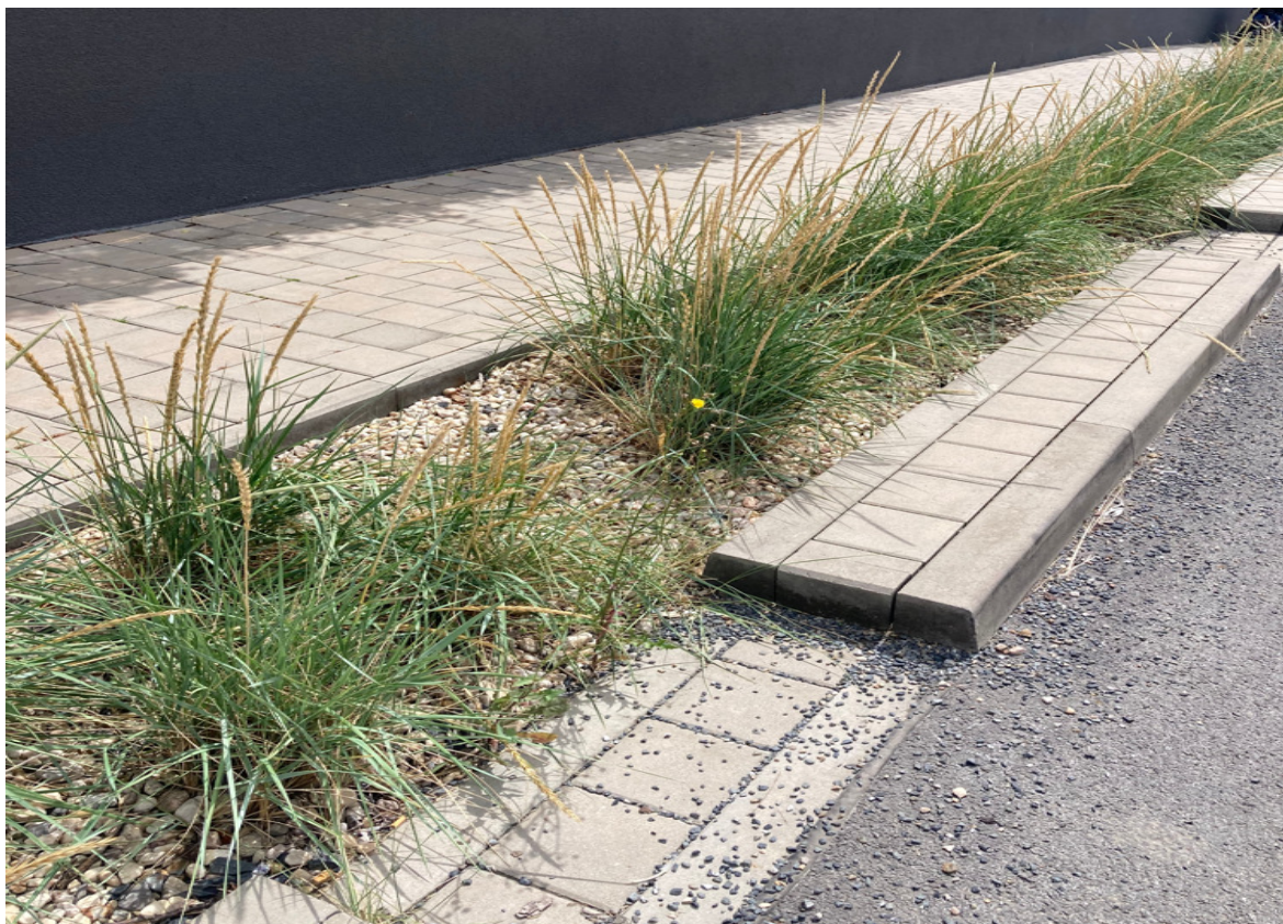
Obrázek 26: Průleh vyplněný štěrkem osázený travinami (vlastní snímek)
