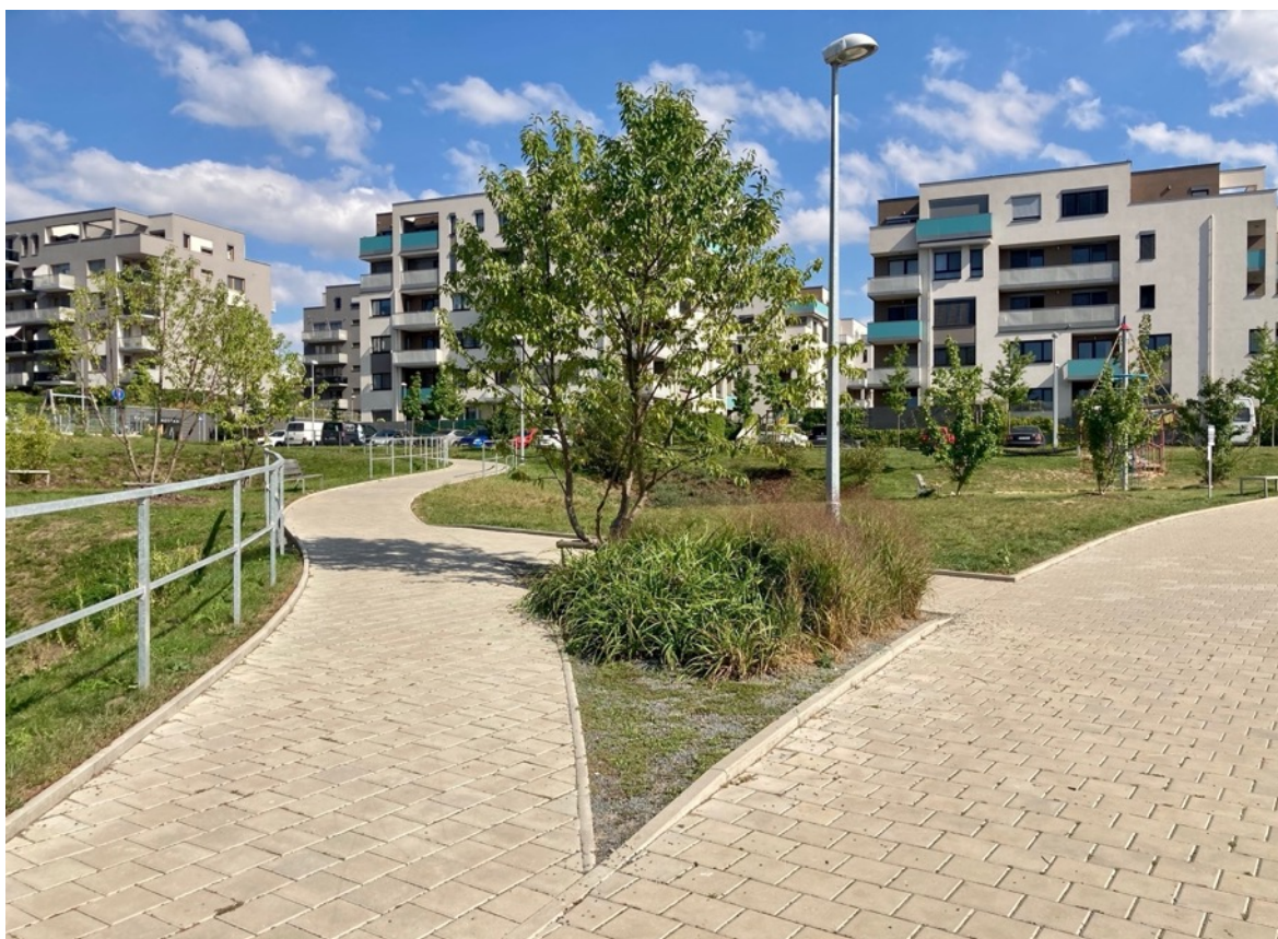
Obrázek 28: Odvodnění cest (vlastní snímek)
