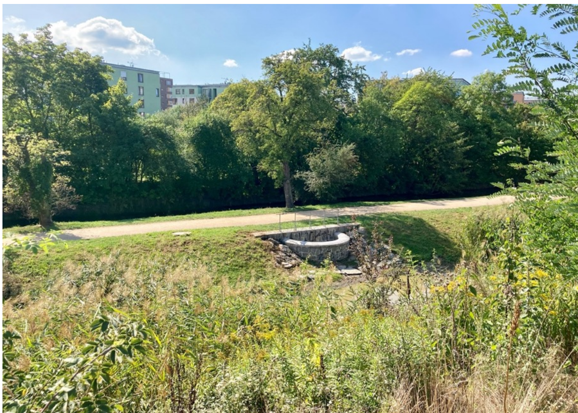
Obrázek 27: Centrální vsakovací nádrž s bezpečnostním přelivem do Rokytky (vlastní snímek)
