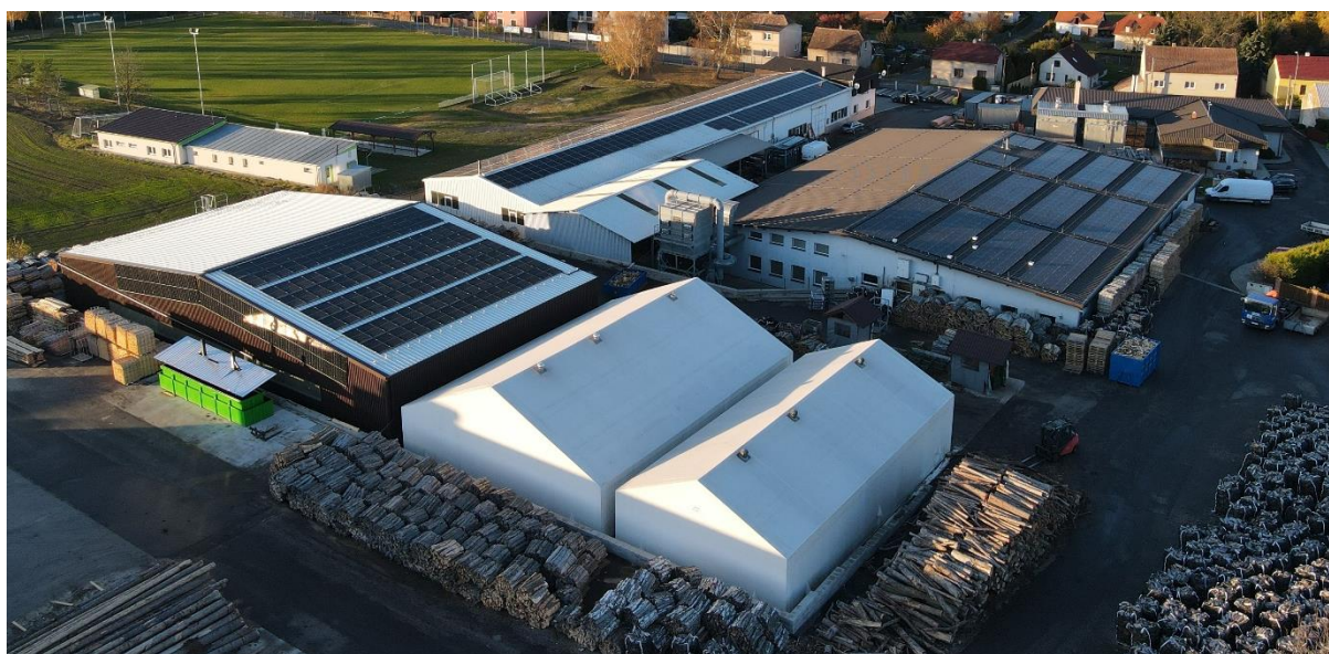
Obrázek 13 Areál podniku PINIE s nainstalovanými fotovoltaickými panely, zdroj vlastní
