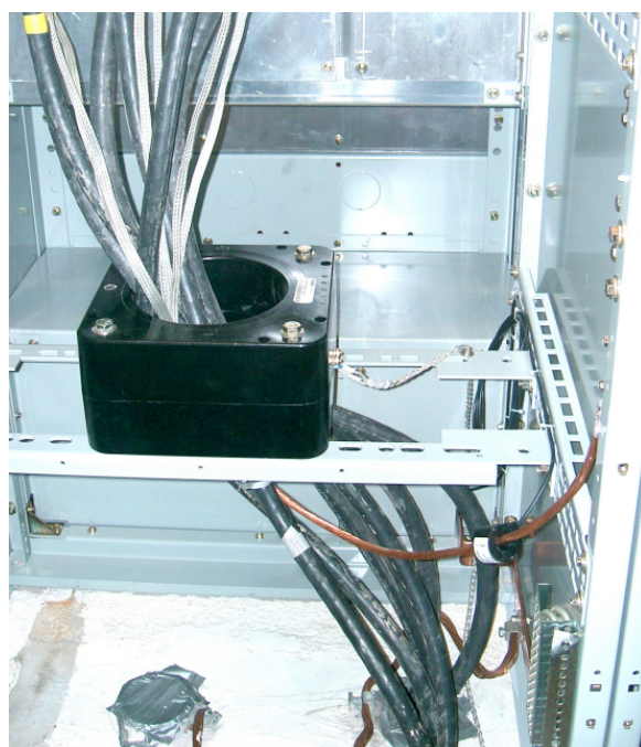
Obrázek 2.1: Umístění vysokofrekvenčního proudového transformátoru na zemním spoji [1]
