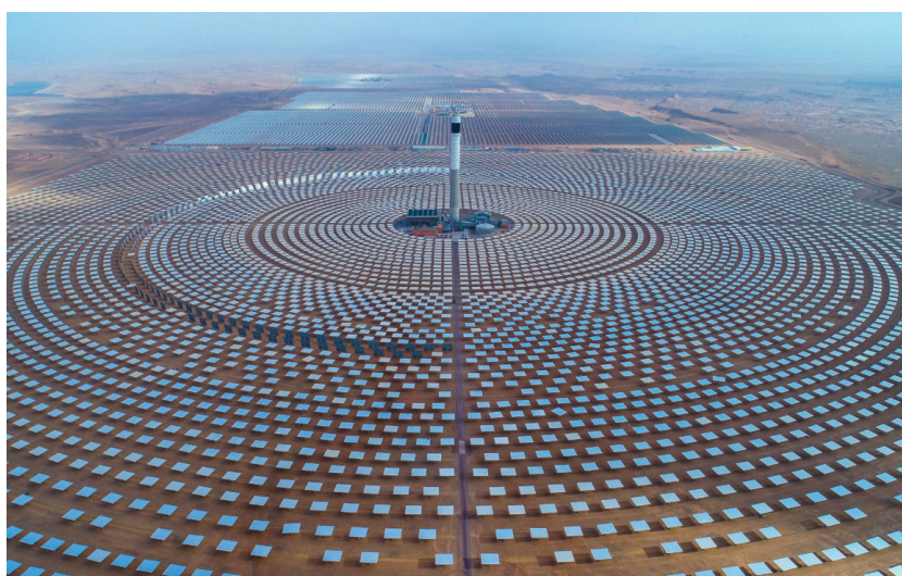
Obrázek 3.4: Noor Ouarzazate Solar Complex [29]
