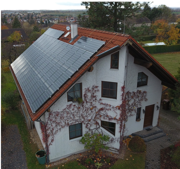
Obrázek 4.1: Rodinná dřevostavba na adrese Bezručova 1264/8. Zdroj: Vlastní
