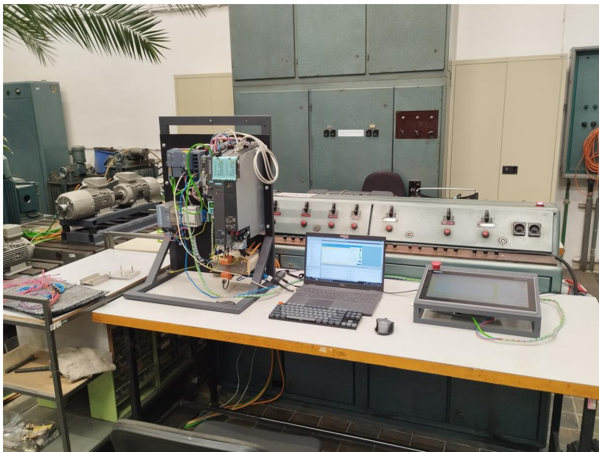
Obr. 3-5 Realizované stanoviště: PLC, měnič, HMI panel a počítač s TIA portálem.
