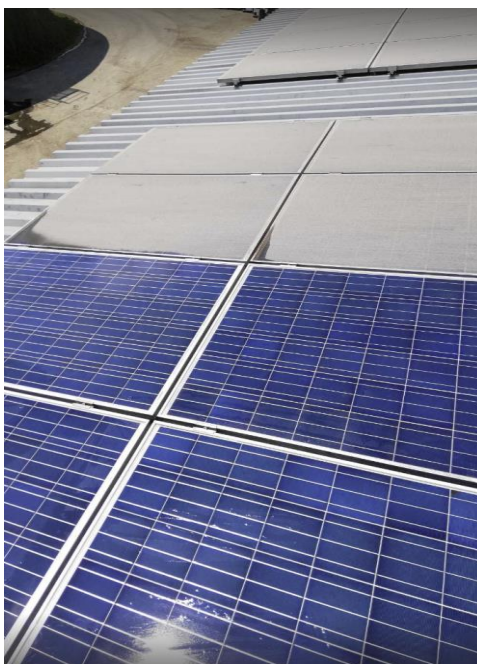
Obrázek 4. Ukázka velmi zašpiněných panelů. Severní Čechy, Ústí nad Labem
