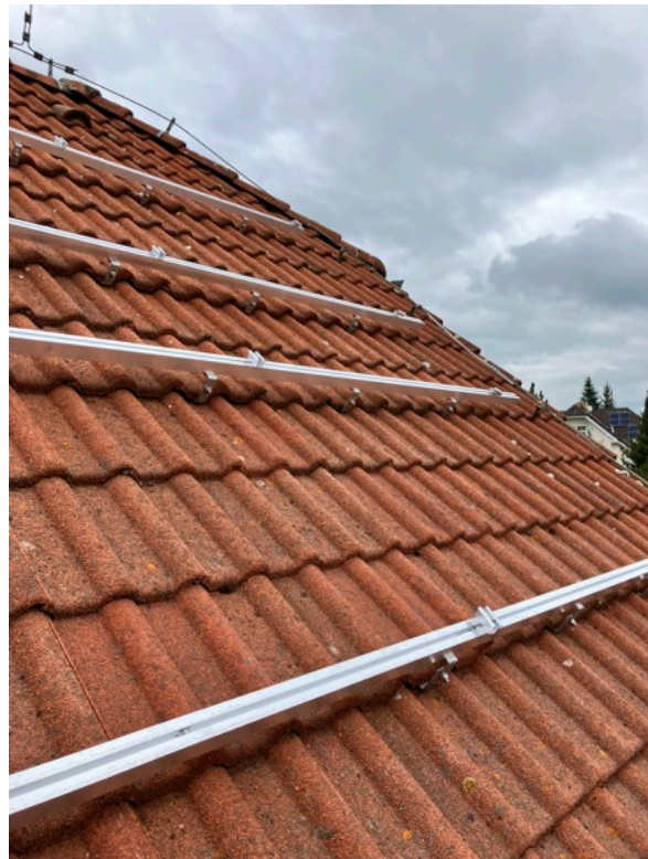
Obr. 4-6: Krytina s hliníkovými profily a hromosvodem před instalací
