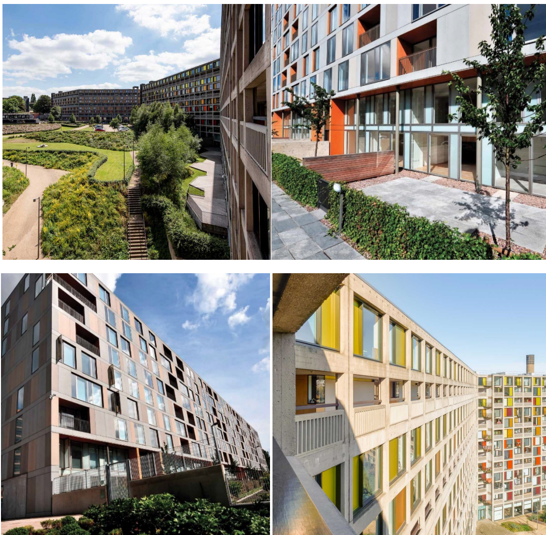
Obr. 6 Park Hill, Sheffield – výsledek přestavby objektů (Zdroj: Urban Splash)
