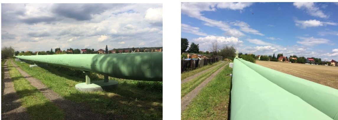
Obr 55: Termoizolační nátěr na horkovodu společnosti ČEZ Teplárenská v lokalitě obce Dolní Beřkovice, Zdroj: ADITEX, spol. s r.o.
