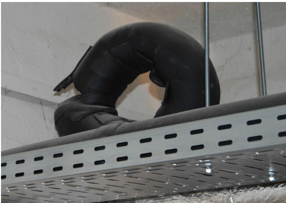
Obr 1: Prasklá tepelná izolace na kompenzátoru délkové roztažnosti v bytovém domě v Praze, Zdroj: fotoarchiv autora
