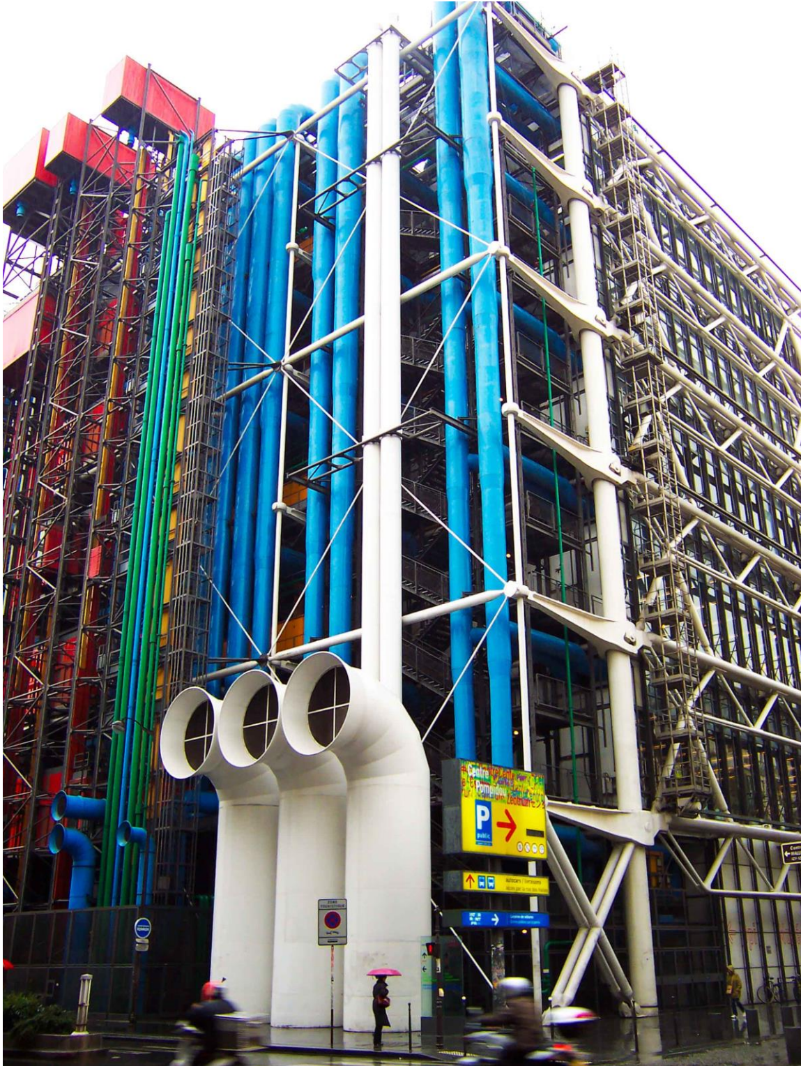
Obr 18.: Neizolované potrubí Centre Georges Pompidou, Zdroj: fotoarchiv autora
