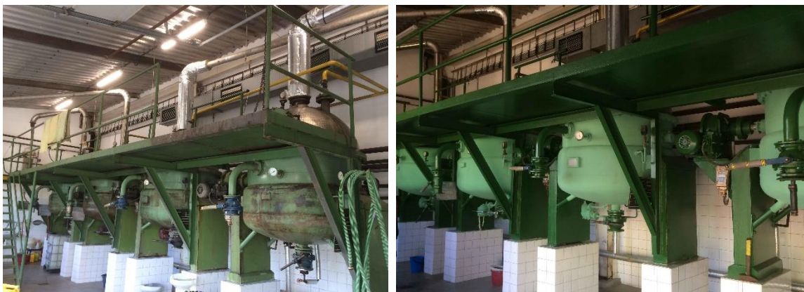
Obr 59: Krystalizační kotle v lihovaru v Jílovém u Prahy, vlevo situace před aplikací termoizolačního materiálu, vpravo po aplikaci, Zdroj: ADITEX, spol. s r.o.
