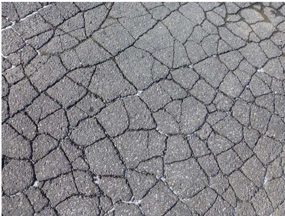
Obrázok 6: Sieťové trhliny [10]
