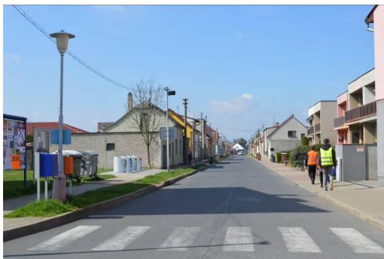
Obrázek 15: Nevhodně navržený přechod pro chodce v ulici Lidická
