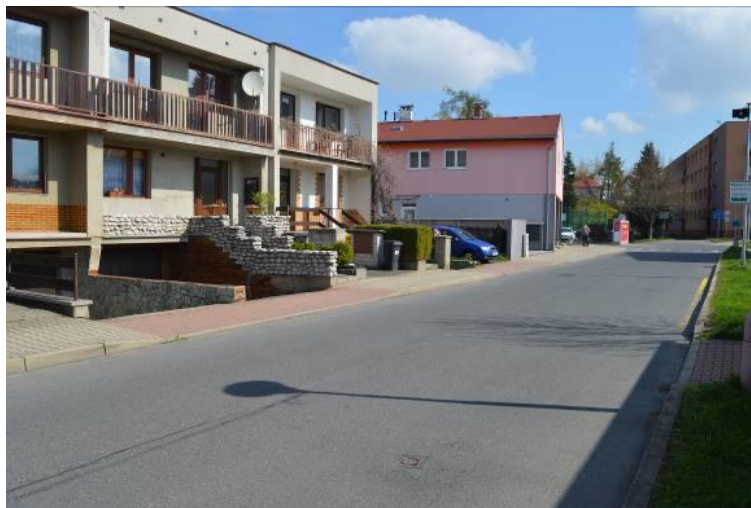
Obrázek 14: Chodníkové plochy po rekonstrukci v ulici Lidická
