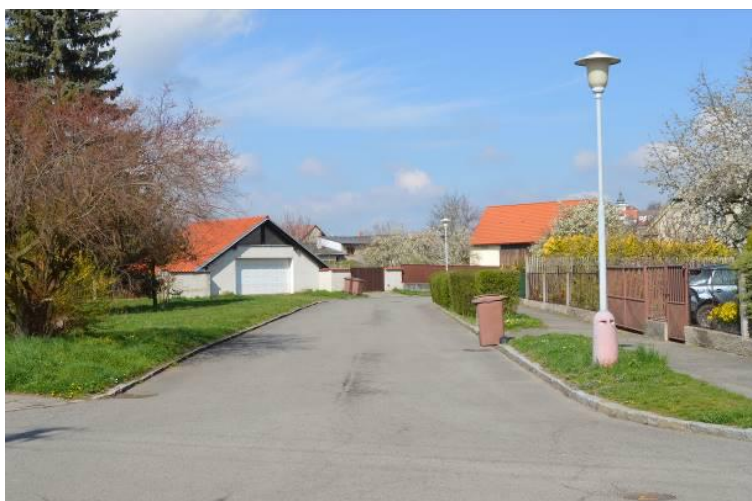
Obrázek 13: Chodníkové plochy v ulici Šnajdrova před rekonstrukcí
