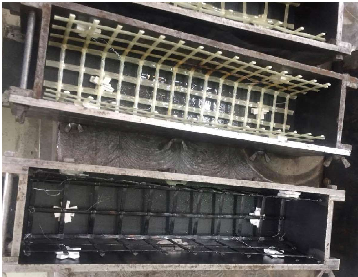
Obrázek 59 – Uložená výztuž s distančními prvky ve formě
