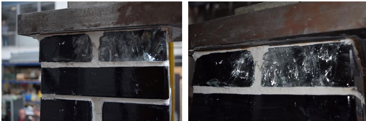
Obr. 8.56: Poškození dvou horních cihel
