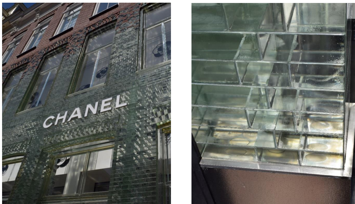
Obr. 5.18: Čelní fasáda domu Crystal House v Amsterdamu
