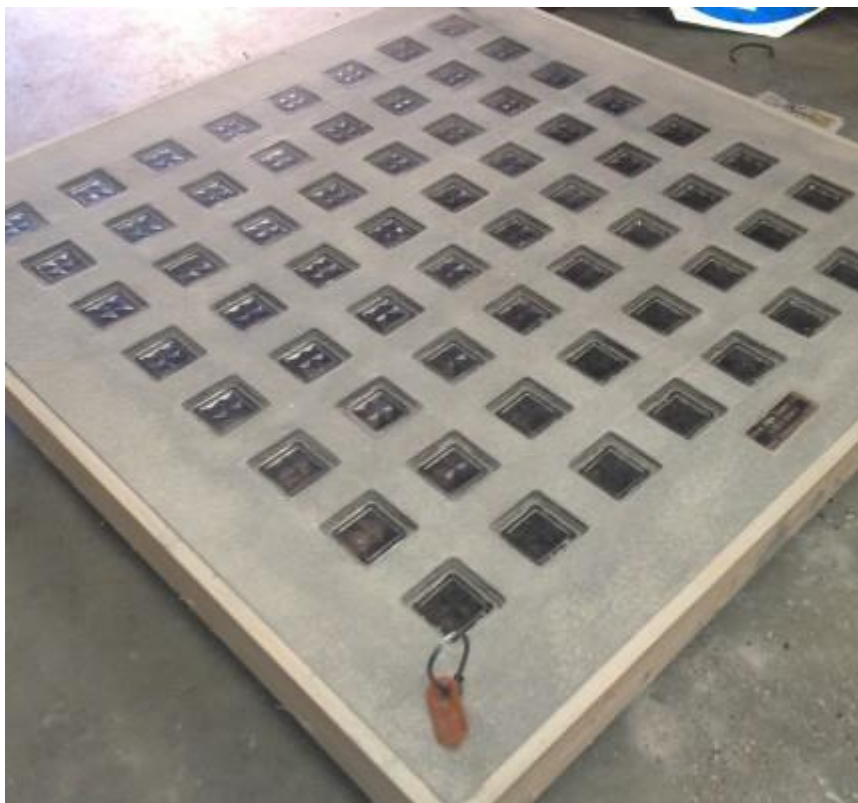
Obr. 5.7: Prefabrikovaný panel z dutých skleněných tvárníc, [24]
