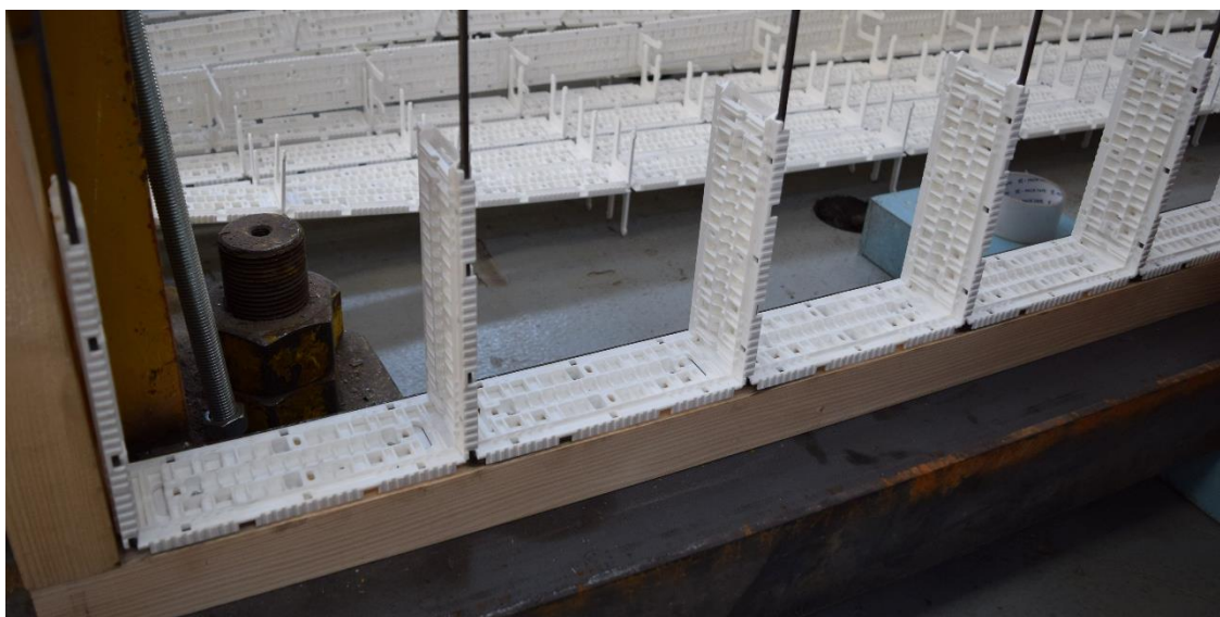
Obr. 5.4: Systém plastových rámečků připravený na osazení tvárnic
