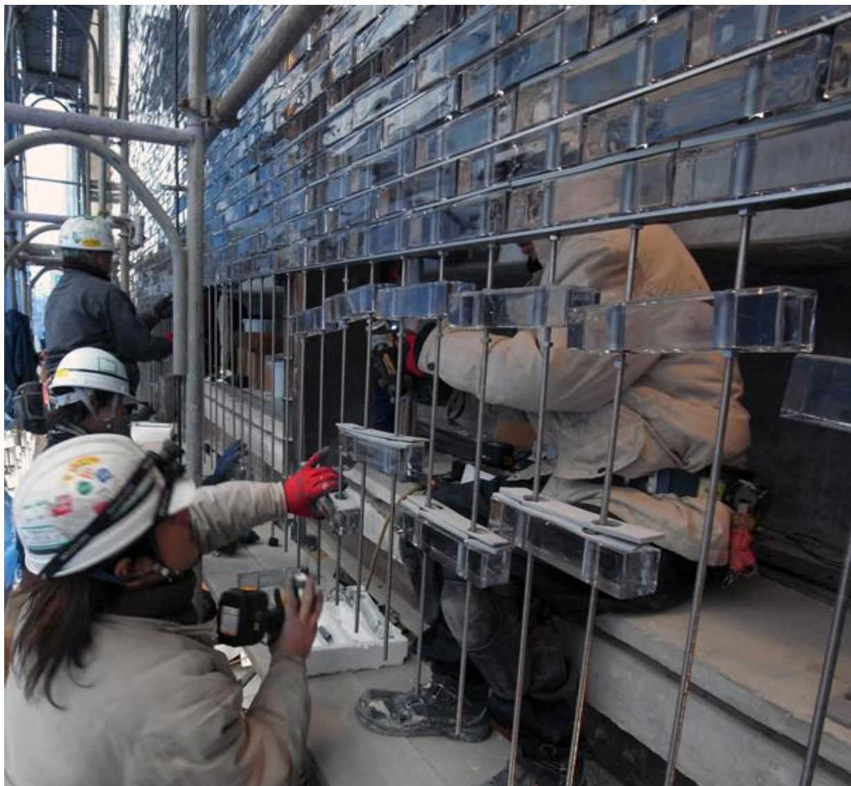
Obr. 5.14: Montáž skleněné fasády domu Optical Glass House, [34]
