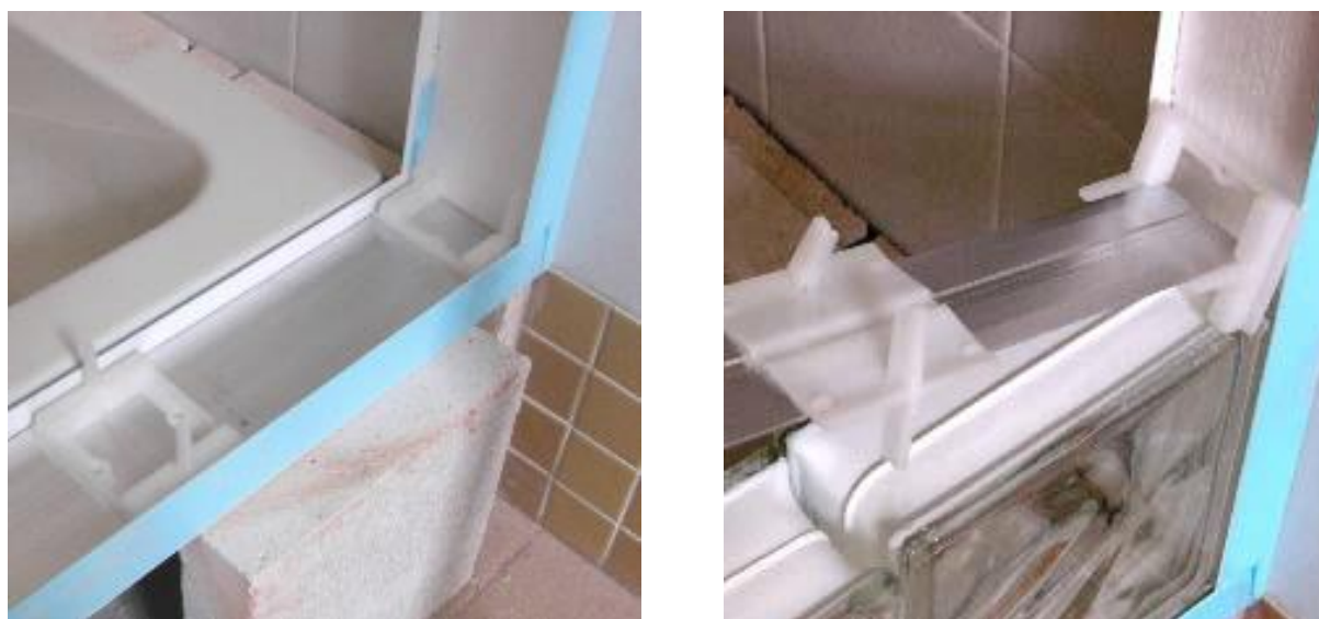
Obr. 5.6: Ezyloy systém využívající hliníkových U-profilů, [23]
