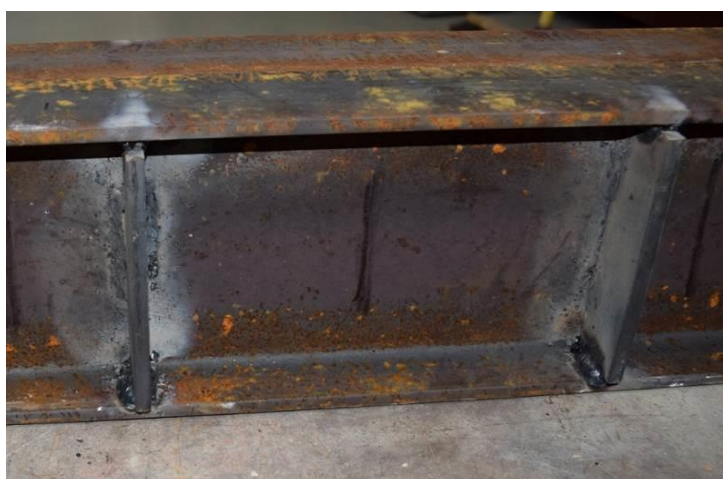
Obr. 8.8: Detaily výztuh ocelových nosníků
