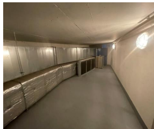
Obrázek 16: Rozvodna vzduchotechniky
