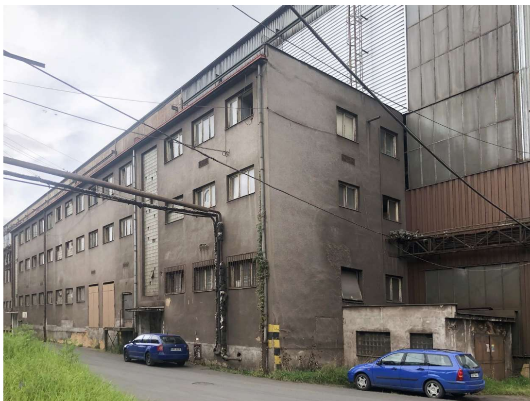
Obr. 219 – Šatny a kanceláře elektroocelárny, pohled jihovýchodní, 2021, Zdroj: archiv autora
