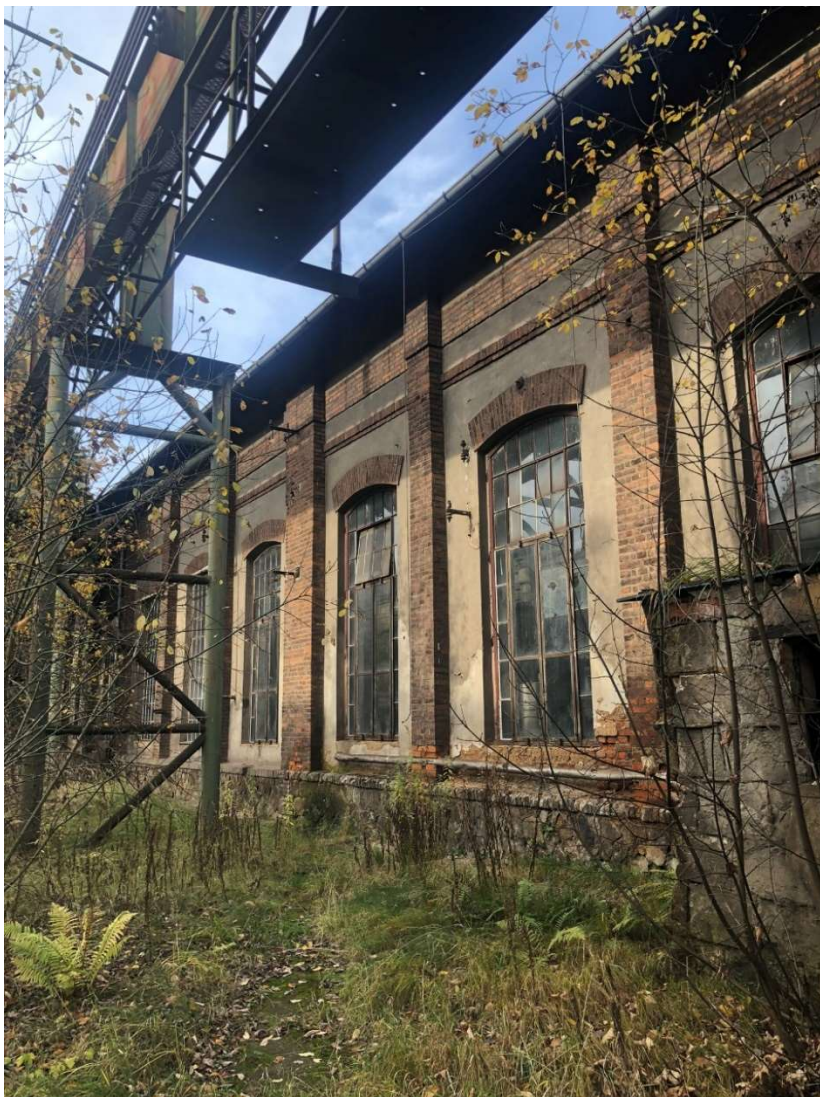
Obr. 102 – Tažirna, jižní fasáda, 2021, Zdroj: archiv autora
