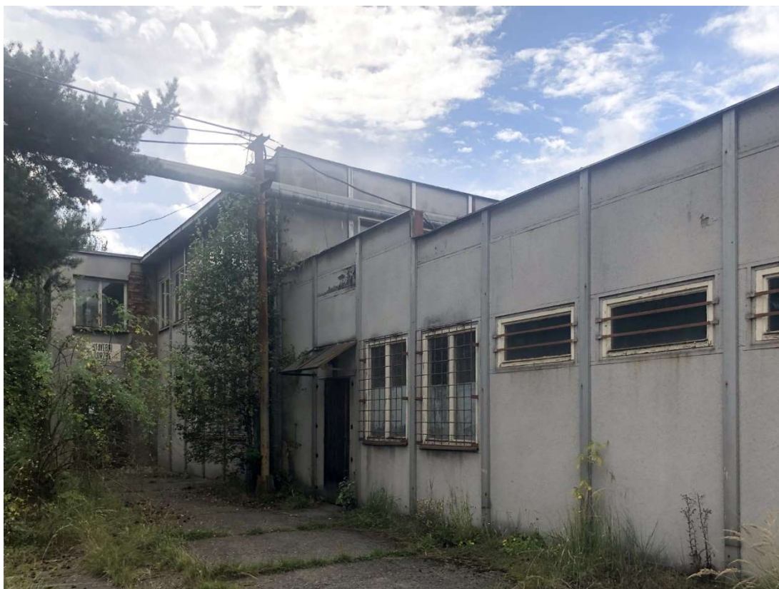
Obr. 239 – Budova stavební údržby, východní pohled, 2021, Zdroj: archiv autora
