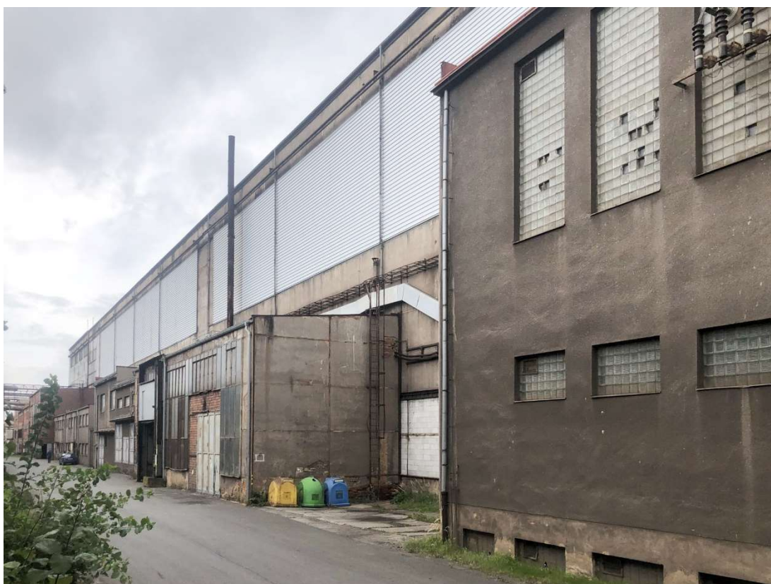
Obr. 211 – Elektroocelárna, v popředí s rozvodnou, dále elektrodílnou a v pozadí s elektroobjektem HZPO, jižní pohled, 2021, Zdroj: archiv autora
