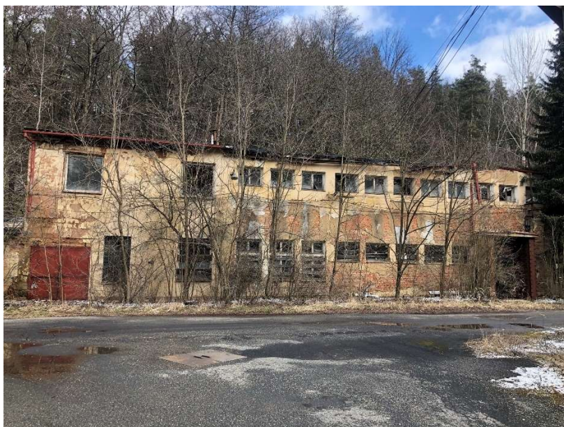
Obr. 266 – Stará stavební údržba a šatny, 2021, Zdroj: archiv autora
