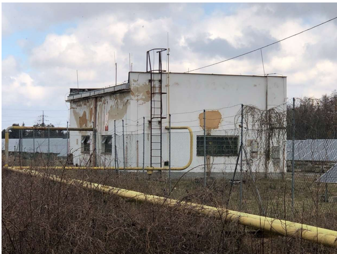
Obr. 295 – Regulační stanice plynu, pohled jihovýchodní, 2021, Zdroj: archiv autora
