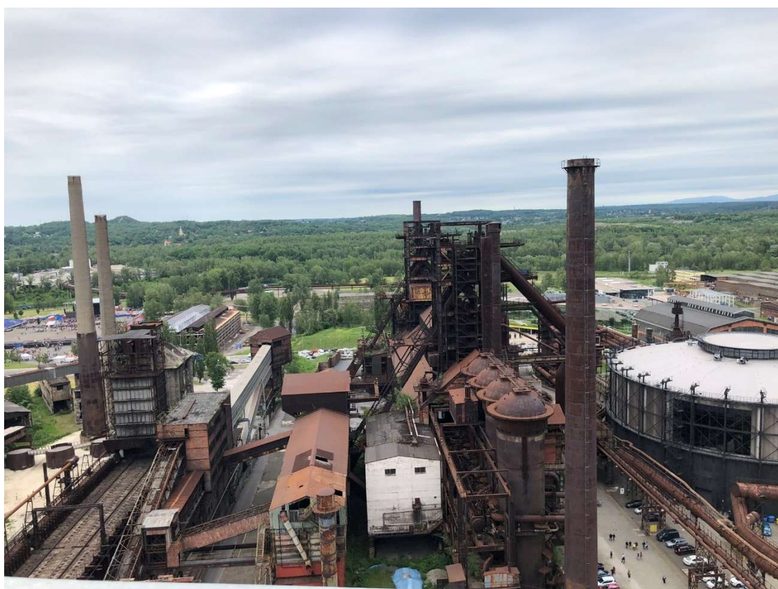
Obr. 380 – Dolní oblast Vítkovice focená z vyhlídky Bolt Tower na vysoké peci č.1, vpravo na fotce je původní plynojem – dnes multifunkční aula Gong, 2019, Zdroj: archiv autorky
