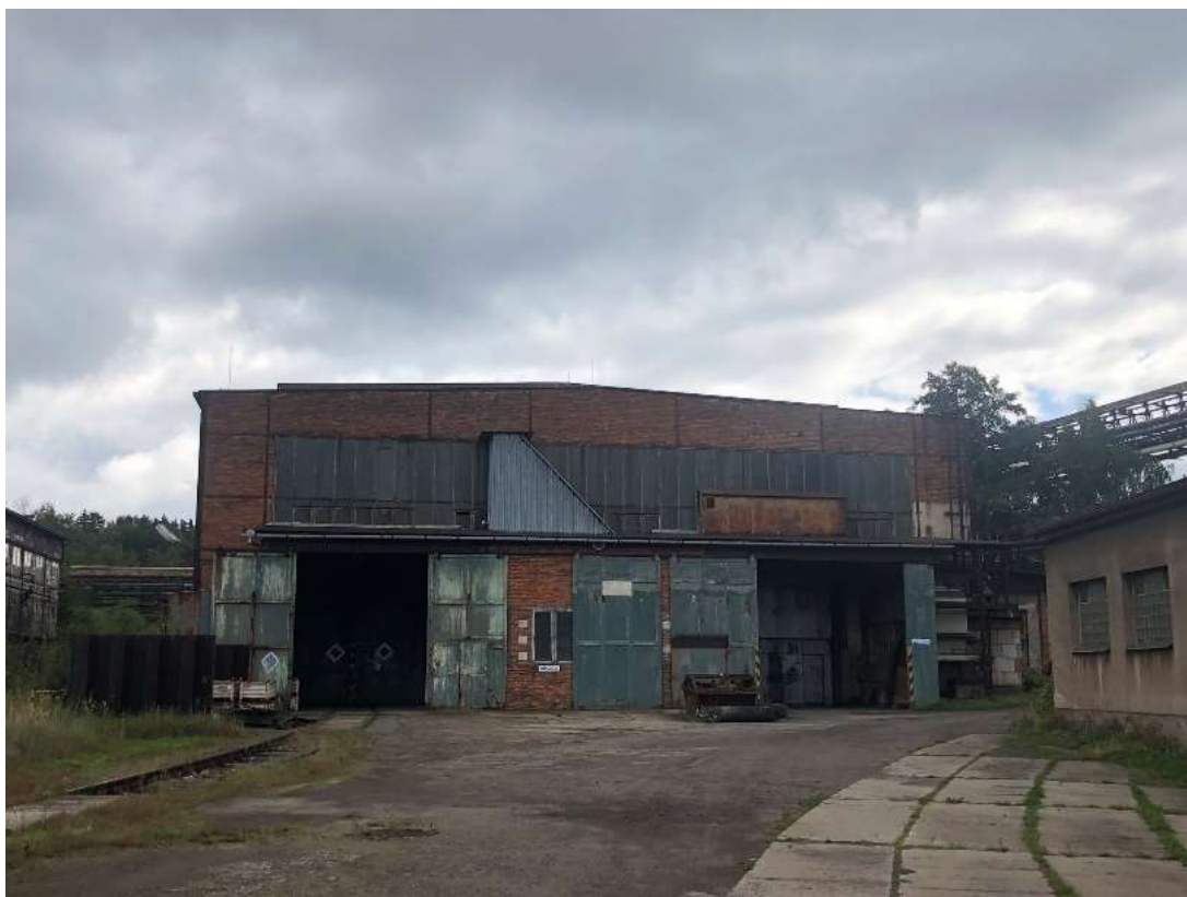
Obr. 79 – Mechanické dílny, západní pohled, 2021, Zdroj: archiv autora
