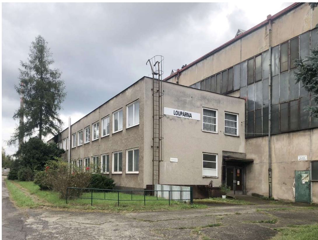
Obr. 191 – Loupárna, budova řízení jakosti, pohled severozápadní, 2021, Zdroj: archiv autora
