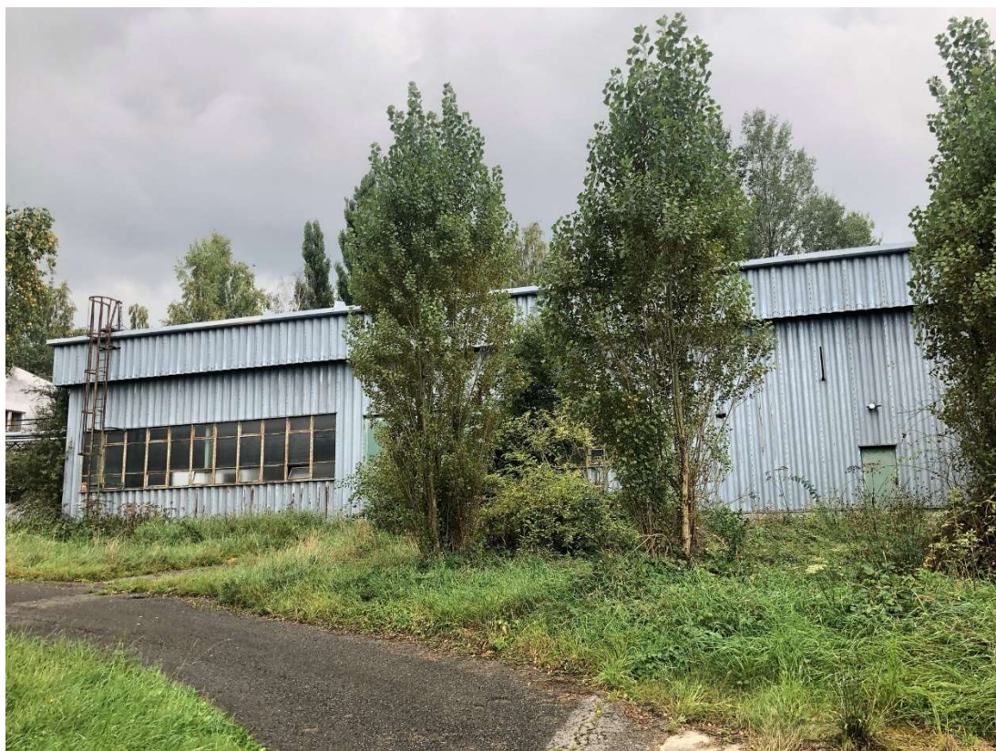
Obr. 315 – Budova skladu nebezpečných odpadů, pohled severní, Zdroj: archiv autora
