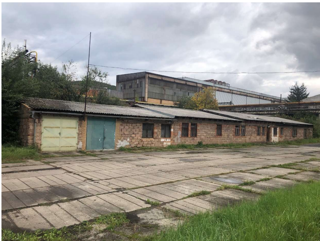
Obr. 150 – Objekt zařízení „stavenišť“, severozápadní pohled, 2021, Zdroj: archiv autora
