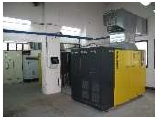
Obr. 269 – Kompresorovna Kaeser, interiér, Zdroj: archiv Josefa Brožika
