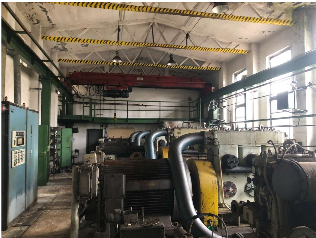
Obr. 163 – Budova kyslíkárny, interiér části s dílnou, 2022, Zdroj: archiv autora
