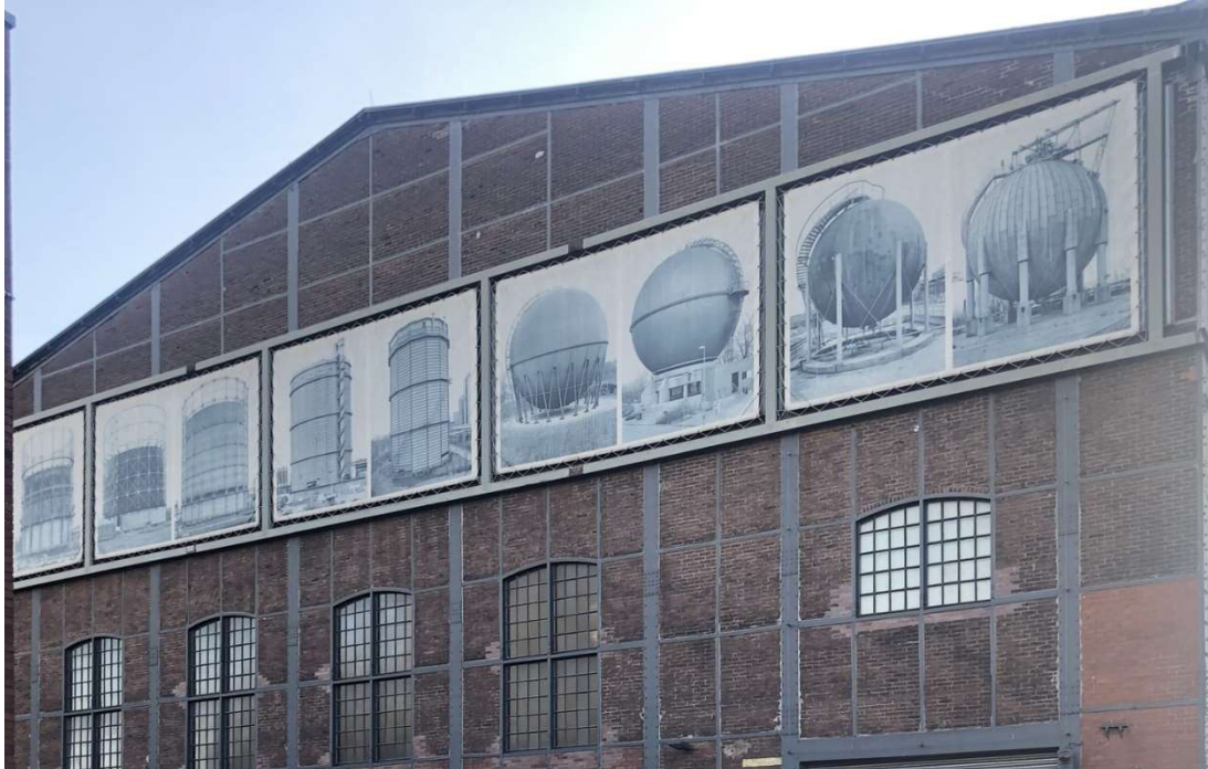
Obr. 14 – Průčelí budovy Kraftzentrale, Landschaftspark Duisburg-Nord s výstavou fotografií Hilly a Bernda Becherových, 2021. Zdroj: archiv autora
