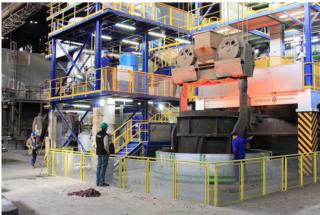
Obr. 216 – Fotografie z instalace vakuovacího zařízení VD. Zdroj: archiv Františka Sýkory
