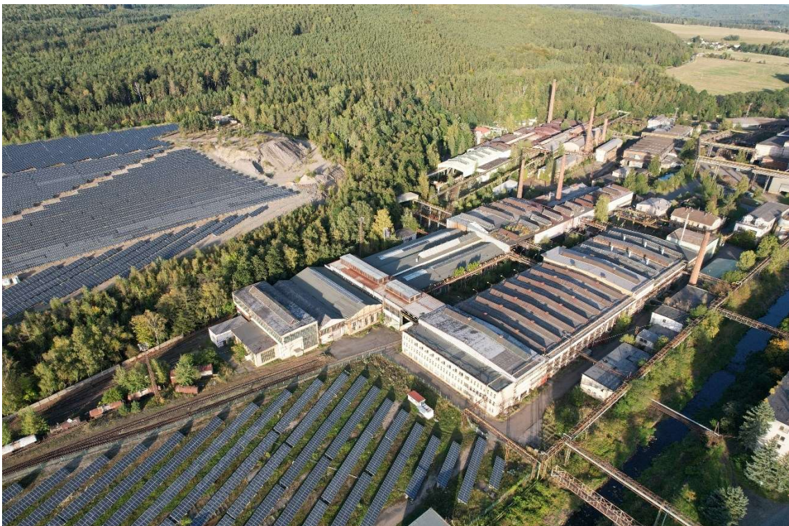
Obr. 329 – Areál železářny v Hrádku, jihozápadní pohled na severozápadní část areálu s halami – úpravní válcovny středojemné, žíhárny, tažírny a válcovny středojemné, 2021. Zdroj: archiv autora
