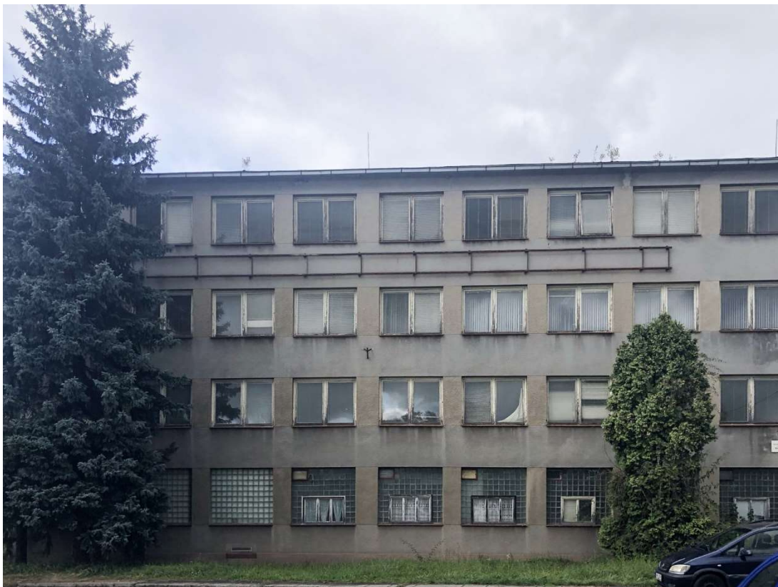
Obr. 199 – Administrativní budova ředitelství, pohled severní, 2021, Zdroj: archiv autora
