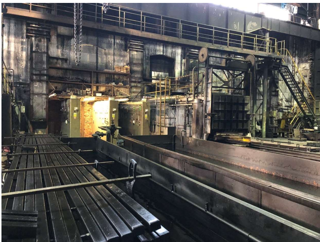
Obr. 108 – Část žihárny, interiér s technologií a ohořelými stěnami z roku 2007, 2022. Zdroj: archiv autora
