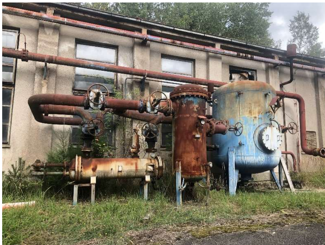
Obr. 167 – Budova kompresorovny, pohled jižní, 2021, Zdroj: archiv autora
