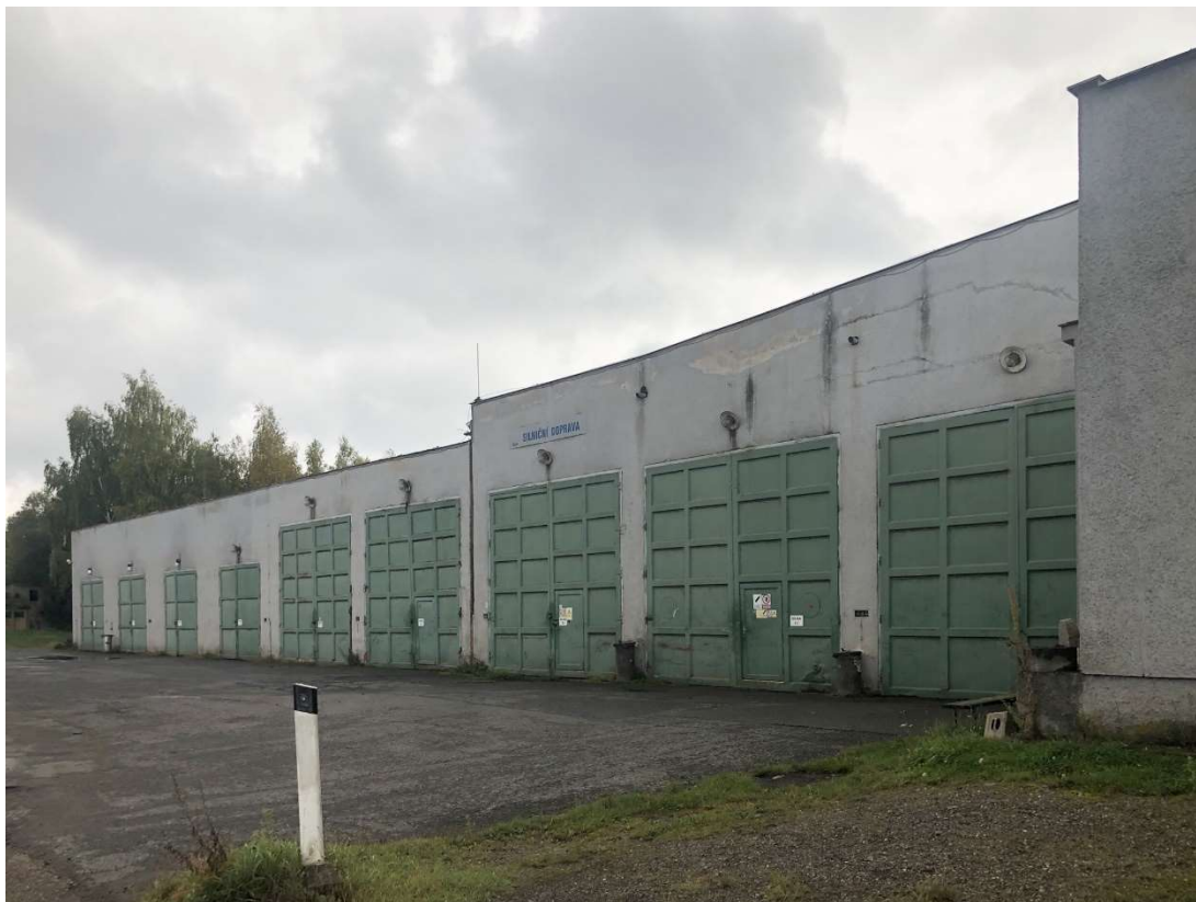
Obr. 243 – Garáže, pohled severní, 2021, Zdroj: archiv autora
