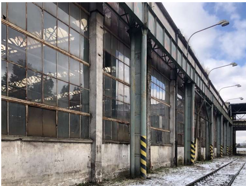
Obr. 127 – Úpravna válcovny středojemné, pohled severní, 2021, Zdroj: archiv autora
