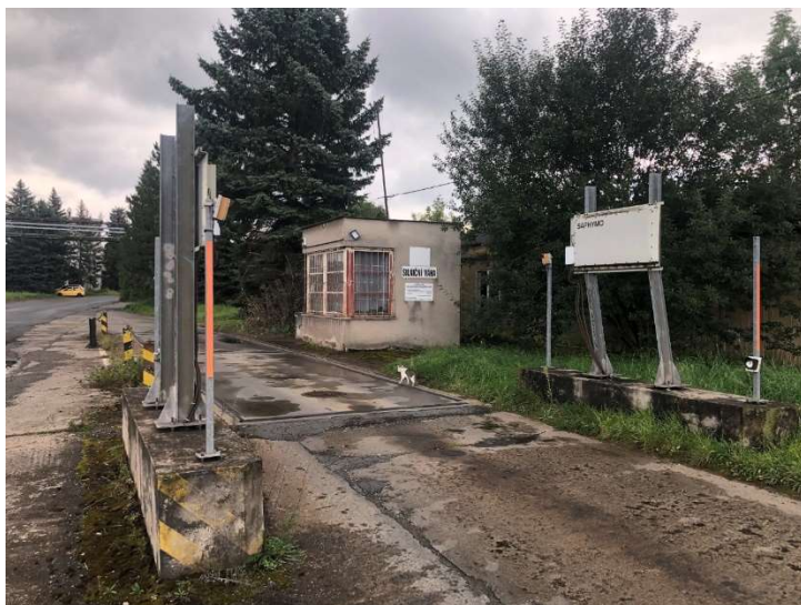
Obr. 242 – Silniční váha, pohled severozápadní, 2021, Zdroj: archiv autora
