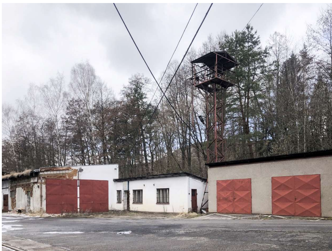
Obr. 119 – Požární zbrojnice, 2021, Zdroj: archiv autora
