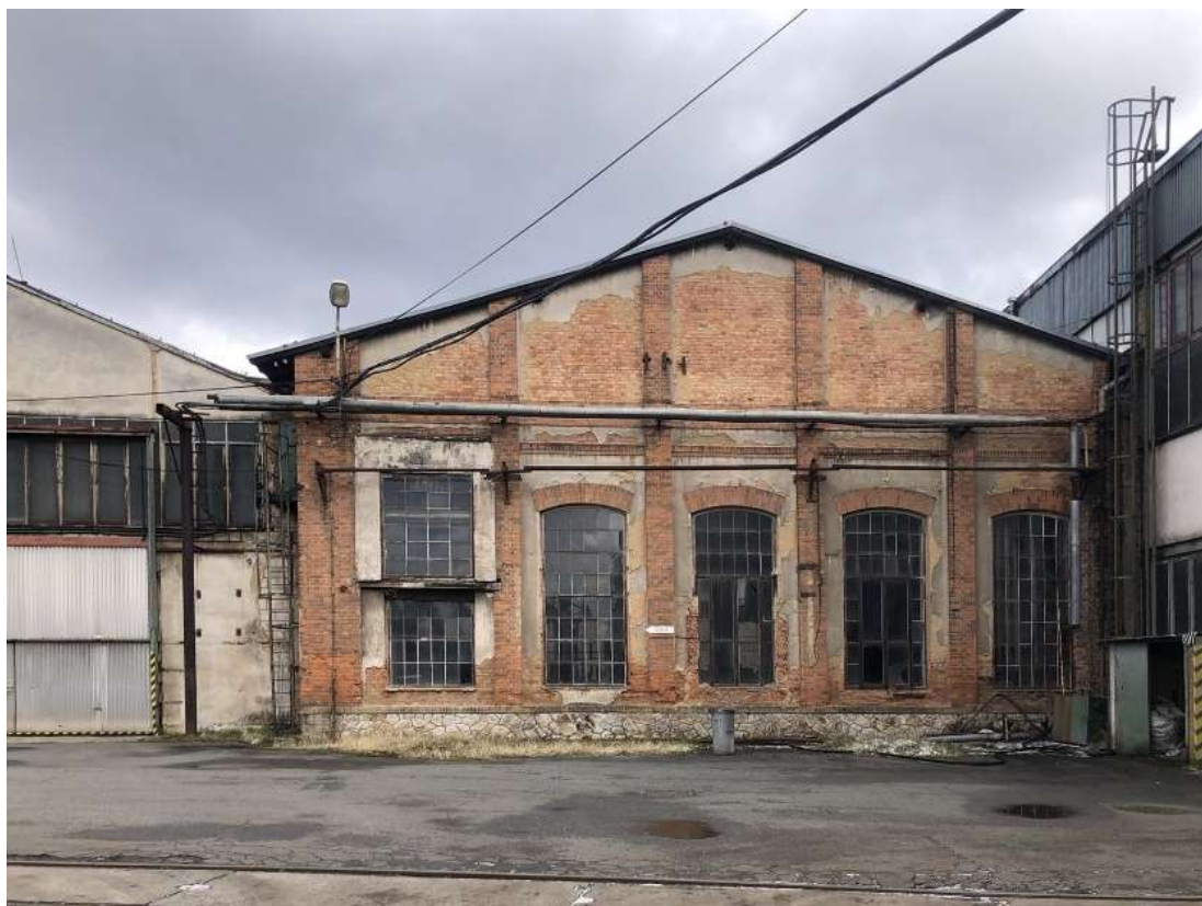
Obr. 109 – Úpravna tažírny, jižní fasáda, 2021, Zdroj: archiv autorky
