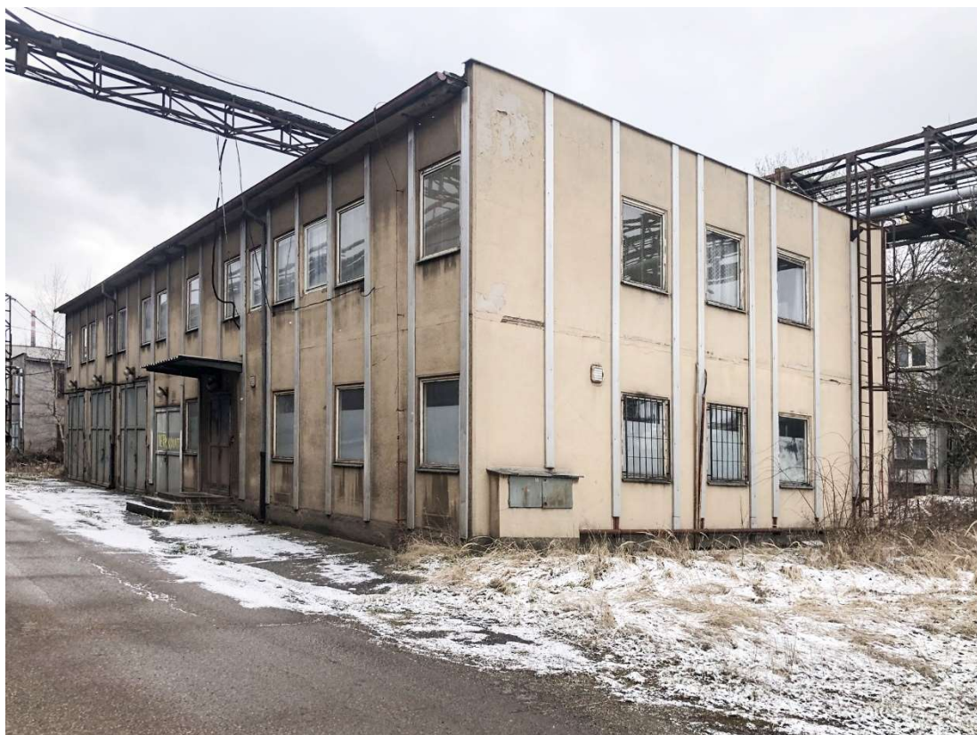
Obr. 283 – Budova administrativy válcoven, pohled severozápadní, 2021, Zdroj: archiv autora
