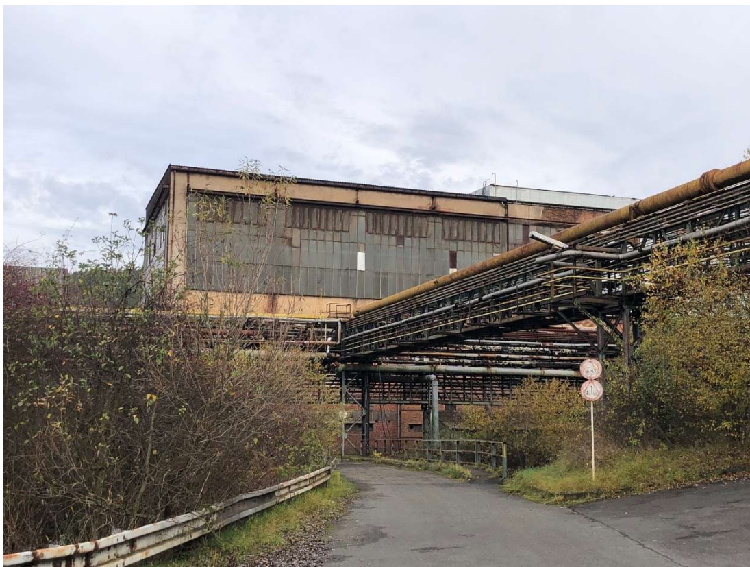
Obr. 209 – Elektroocelárna, jižní pohled, 2022, Zdroj: archiv autora
