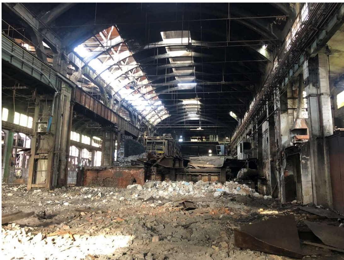
Obr. 60 – Siemens-martinská ocelárna, interiér během demolice pecí, červenec 2022. Zdroj: archiv autora
