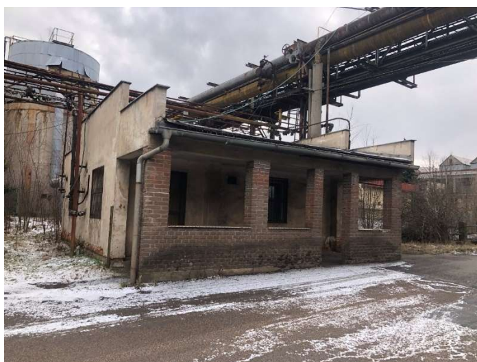
Obr. 143 – Budova bývalé vrátnice, v pozadí odkalovací věž vodního hospodářství, 2021, Zdroj: archiv autora
