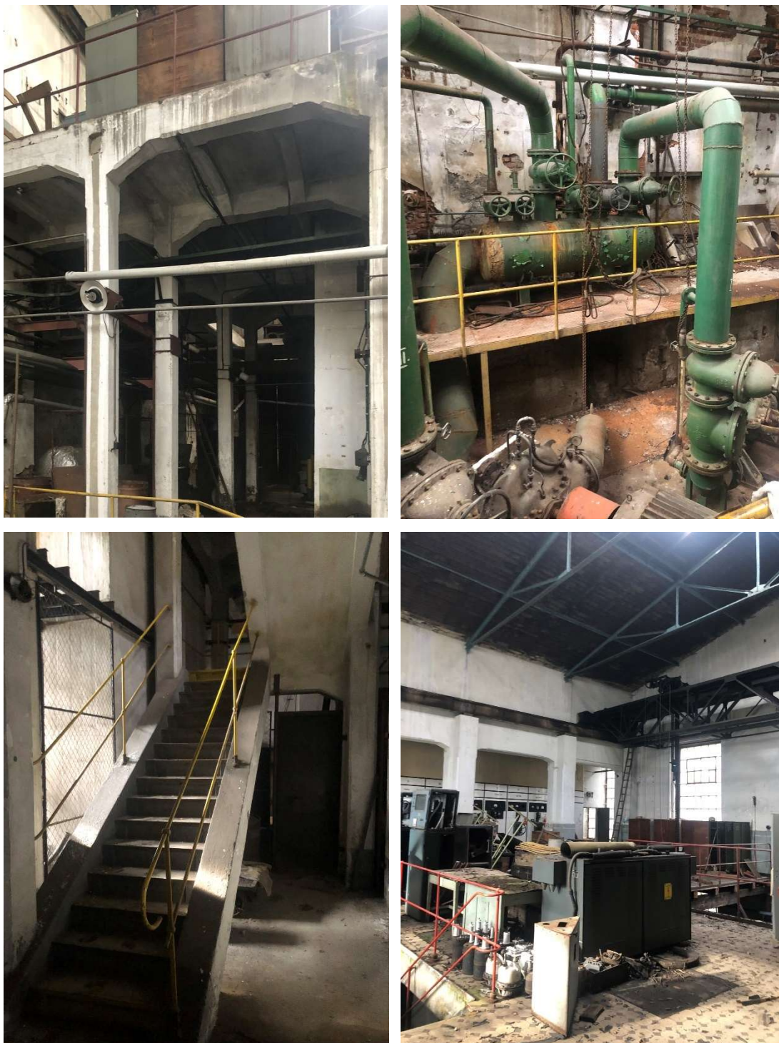
Obr. 96 – Centrála, fotografie interiéru – vlevo nahoře pohled do budovy od hlavního vstupu, vpravo nahoře technologie přečerpání vody z Padrtského potoka, vlevo dole schodiště do 2. NP, vpravo dole interiér 2. NP s jeřábovou dráhou ovládanou ručně řetězem, 2022, Zdroj: archiv autora
