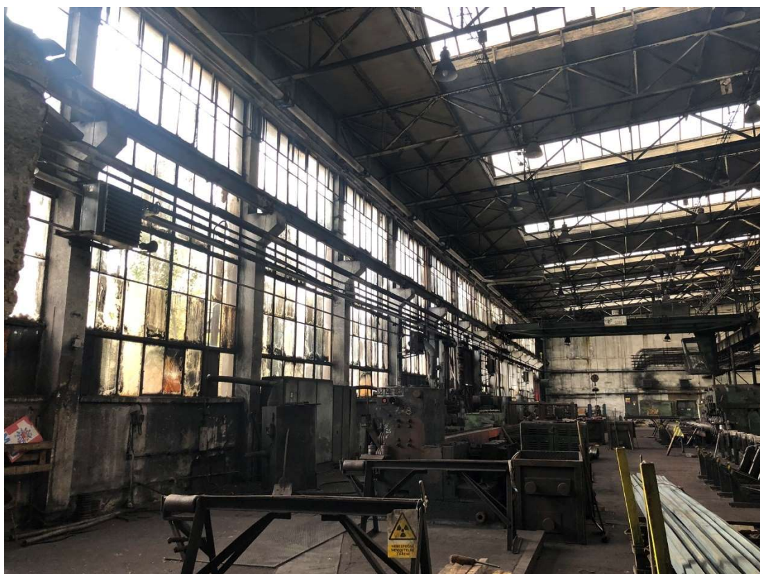
Obr. 129 – Úpravna válcovny středojemné, interiér s technologií, 2022, Zdroj: archiv autora
