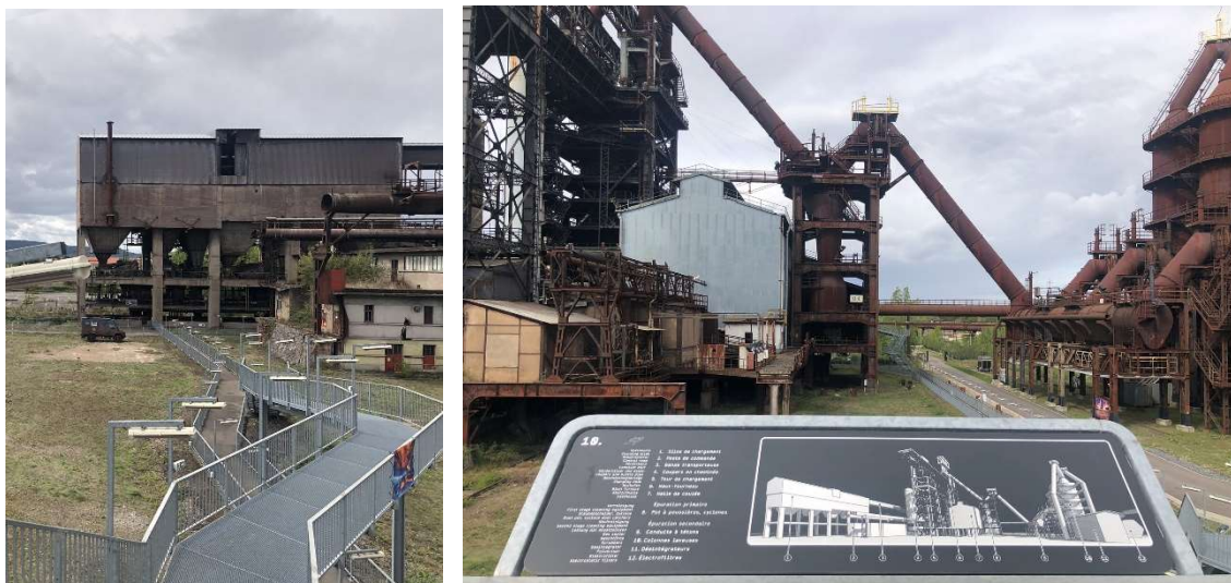
Obr. 402 – Parc du haut-fourneau U4, Uckange – dvě fotografie z vyvýšené lávky, ta vlevo zachycuje pohled na halu rudy a přísad, ta vpravo pohled na technologie u vysoké pece, 2022. Zdroj: archiv autora
