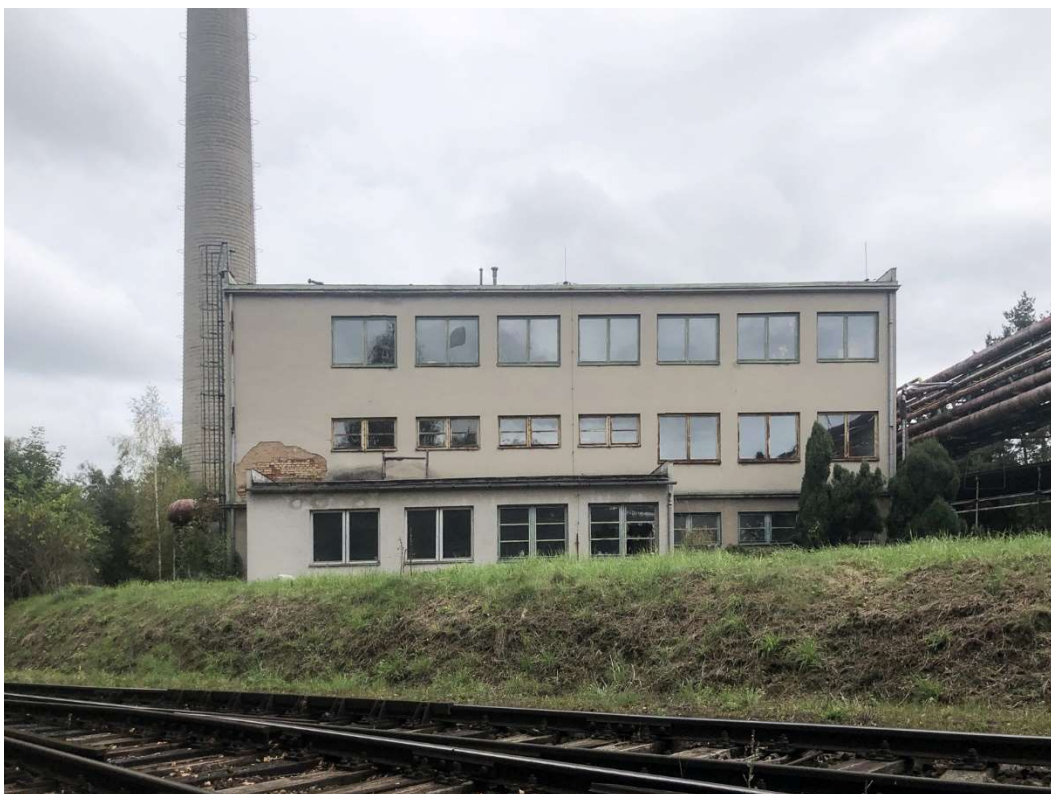
Obr. 248 – Kotelna, severozápadní pohled, 2021, Zdroj: archiv autora
