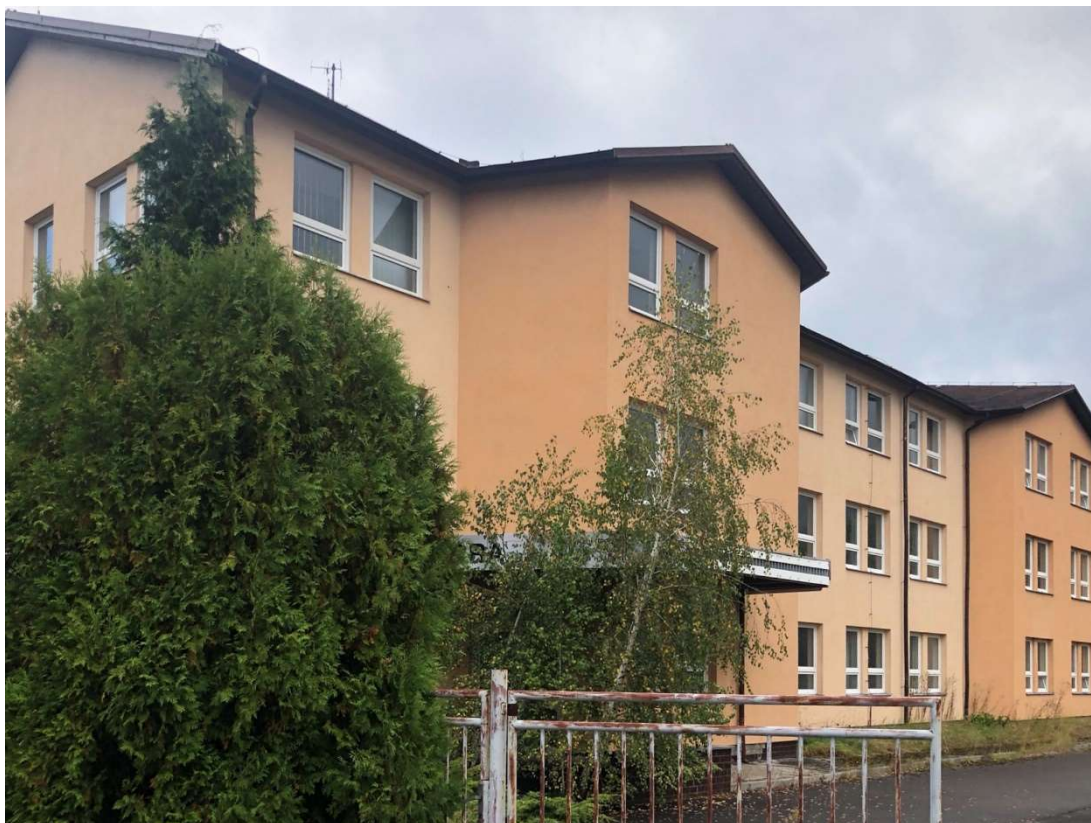
Obr. 320 – Nová administrativní budova vedení, dnes firma Ferra, pohled jihozápadní, 2021, Zdroj: archiv autora
