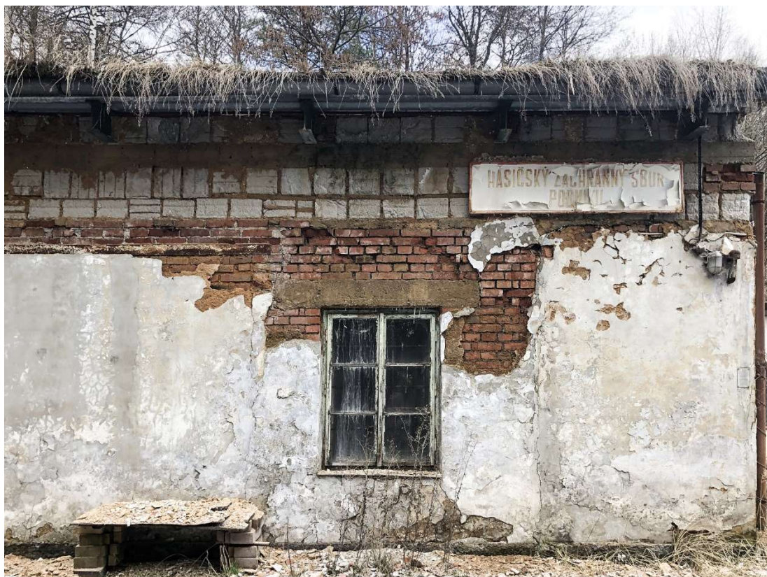
Obr. 118 – Požární zbrojnice 2021, Zdroj: archiv autora
