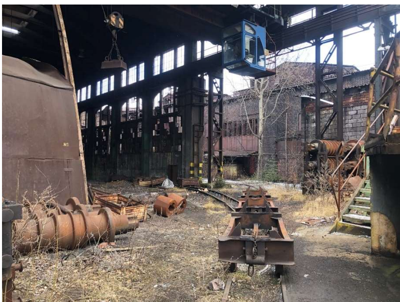
Obr. 59 – Siemens-martinská ocelárna, pohled do interiéru z východní strany, 2021. Zdroj: archiv autora
