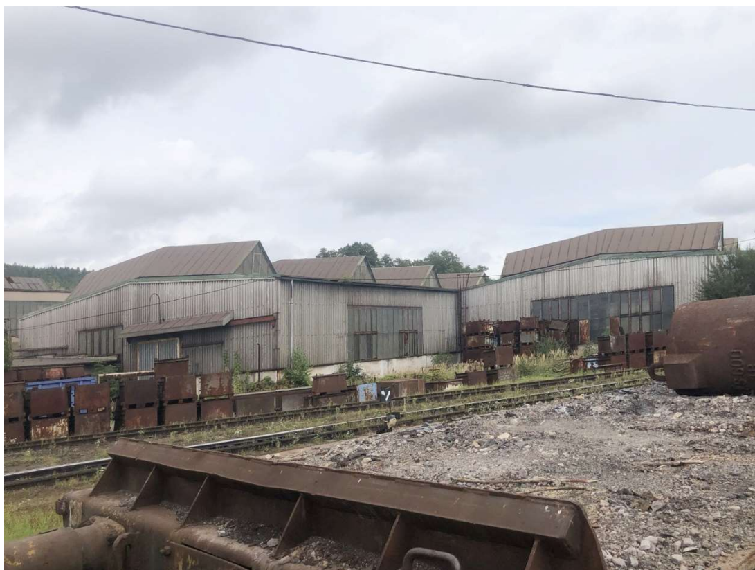
Obr. 270 – Budova skladu feroslitin, pohled jihozápadní, 2021, Zdroj: archiv autora
