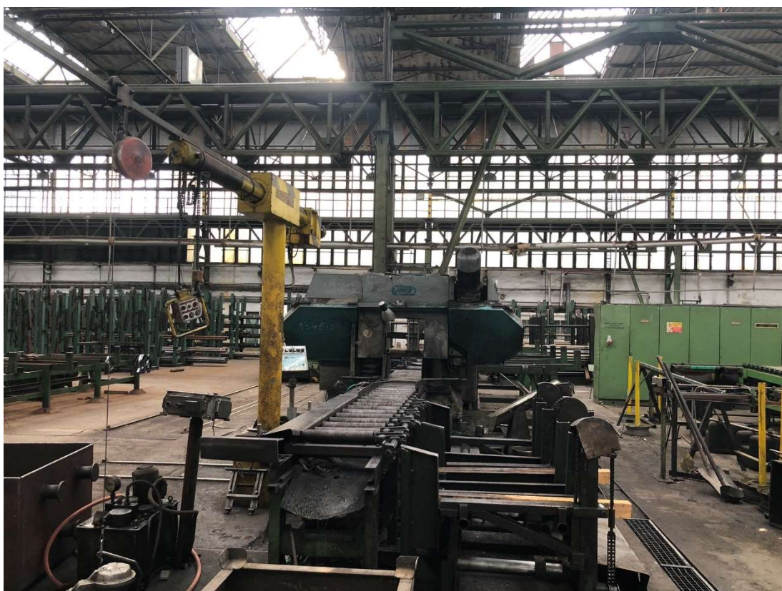
Obr. 194 – Loupárna, interiér s technologickým zařízením, 2022, Zdroj: archiv autora
