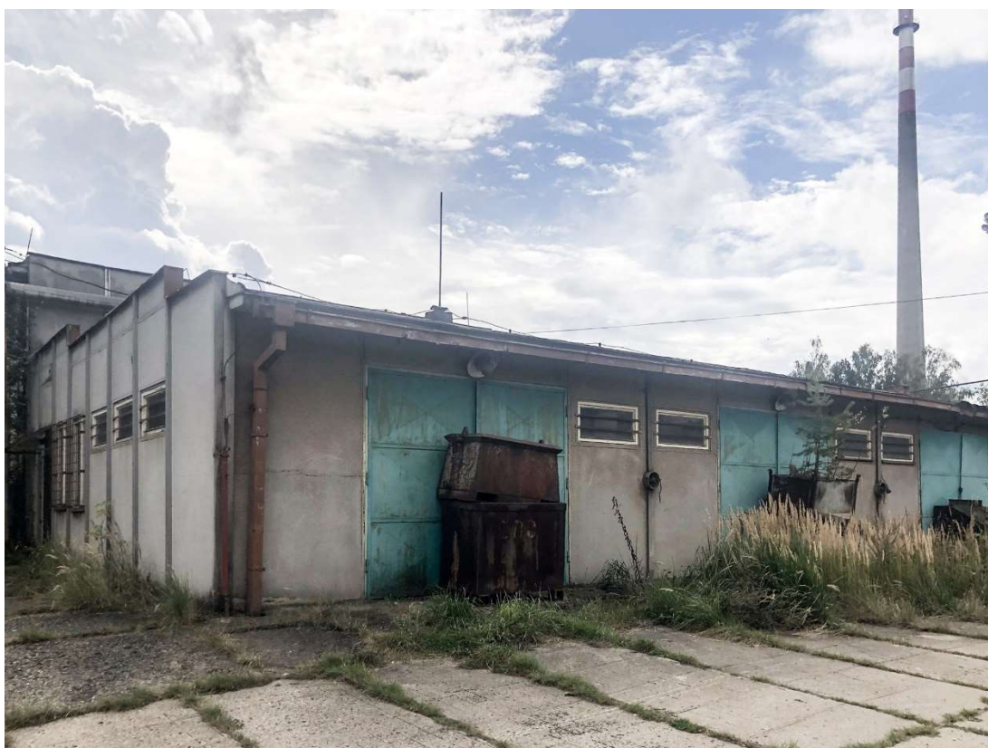
Obr. 240 – Budova stavební údržby, severovýchodní pohled, 2021, Zdroj: archiv autora
