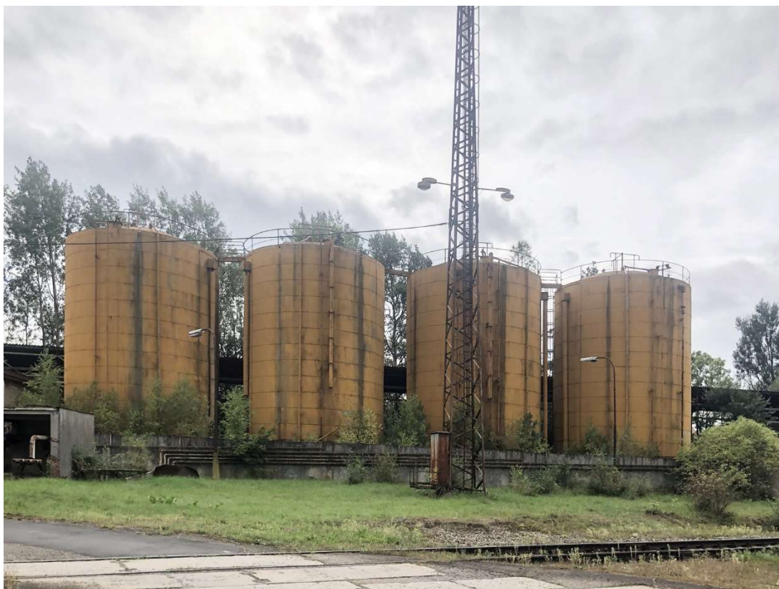
Obr. 255 – Pohled na nádrže olejového hospodářství, 2021, Zdroj: archiv autora
