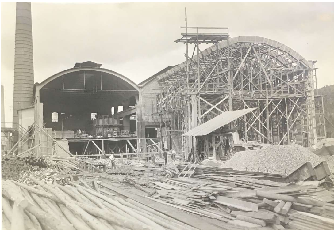
Obr. 50 – Fotografie stavby II. pece siemens-martinské ocelárny, 8.8.1916, Ing. Stanislav Bechyně DrSc., Zdroj: Státní oblastní archiv v Plzni, Fondy podnikových a hospodářských subjektů, Hrádek, 20160413084928_3a.
