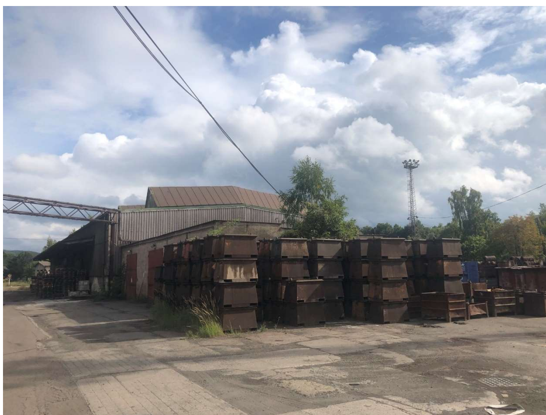
Obr. 271 – Budova skladu feroslitin a v popředí garáže, pohled severozápadní, 2021, Zdroj: archiv autora
