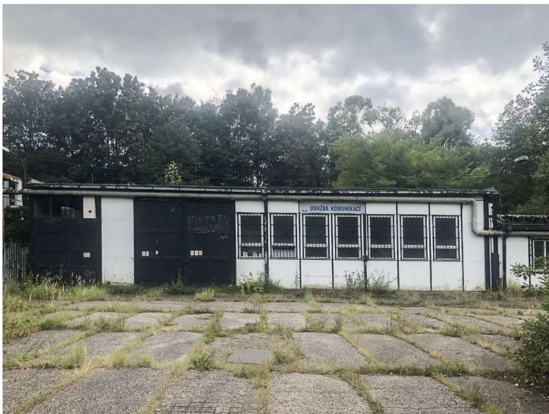
Obr. 257 – Budova údržby dráhy a komunikací, severní pohled 2021, Zdroj: archiv autora
