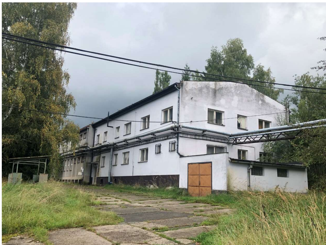
Obr. 197 – Budova odborů a laboratoří řízení jakosti, pohled severozápadní, 2021, Zdroj: archiv autora
