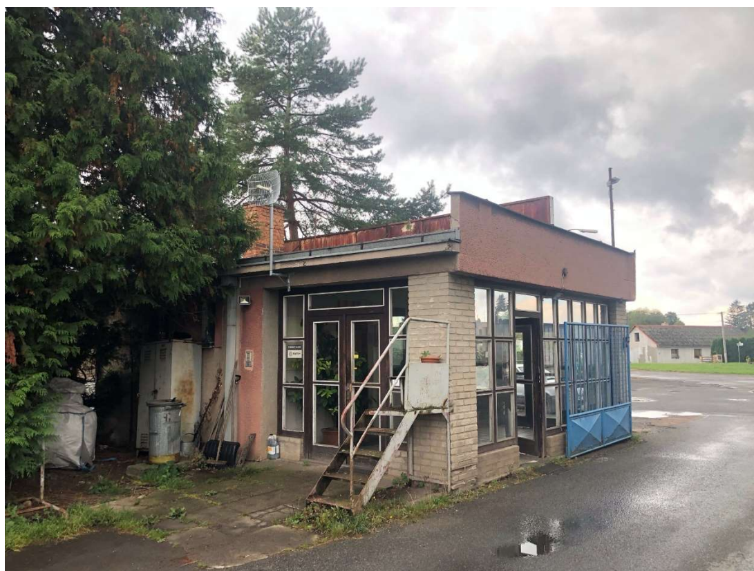
Obr. 265 – Budova vrátnice č. 2, pohled východní, uvnitř areálu, 2021, Zdroj: archiv autora
