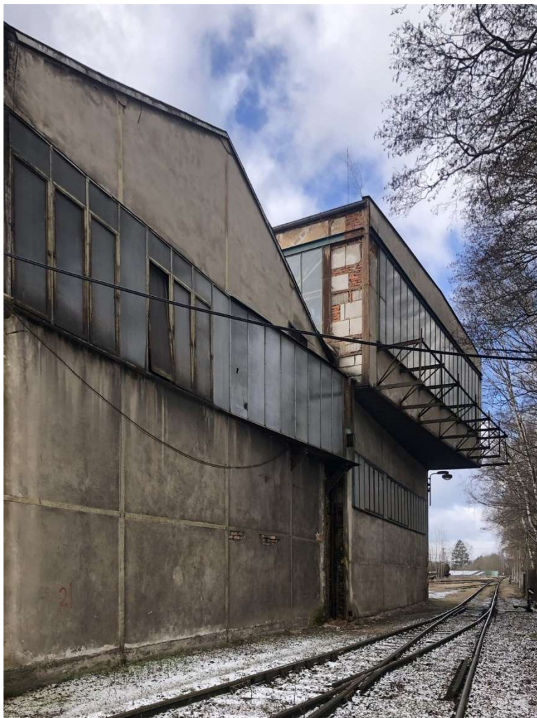
Obr. 201 – Sklad tažírny a sklad lesklého materiálu, severní fasáda, 2021, Zdroj: archiv autorky
