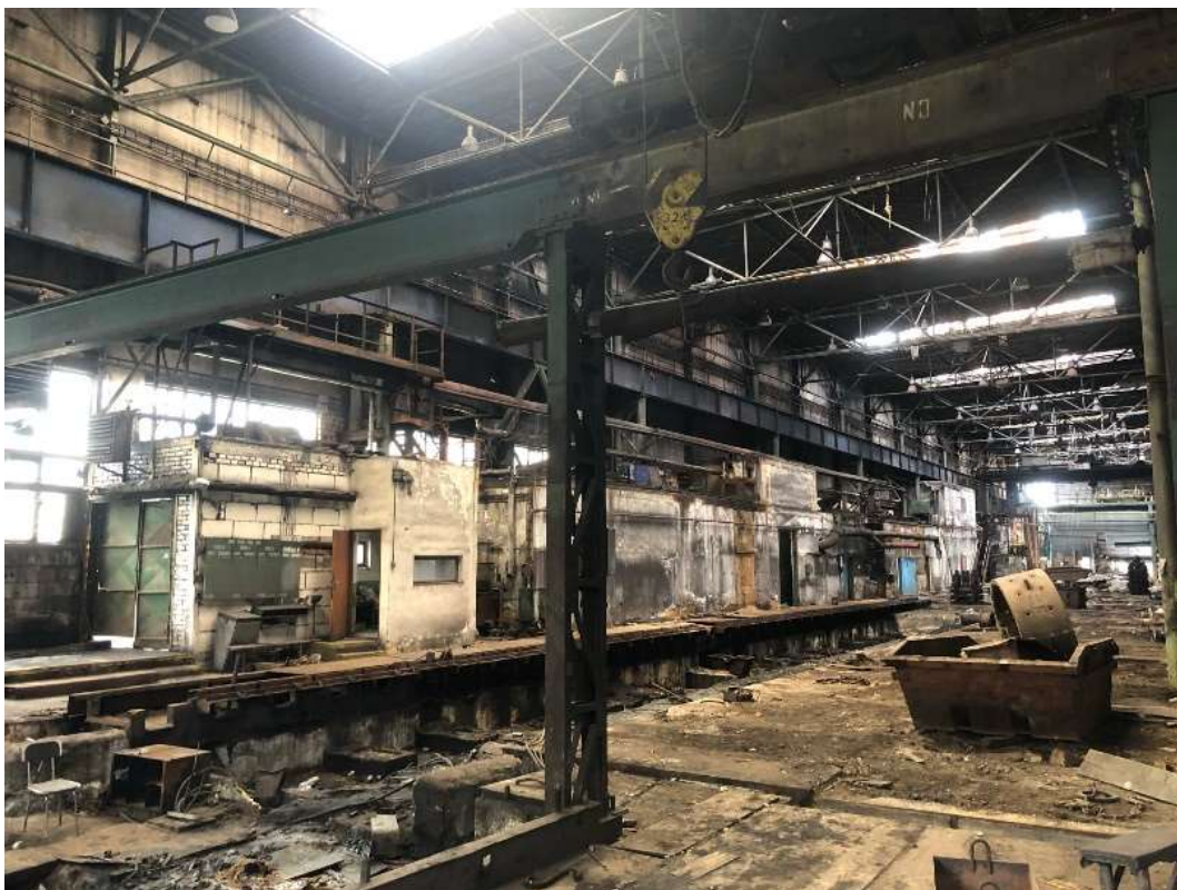
Obr. 48 – Středojemná válcovna, interiér, 2021, Zdroj: archiv autorky
