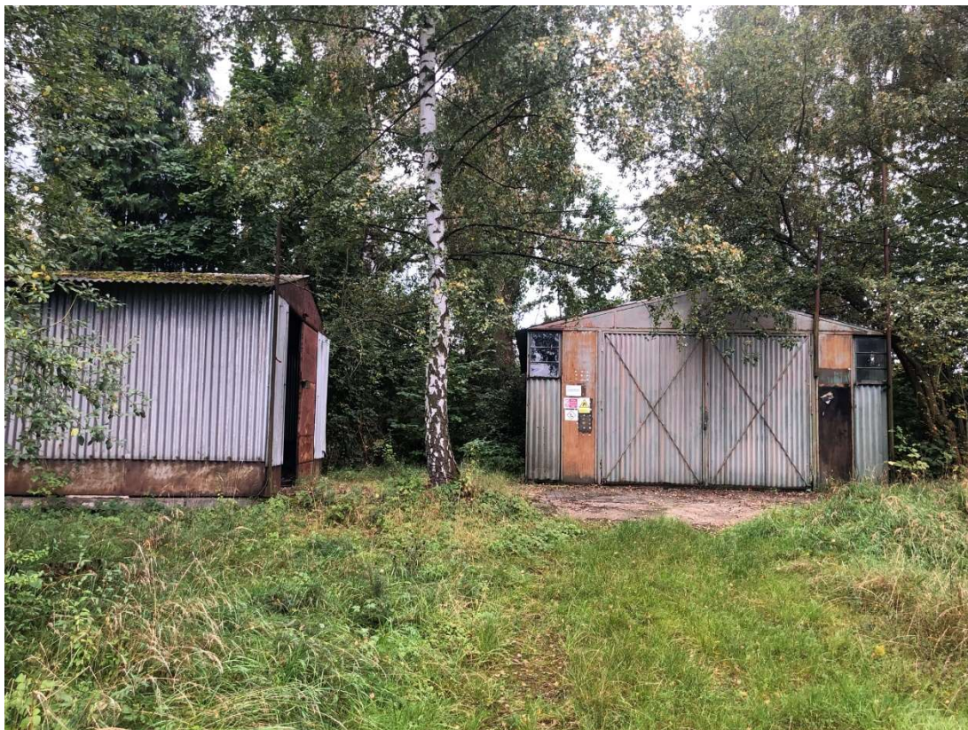
Obr. 292 – Vlevo sklad a vpravo sklad nebezpečných odpadů, severní pohled, 2021, Zdroj: archiv autora
