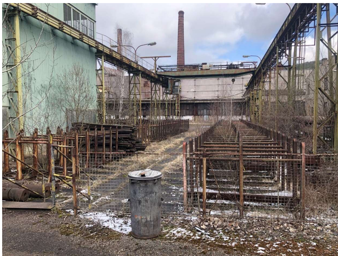
Obr. 153 – Prostor před plynovou žihárnou, 2021, Zdroj: archiv autora
