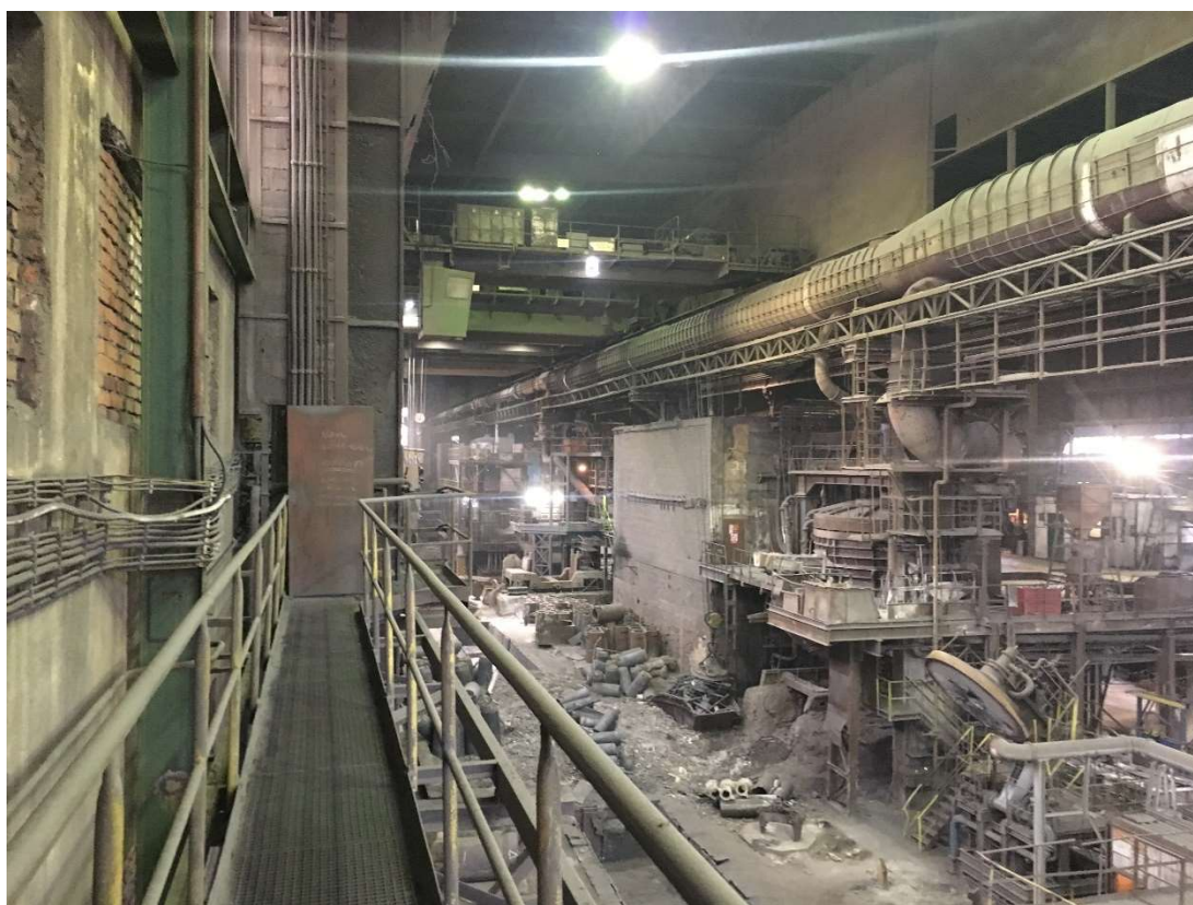
Obr. 213 – Elektroocelárna, interiér výrobní haly, kontrolní lávka, ze které je přístup do kanceláří, 2018, Zdroj: archiv autora
