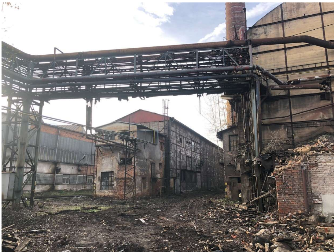
Obr. 73 – Sklad elektromotorů, severovýchodní pohled, 2022, Zdroj: archiv autora
