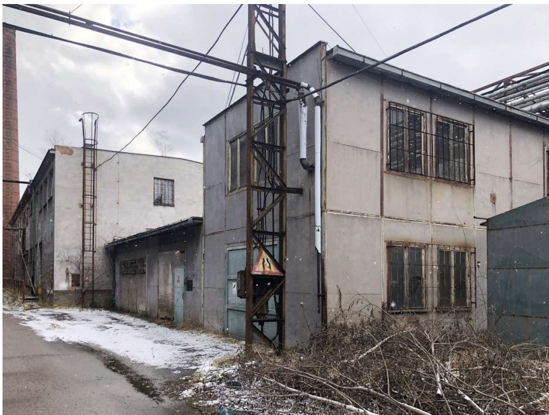
Obr. 261 – Dílny úpravny válcovny VS a VJ, pohled severozápadní, 2021, Zdroj: archiv autora
