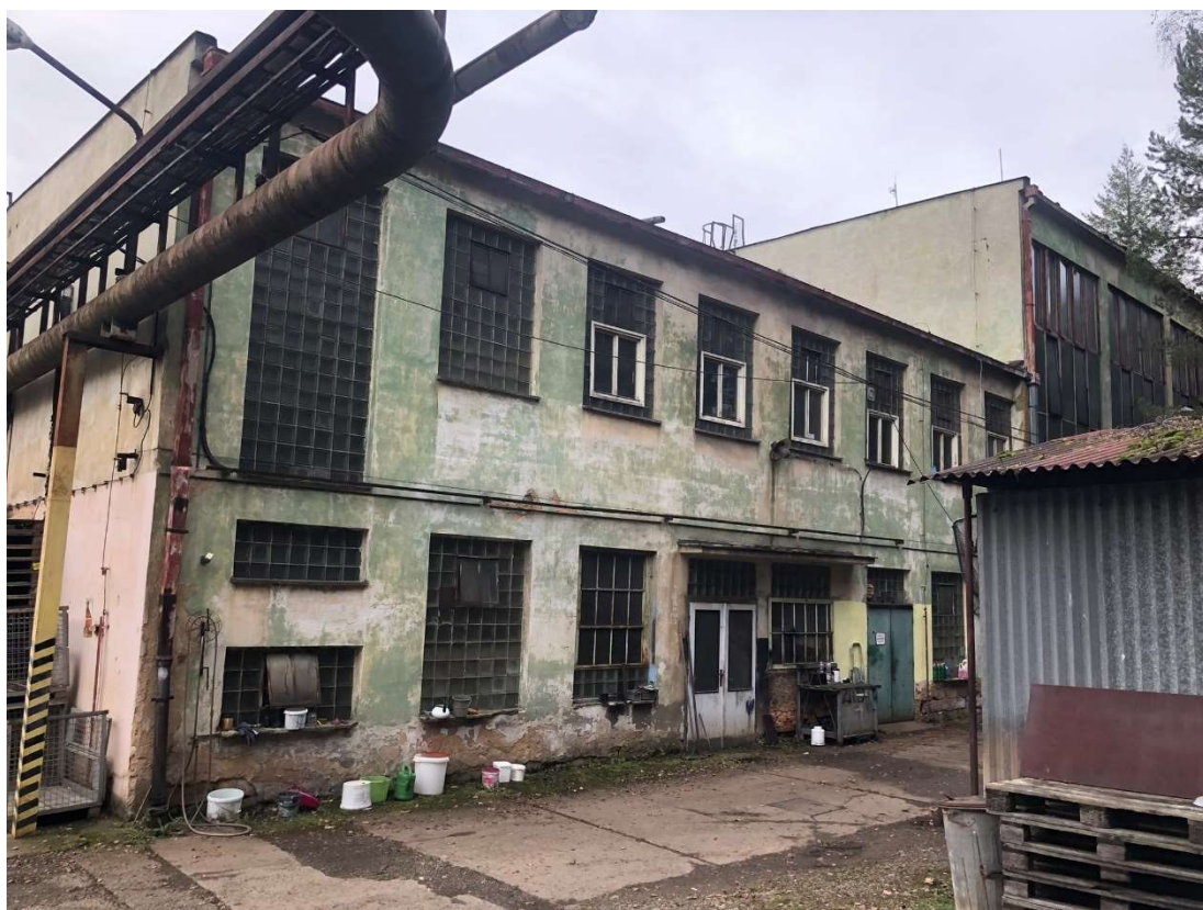
Obr. 162 – Budova kyslíkárny – část s dílnou a sociálním zařízením, pohled severní, 2022, Zdroj: archiv autora
