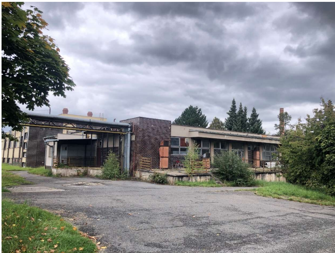
Obr. 318 – Budova jídelny, pohled severovýchodní, 2021, Zdroj: archiv autora
