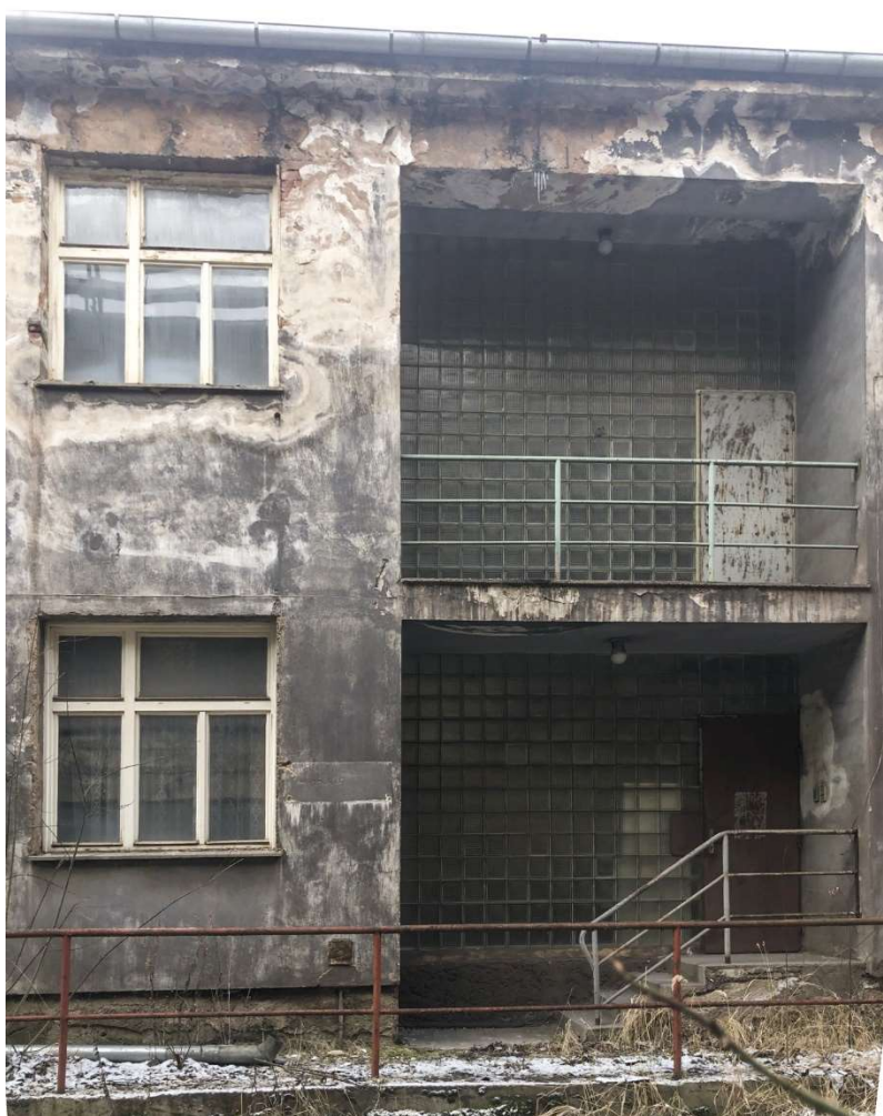
Obr. 159 – Budova vývoje a automatizace, detail fasády, 2021, Zdroj: archiv autora
