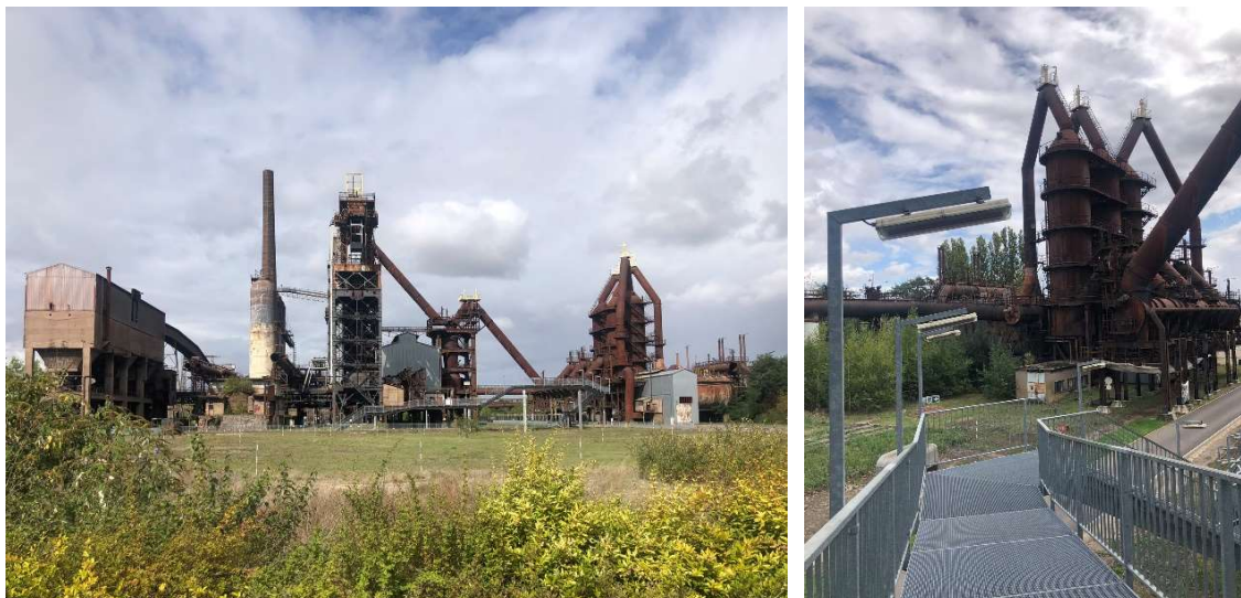
Obr. 400 – Parc du haut-fourneau U4, Uckange – vlevo pohled na panorama areálu kolem vysoké pece č. 4; vpravo fotografie z vyvýšené lávky na technologické zařízení, 2022. Zdroj: archiv autora
