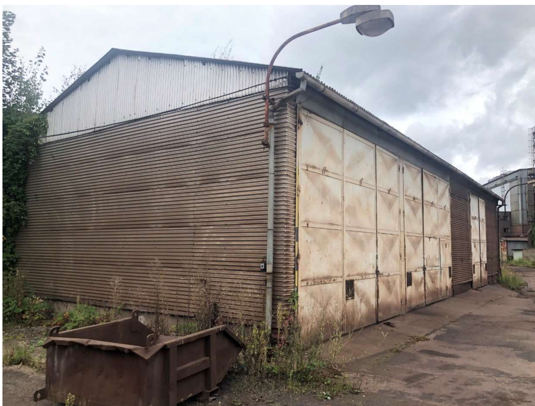
Obr. 300 – Garáže u elektroocelárny, severovýchodní pohled, 2021, Zdroj: archiv autora
