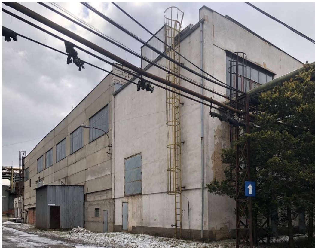
Obr. 294 – Budova vodního hospodářství, 2021, Zdroj: archiv autora
