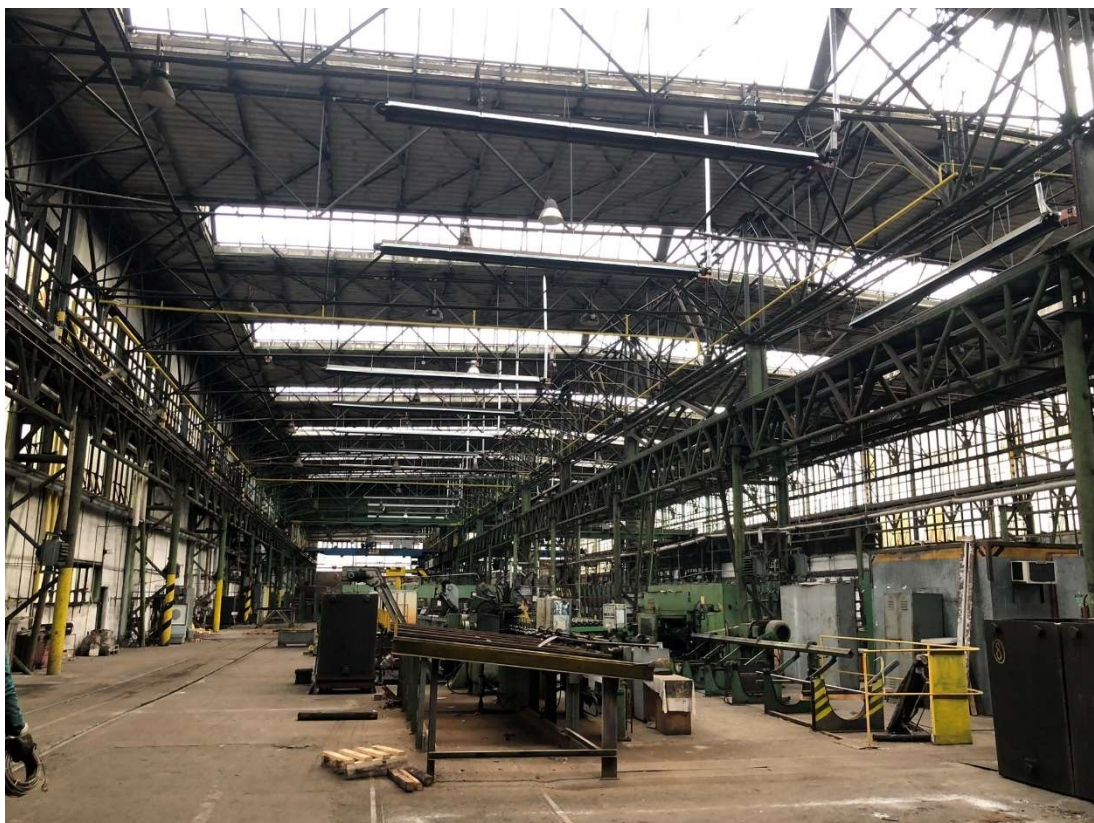
Obr. 193 – Loupárna, interiér s technologickým zařízením, 2022, Zdroj: archiv autora
