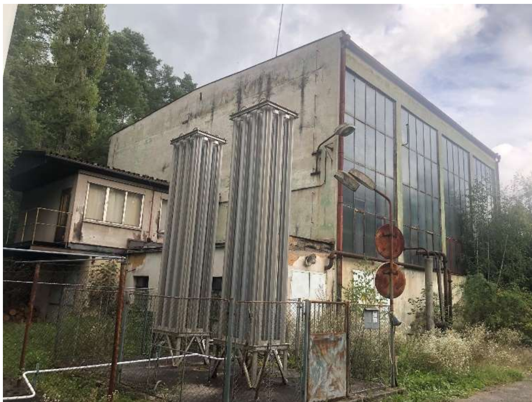
Obr. 161 – Budova kyslíkárny, pohled jihozápadní, 2021, Zdroj: archiv autora
