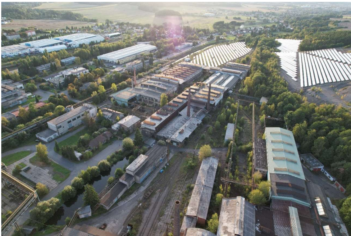
Obr. 332 – Areál železářny v Hrádku, severovýchodní pohled na střed areálu s vodní nádrží vlevo dole na fotografii, ve středu fotografie se nachází haly – válcovny střeďojemné, tažírny, žihárny a úpravny válcovny střeďojemné, vpravo na fotografii je zachycena část expedice haly hrubé válcovny, 2021. Zdroj: archiv autora
