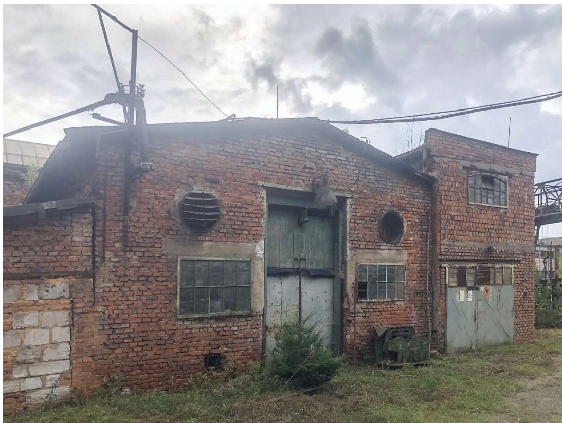
Obr. 313 – Dílna železniční dopravy, pohled severní, 2021, Zdroj: archiv autora
