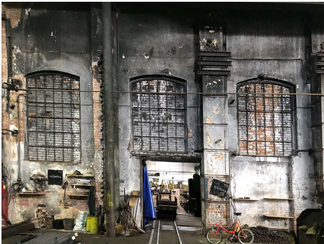
Obr. 107 – Část žihárny, pohled do tažírny, 2022. Zdroj: archiv autora
