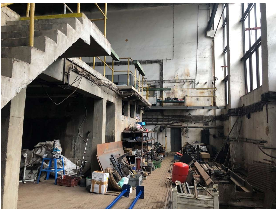
Obr. 164 – Budova kyslíkárny, interiér 1.NP – pohled na východní stěnu, 2022, Zdroj: archiv autora
