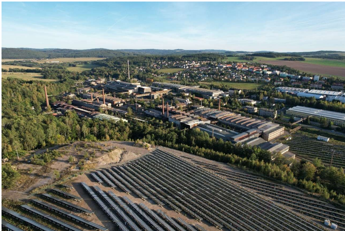
Obr. 327 – Areál železářny v Hrádku, severozápadní pohled na celý areál a v pozadí město Hrádek, 2021. Zdroj: archiv autora
