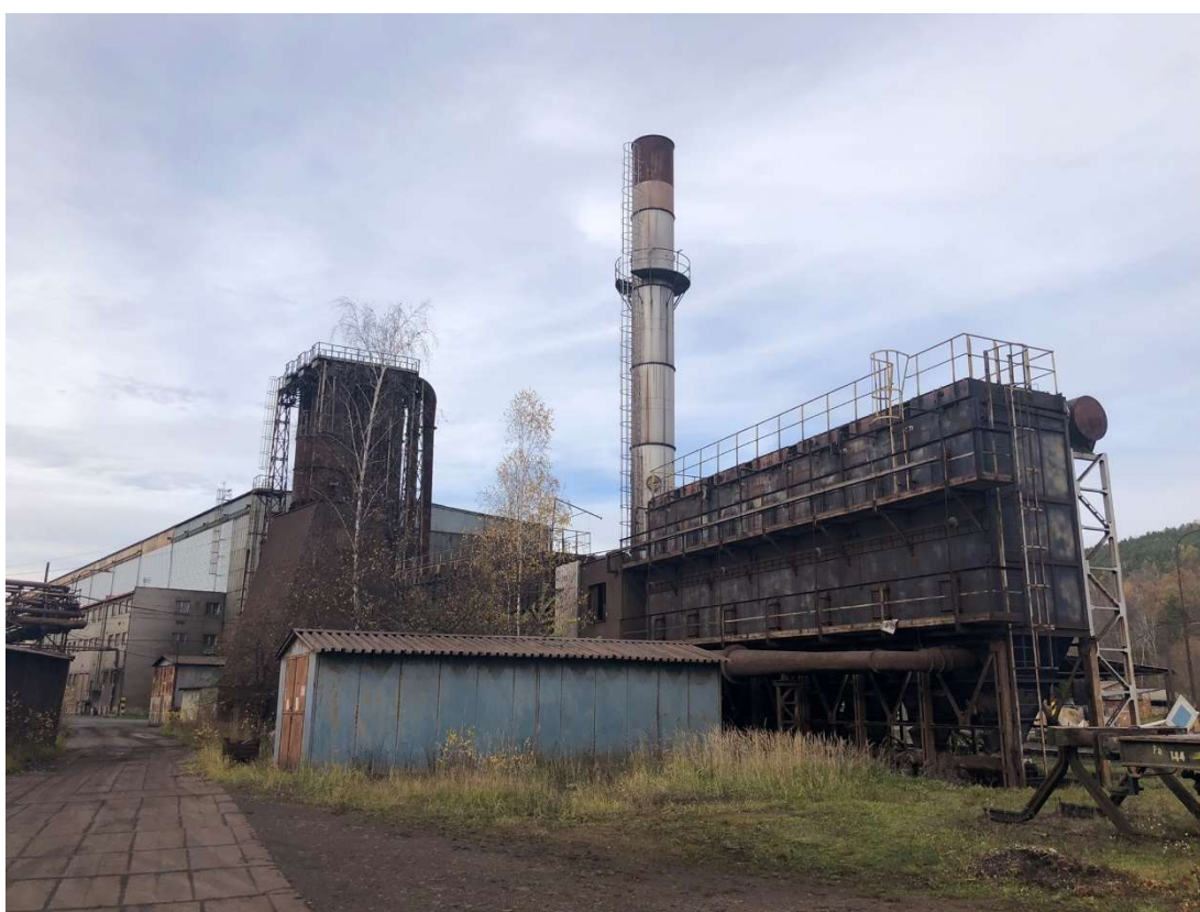
Obr. 304 – Odsávání elektroocelárny, 2022, Zdroj: archiv autora
