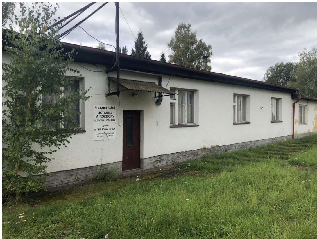
Obr. 226 – Administrativní budova účtárny a personální, pohled severní, 2021, Zdroj: archiv autora
