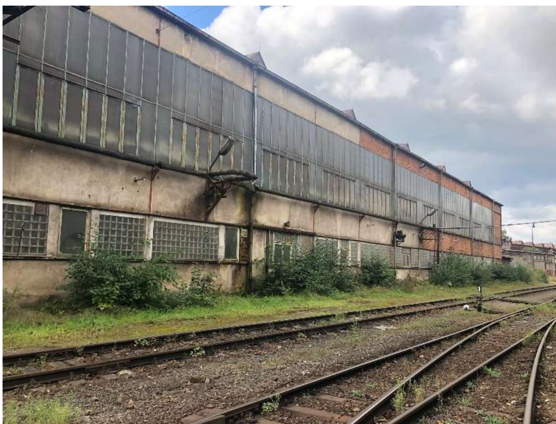
Obr. 80 – Mechanické dílny, severní pohled, 2021, Zdroj: archiv autora
