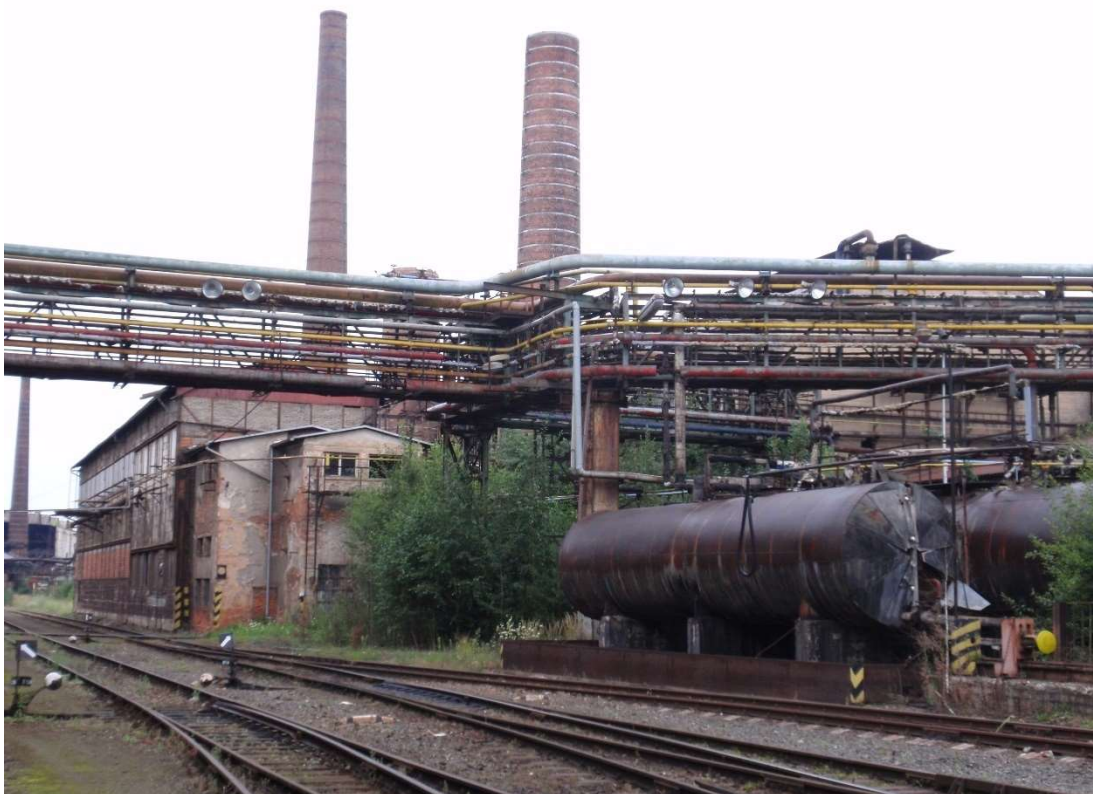
Obr. 54 – Siemens-martinská ocelárna, východní pohled, 2016. Zdroj: archiv autora
