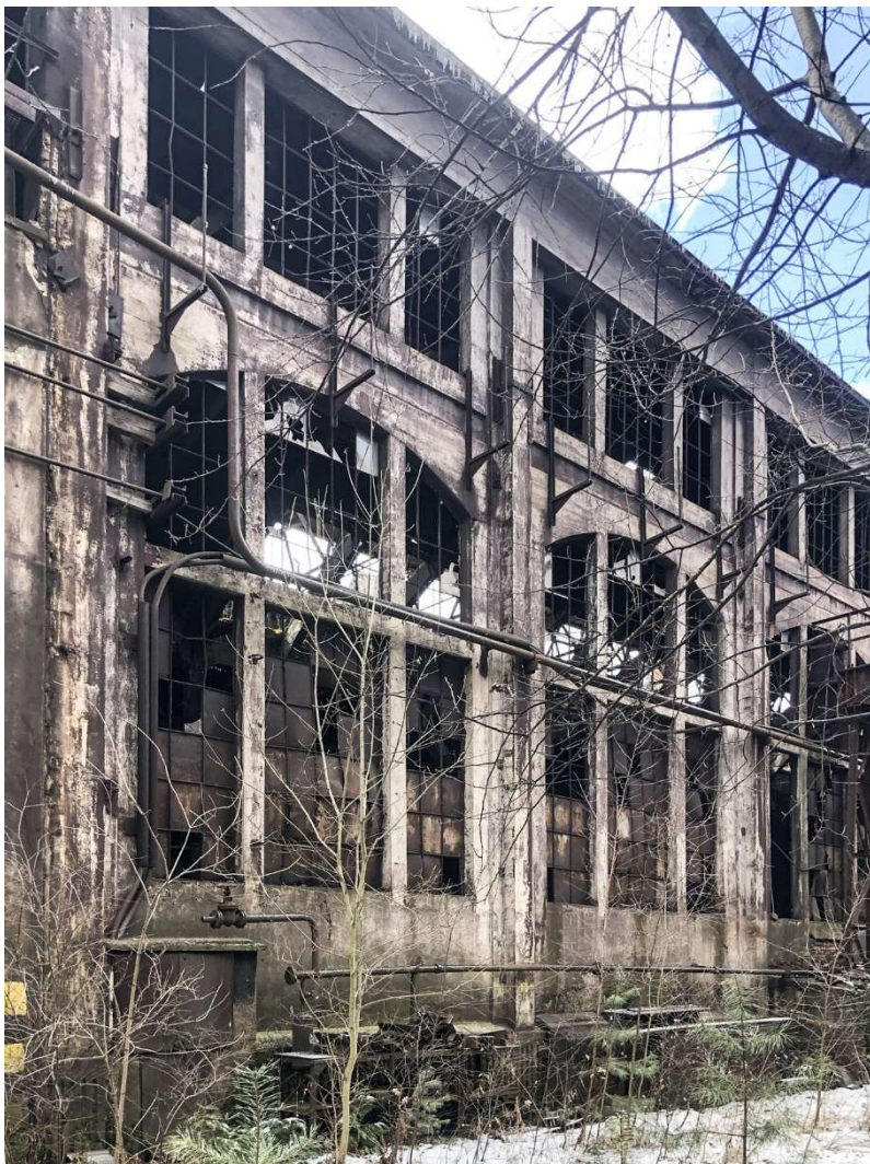
Obr. 58 – Siemens-martinská ocelárna, jižní fasáda, 2021, Zdroj: archiv autora
