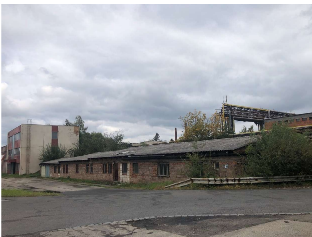
Obr. 151 – Objekt zařízení „stavenišť“, severovýchodní pohled, 2021, Zdroj: archiv autora
