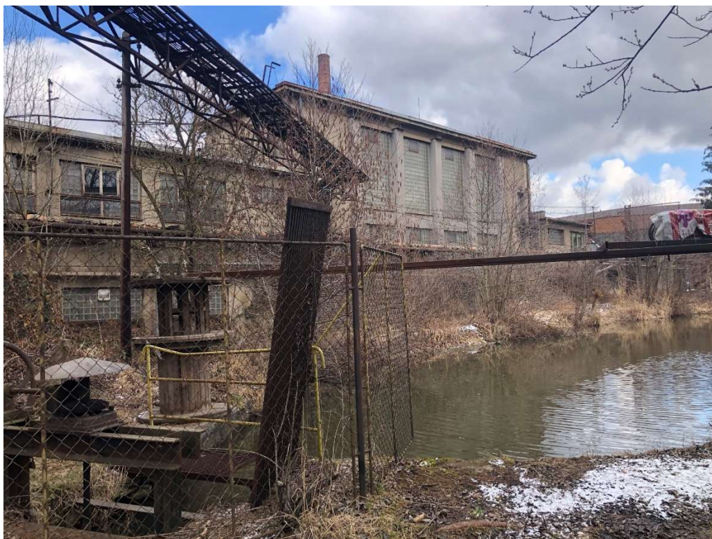
Obr. 185 – Vodní nádrž s budovou traťa, jižní pohled, 2021, Zdroj: archiv autora
