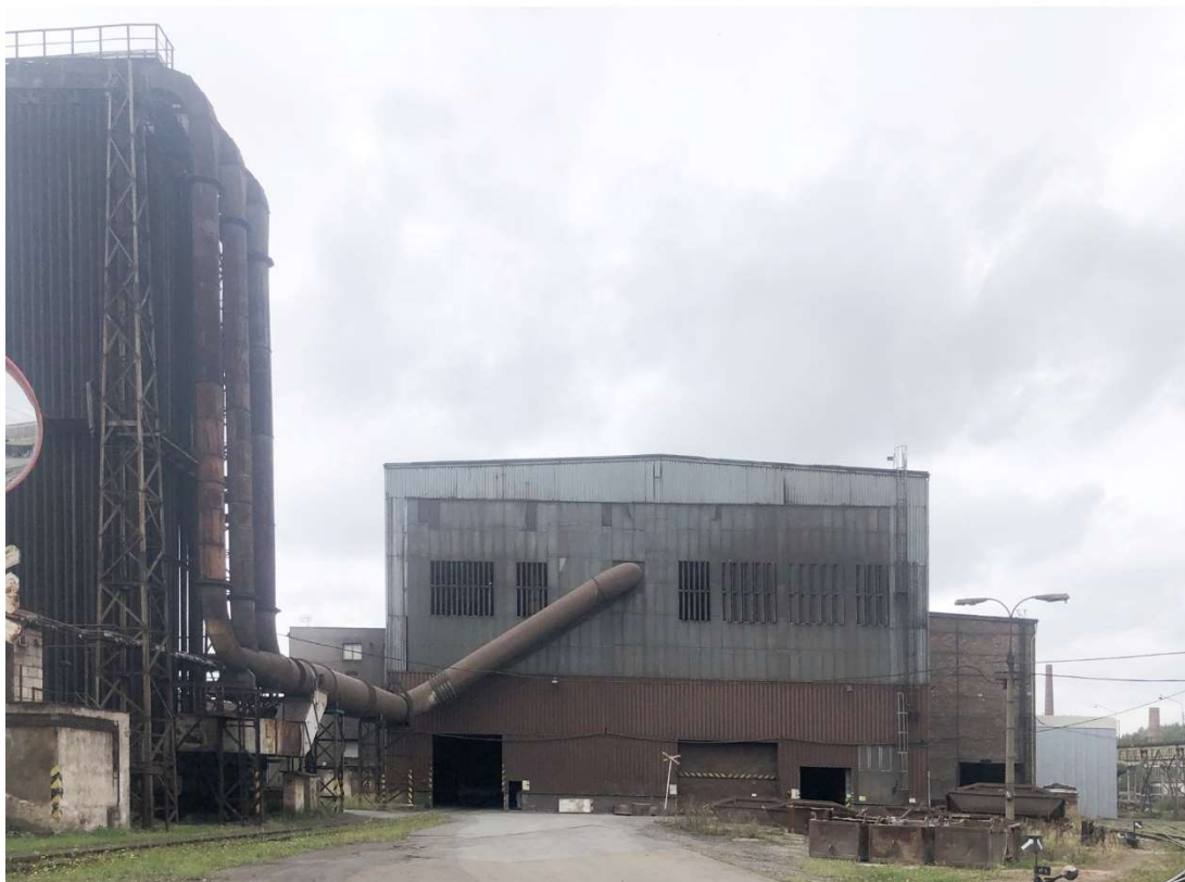
Obr. 303 – Napojení sacího potrubí na elektroocelárnu, východní fasáda ocelárny, 2021, Zdroj: archiv autora
