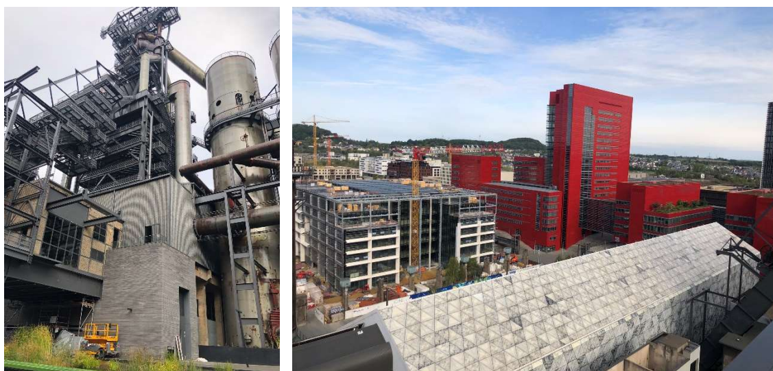
Obr. 404 – Regenerovaná oblast Belval, Esch-Sur-Alzette – vlevo pohled na vysokou pec; vpravo pohled na červenou budovu Dexia (dnes BIL) a v popředí haly Möllerei s knihovnou focenou z vysoké pece, 2022. Zdroj: archiv autora
