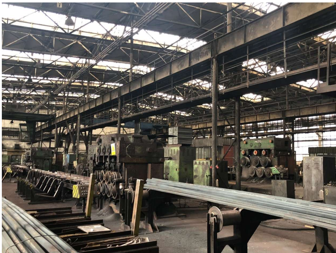
Obr. 128 – Úpravna válcovny středojemné, interiér s technologií, 2022, Zdroj: archiv autora
