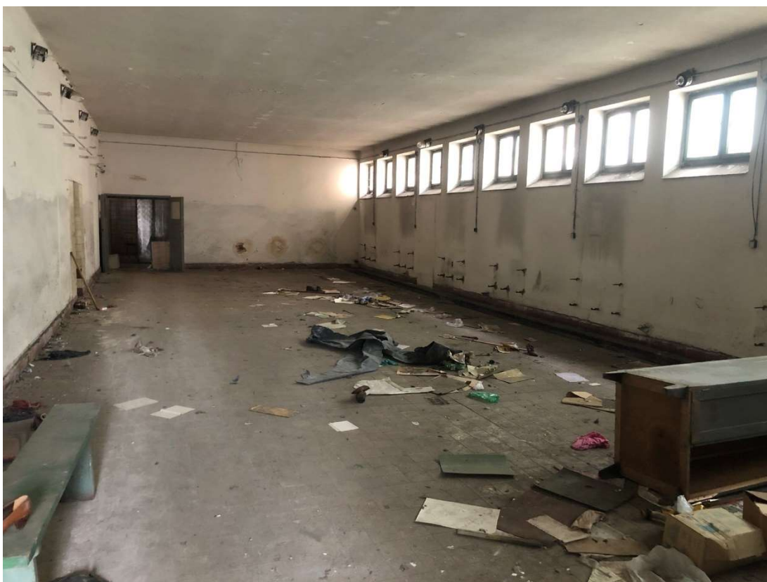
Obr. 282 – Sociální budova úpravny VS a VJ, interiér, 2021, Zdroj: archiv autora
