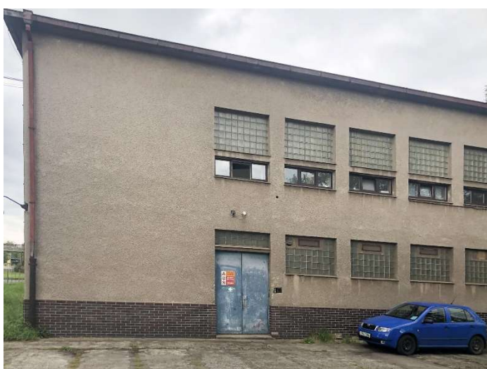
Obr. 149 – Budova trafostanice u vstupu, pohled východní, 2021, Zdroj: archiv autora
