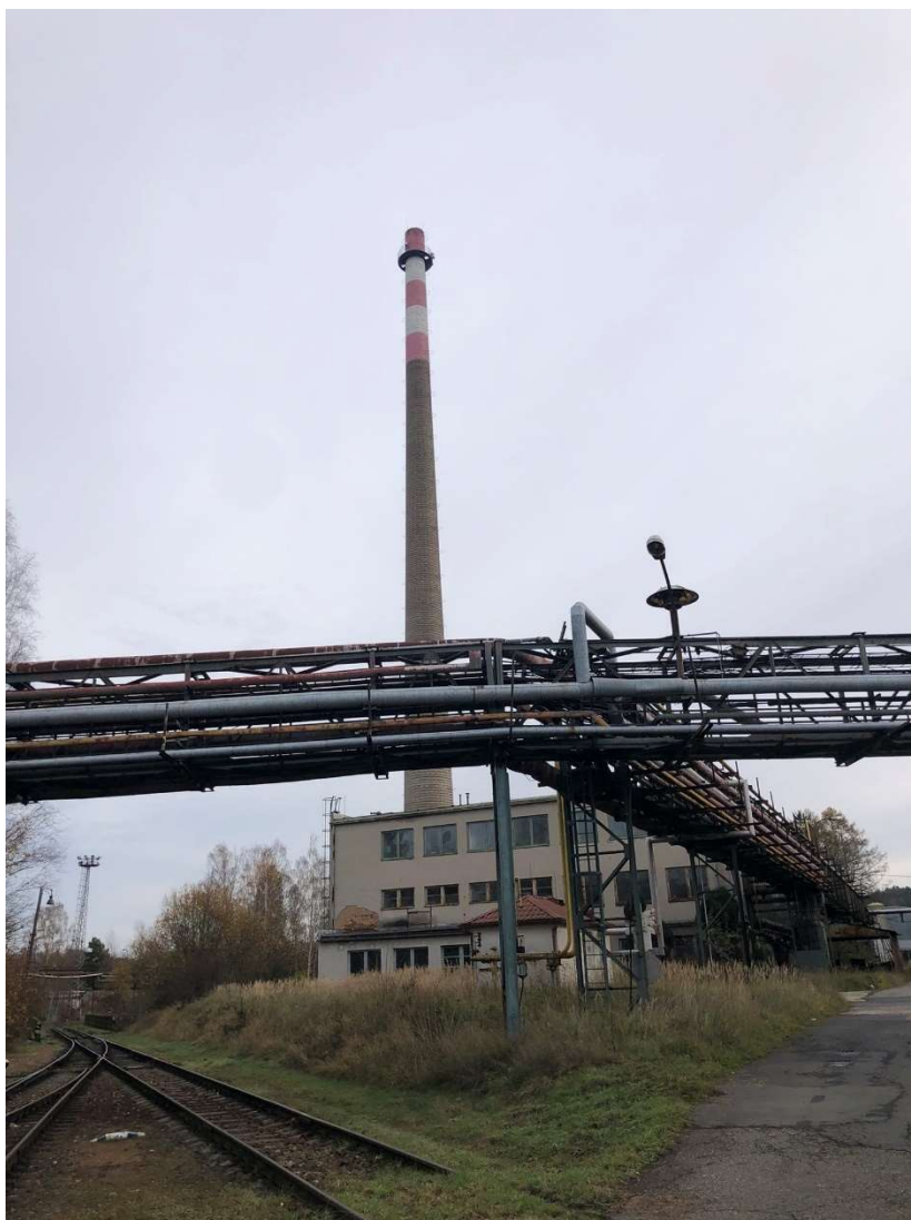
Obr. 249 – Kotelna, severozápadní pohled, 2022, Zdroj: archiv autora
