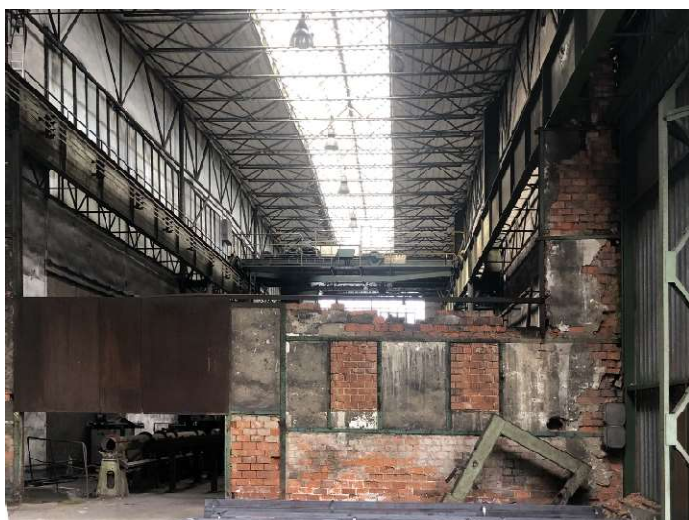
Obr. 178 – Sklad lisovny, střední část mezi lisovnou a loupárnou, interiér, 2021, Zdroj: archiv autora
