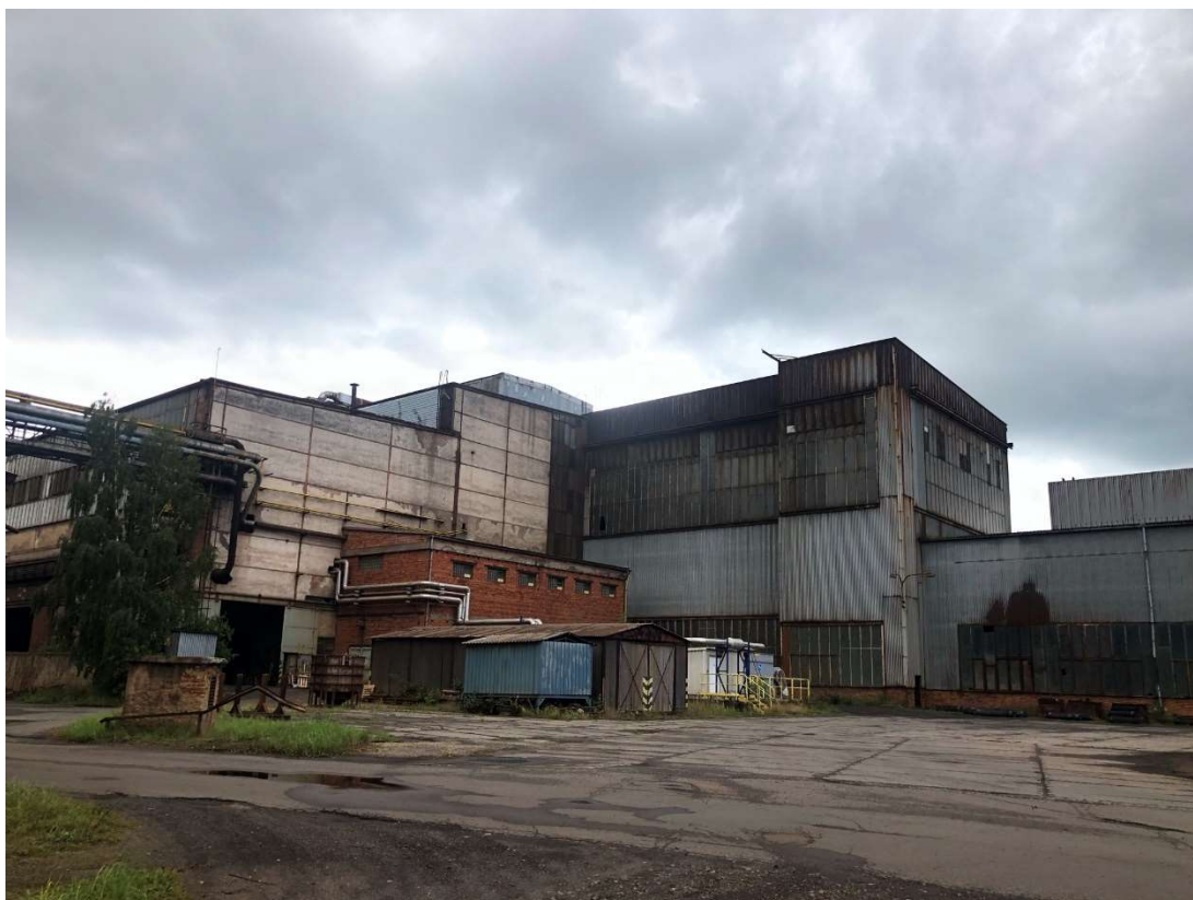
Obr. 210 – Elektroocelárna s licí halou HZPO, západní pohled, 2021, Zdroj: archiv autora
