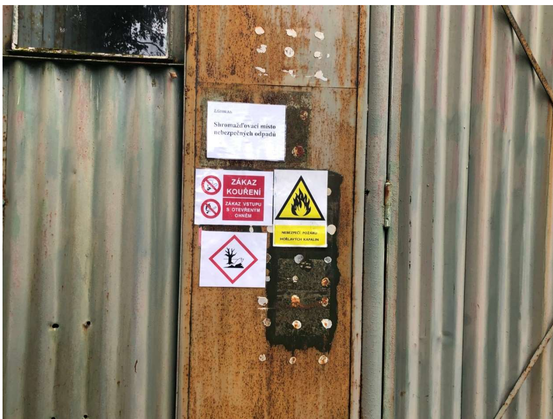
Obr. 293 – Detail označení skladu nebezpečných odpadů, 2021, Zdroj: archiv autora
