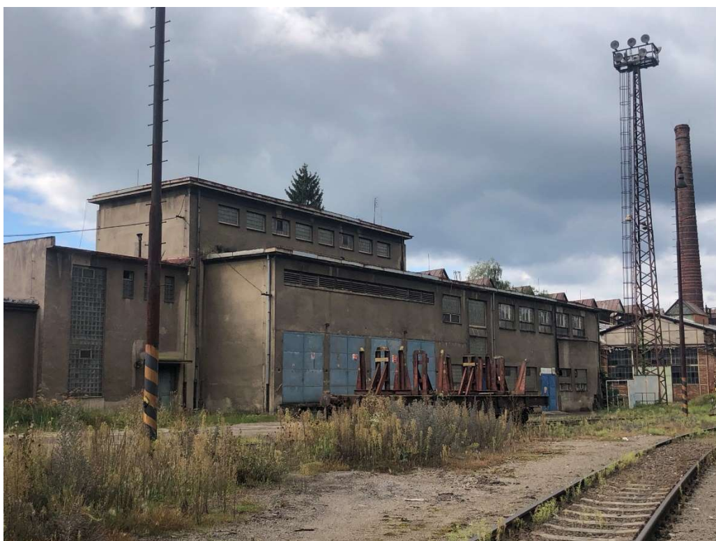
Obr. 186 – Trafo střed, severní pohled, 2021, Zdroj: archiv autora
