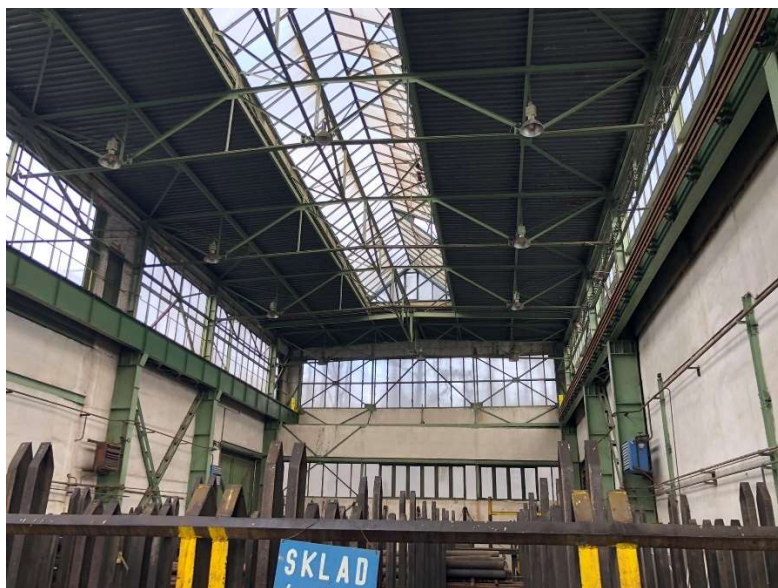
Obr. 203 – Sklad lesklého materiálu, interiér – pohled na severní stěnu, 2022, Zdroj: archiv autorky
