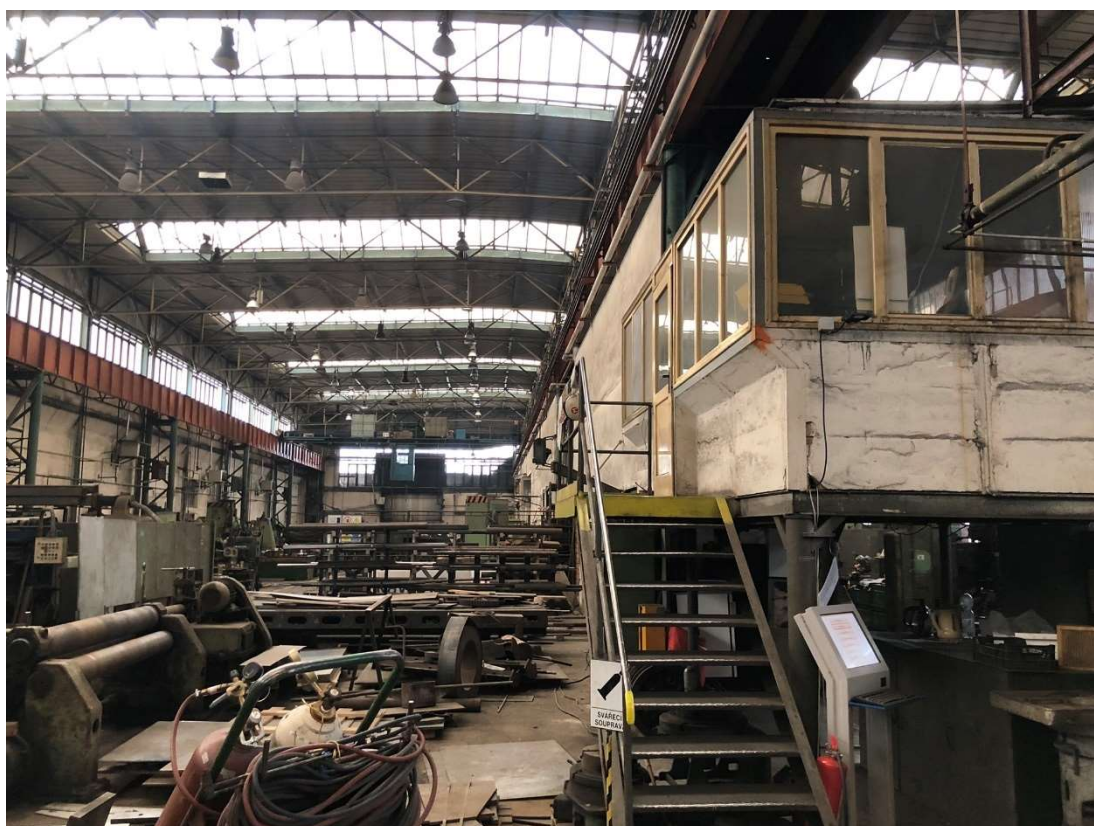
Obr. 82 – Mechanické dílny, interiér severní lodi haly s velínem, 2022, Zdroj: archiv autora
