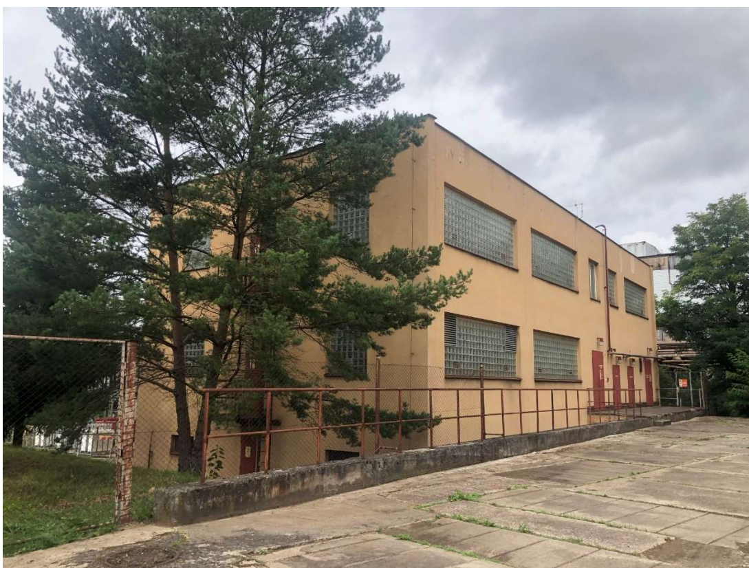
Obr. 175 – Rozvodna R24 22 kV, východní pohled, 2021, Zdroj: archiv autora
