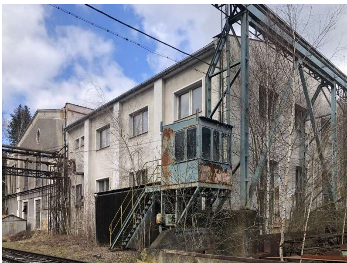
Obr. 94 – Centrála, pohled jihovýchodní, 2021, Zdroj: archiv autora
