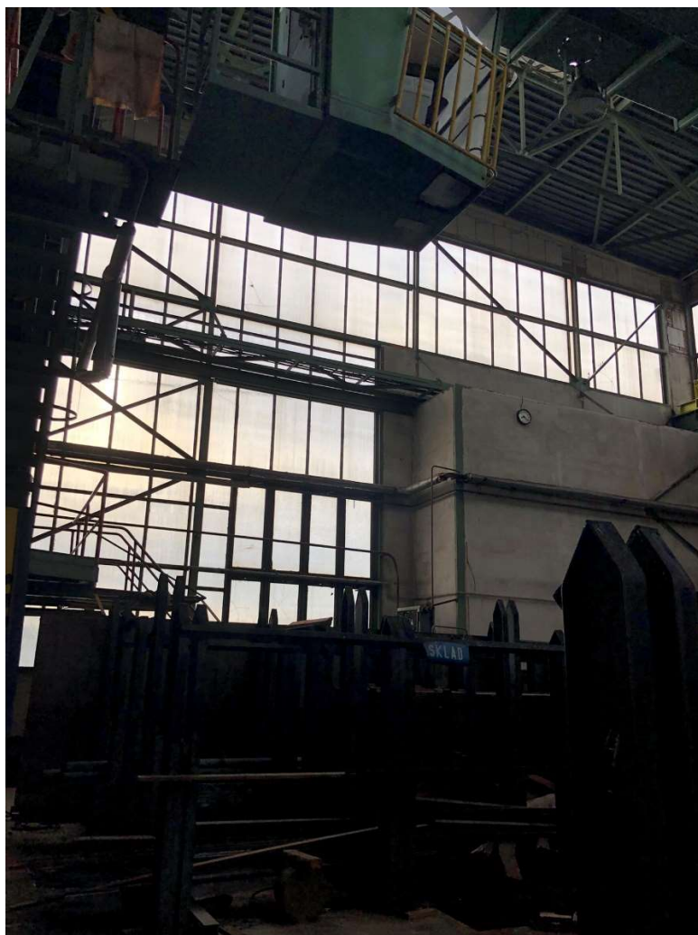
Obr. 204 – Sklad lesklého materiálu, interiér – pohled na jižní stěnu, 2022, Zdroj: archiv autorky
