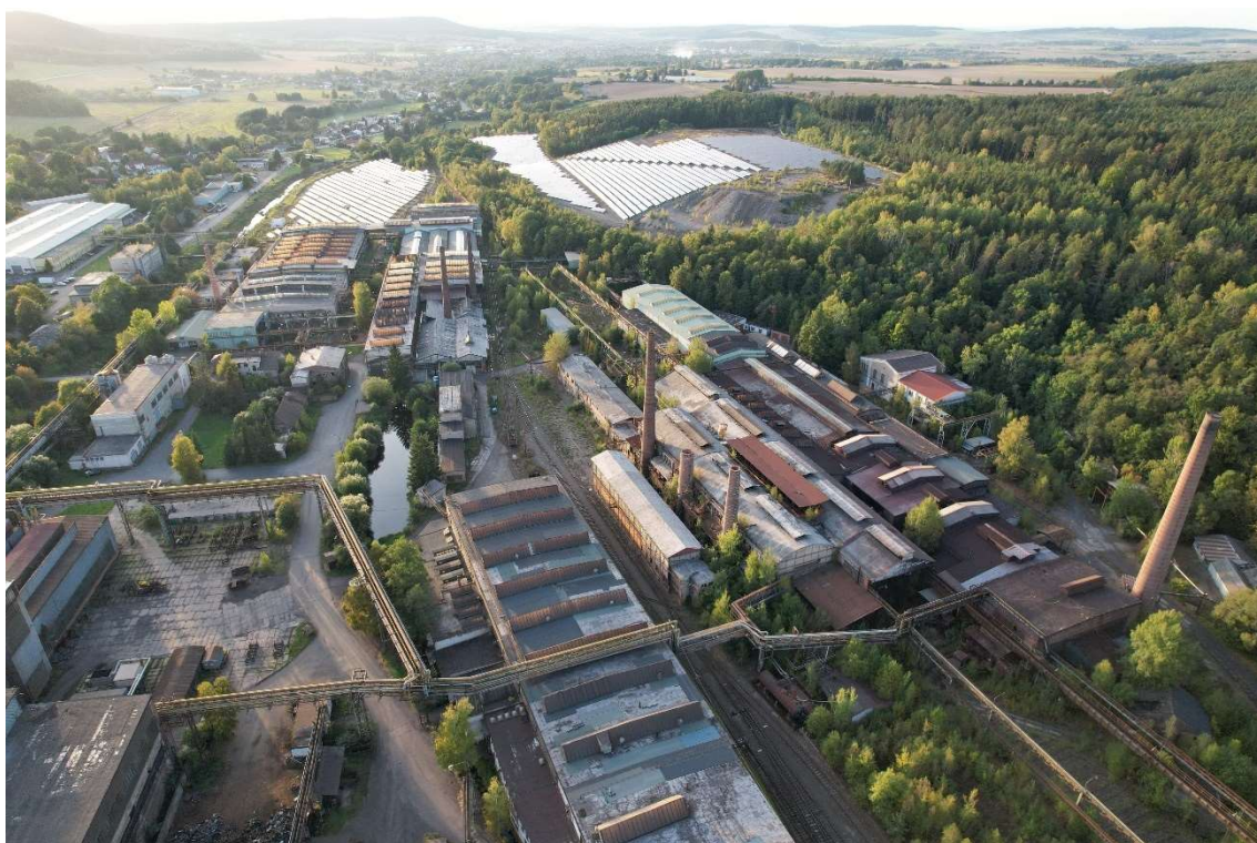
Obr. 335 – Areál železářny v Hrádku, východní pohled nad halou mechanické dílny, vpravo fotografie je vidět severní část areálu se siemens-martinskou ocelárnou a hrubou válcovnou, 2021. Zdroj: archiv autora
