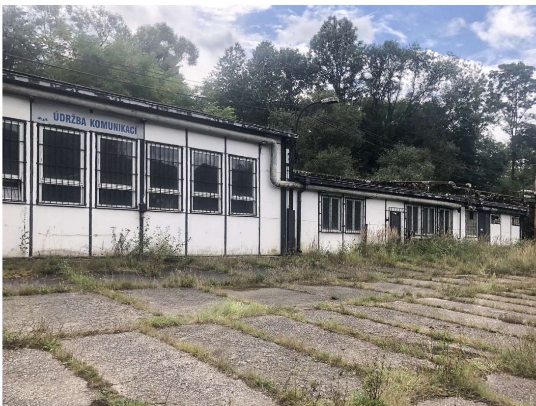
Obr. 258 – Budova údržby dráhy a komunikací, severní pohled, 2021, Zdroj: archiv autora
