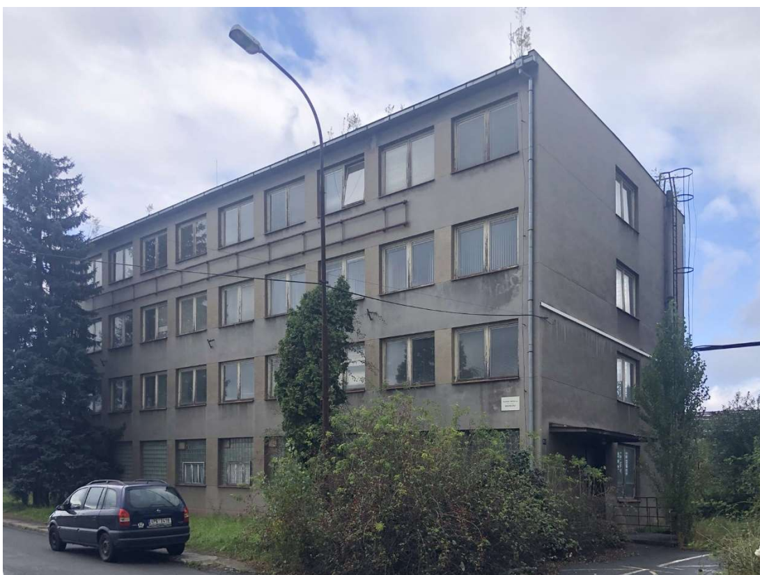
Obr. 200 – Administrativní budova ředitelství, hlavní vstup, pohled severozápadní, 2021, Zdroj: archiv autora
