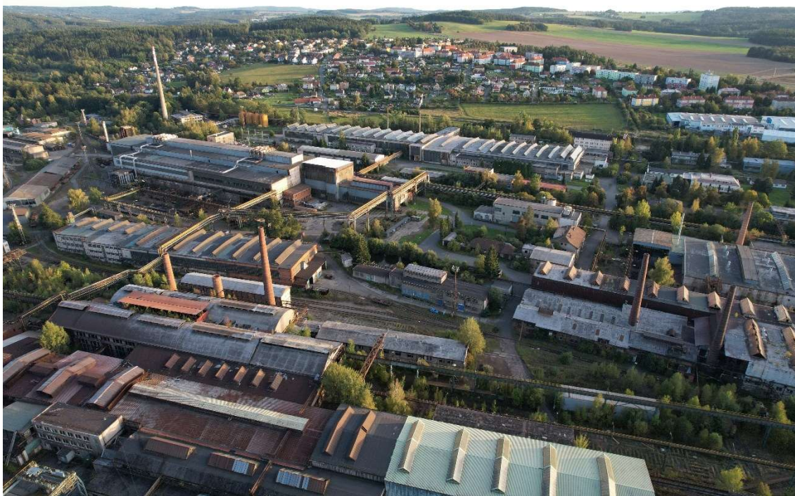
Obr. 336 – Areál železářny v Hrádku, severní pohled nad halou hrubé válcovny, za kterou je postupně vidět siemens-martinská ocelárna, generátorová stanice, mechanická dílna a elektroocelárna, za kterou je komín kotelny a haly lisovny a loupárny, v pozadí fotografie je město Hrádek, 2021. Zdroj: archiv autora
