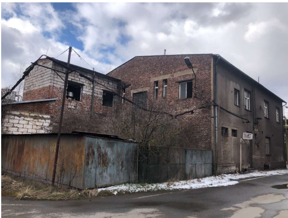
Obr. 84 – Stará administrativní budova – ředitelství, pohled severovýchodní, 2021, Zdroj: archiv autora
