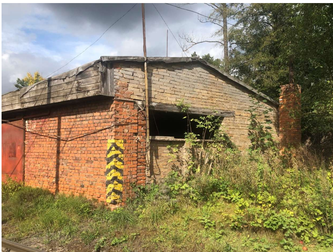
Obr. 233 – Sklad, jihovýchodní pohled, 2021, Zdroj: archiv autora
