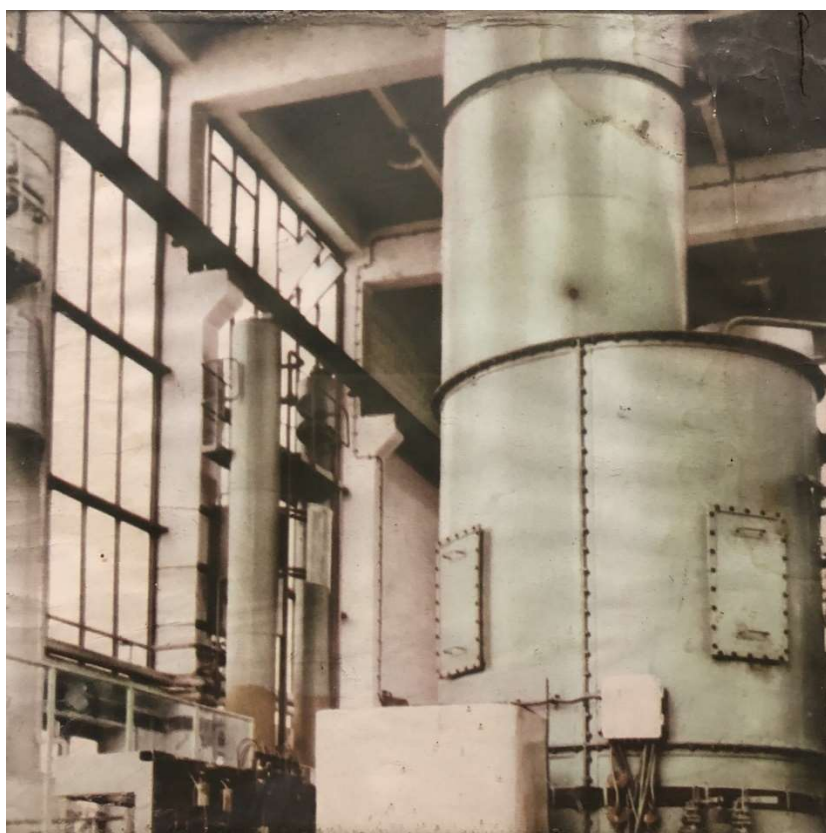
Obr. 166 – Budova kyslíkárny, historická fotka interiéru s technologií, Zdroj: archiv autora
