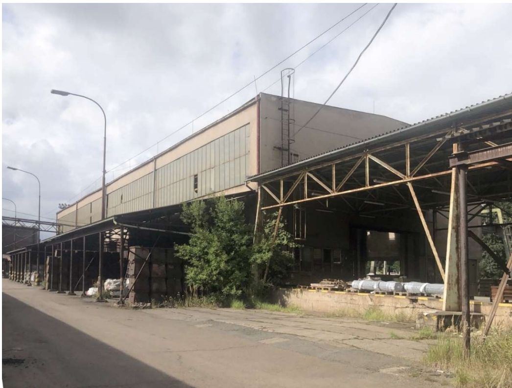
Obr. 236 – Sklad přísad, jižní fasáda, 2021, Zdroj: archiv autora
