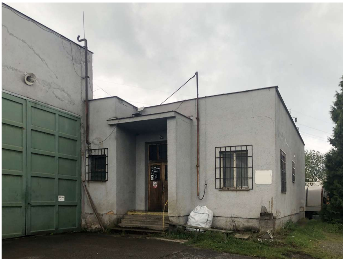
Obr. 244 – Dílna dopravy a garáže, pohled východní 2021, Zdroj: archiv autora
