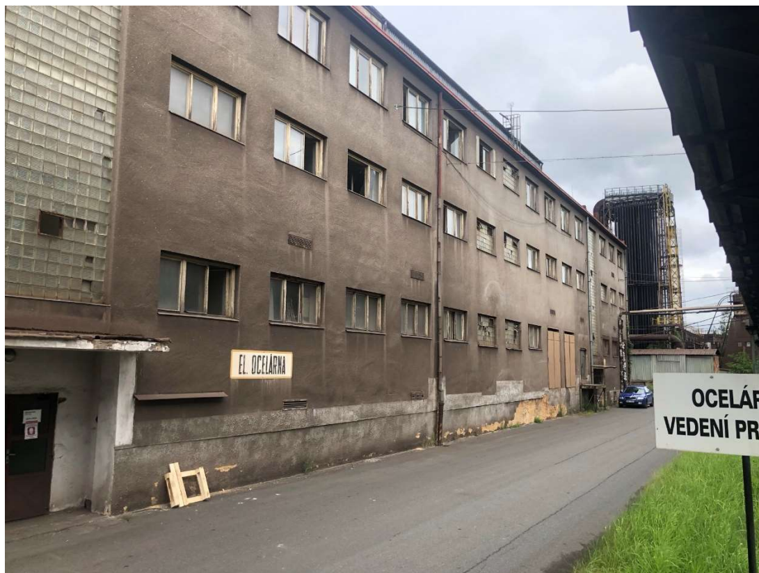
Obr. 218 – Šatny a kanceláře elektroocelárny, pohled jižní, 2021, Zdroj: archiv autora
