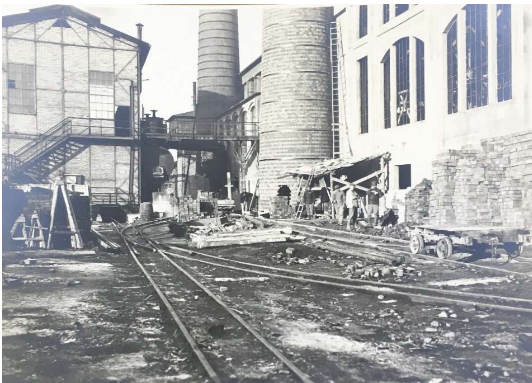
Obr. 71 – Generátorová stanice a komíny siemens-martinské ocelárny, 1916, Zdroj: Státní oblastní archiv v Plzni, Fondy podnikových a hospodářských subjektů, Hrádek, kart.32.
