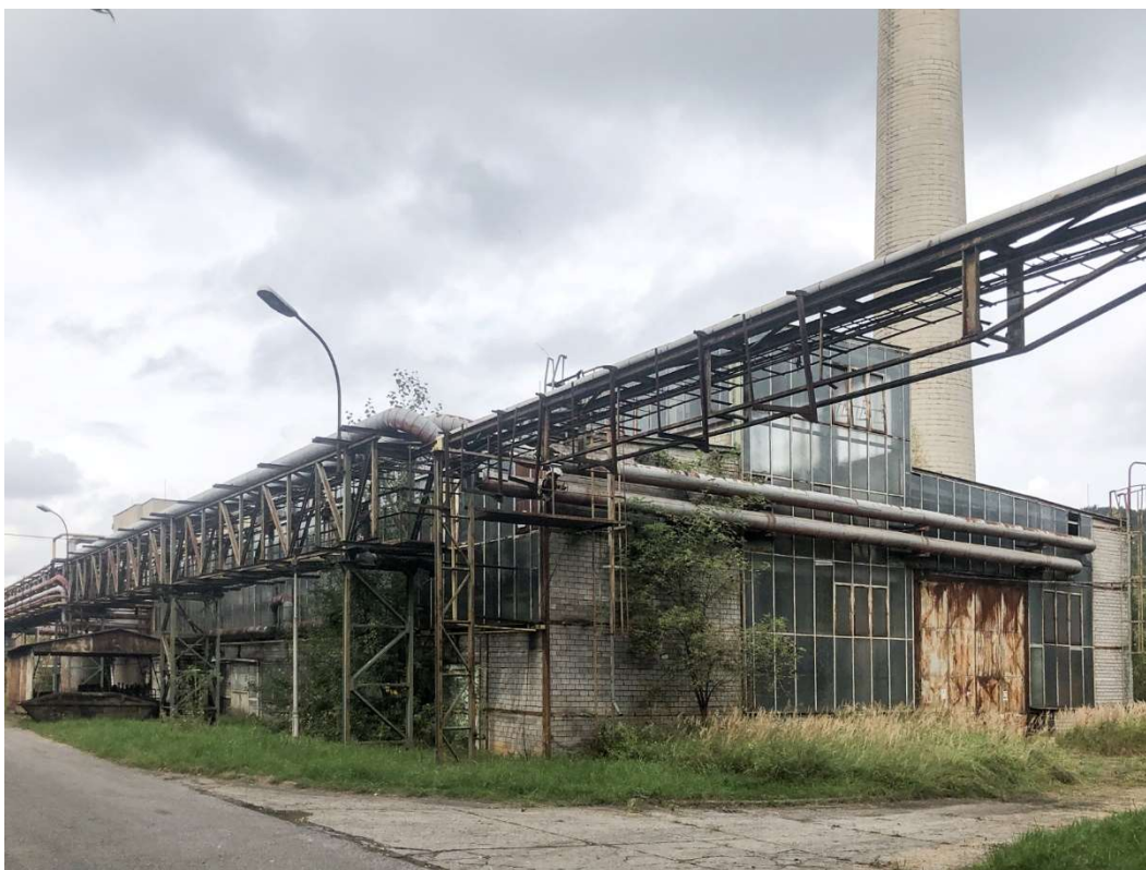
Obr. 247 – Kotelna, jihovýchodní pohled, 2021, Zdroj: archiv autora
