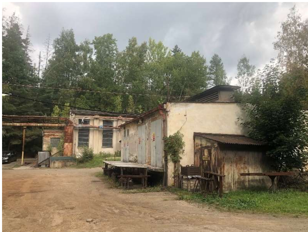
Obr. 168 – Budova rozvodny v pozadí s objektem kompresorovny, 2021, Zdroj: archiv autora
