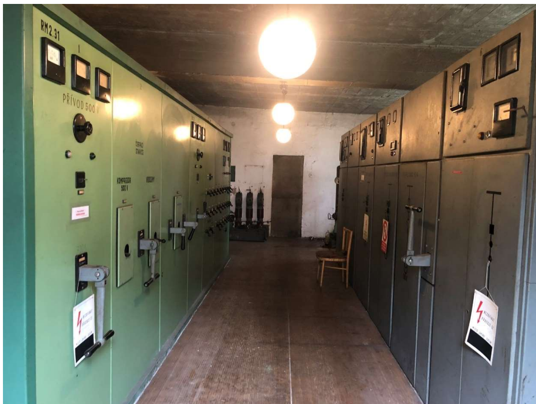
Obr. 169 – Budova rozvodny, interiér, 2022, Zdroj: archiv autora
