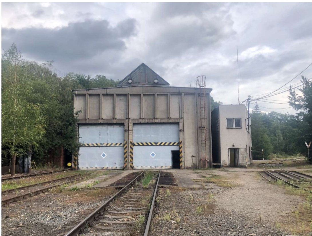
Obr. 310 – Budova vedení dopravy a remíz lokomotiv, pohled západní, 2021, Zdroj: archiv autora
