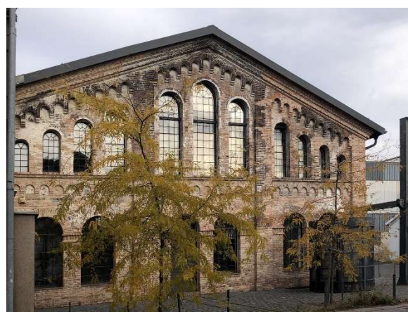
Obr. 354 – Strojovna Bessemerovy ocelárny, hlavní průčelí haly, 2021. Zdroj: archiv autora
