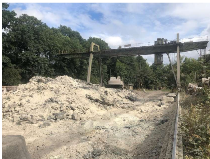
Obr. 172 – Struskoviště s jeřábovou dráhou, 2021, Zdroj: archiv autora
