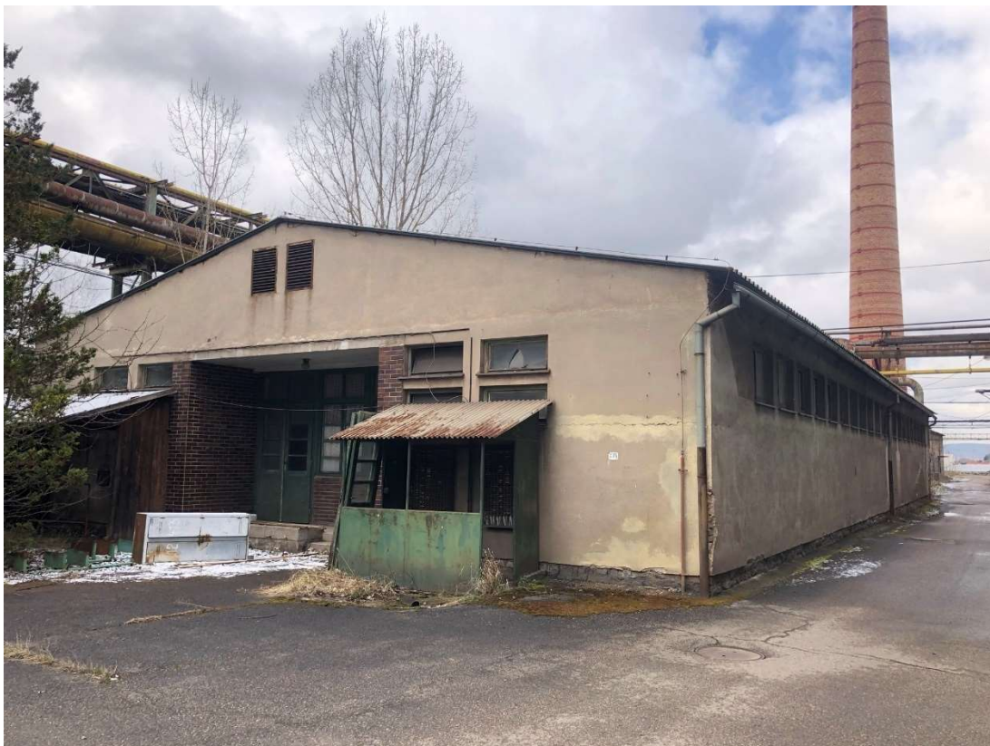
Obr. 281 – Sociální budova úpravny VS a VJ, pohled severovýchodní, 2021, Zdroj: archiv autora
