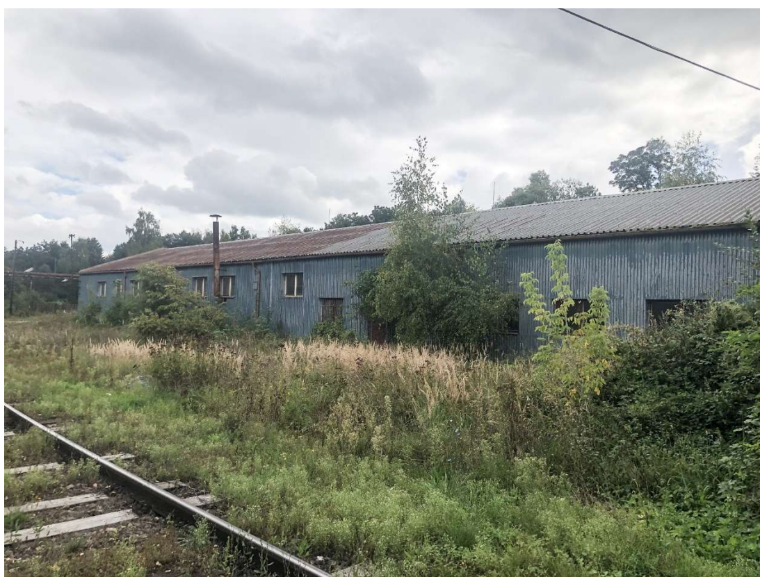
Obr. 285 – Bývalá učňovská dílna, severní pohled, 2021, Zdroj: archiv autora
