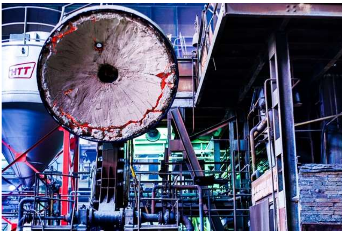
Obr. 217 – Elektroocelárna, detail víka obloukové pece.2018. Zdroj: archiv autora
