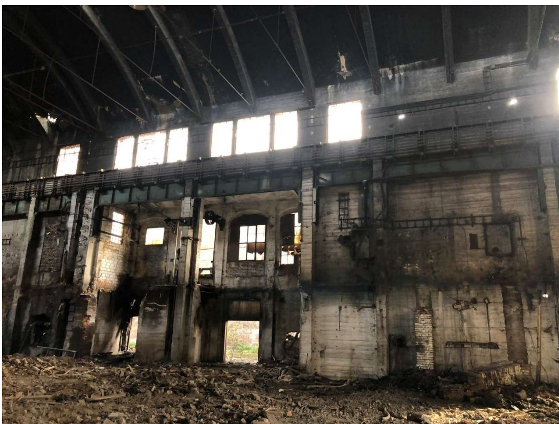
Obr. 63 – Siemens-martinská ocelárna, jižní strana interiéru, září 2022. Zdroj: archiv autora
