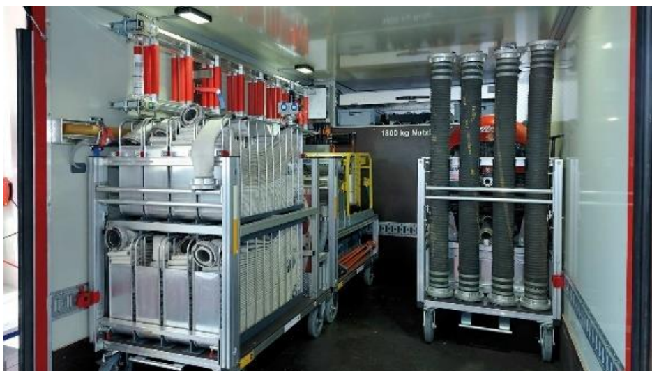
Obrázek 58 – Vozíky s vybavením naložené v úložném prostoru GW 1 [60]
