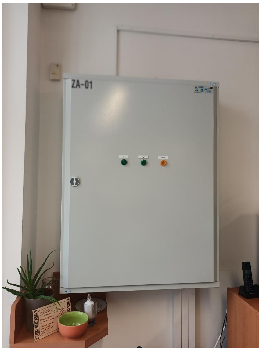
Obrázek 18 Rozvodná skříň přepínacího automatu [zdroj vlastní]
