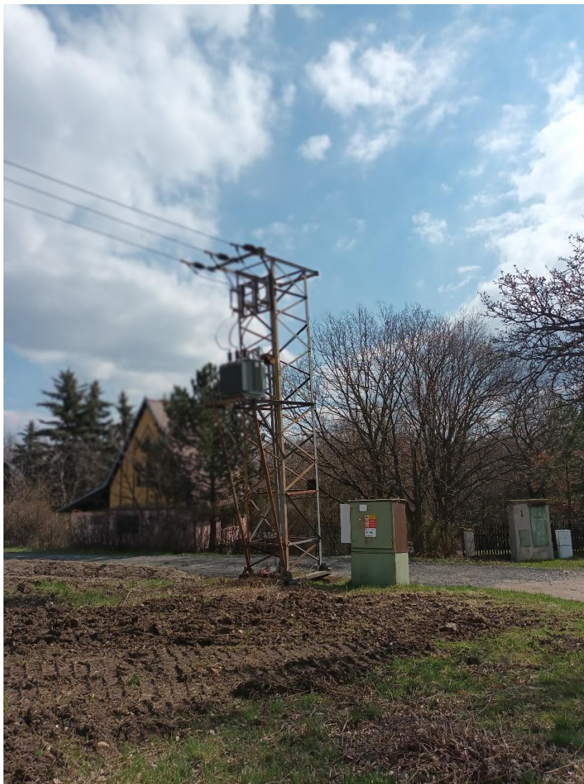
Obrázek 3 Stožár NN s oddělovacím trafem [zdroj vlastní]
