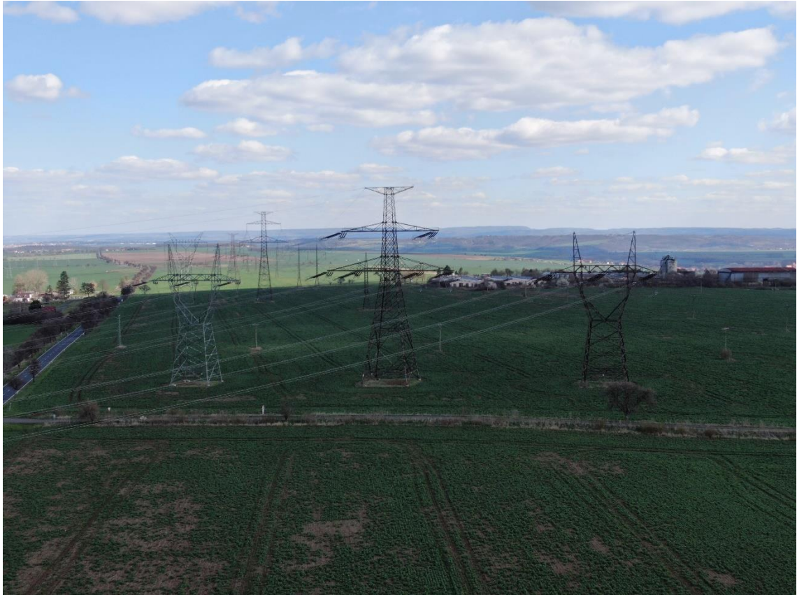
Obrázek 2 Souběh tří linek ZVN (400 kV) [zdroj vlastní]
