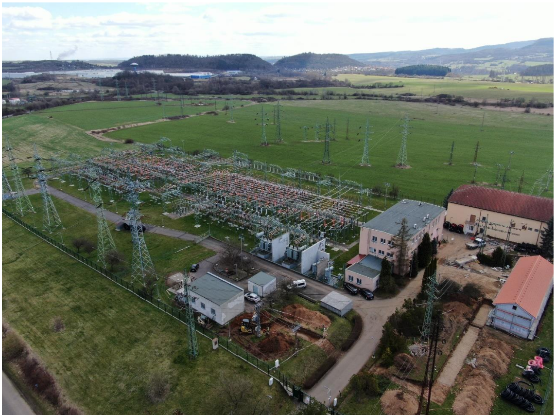
Obrázek 8 Rozvodna Verněřov, starší část v rekonstrukci [zdroj vlastní]
