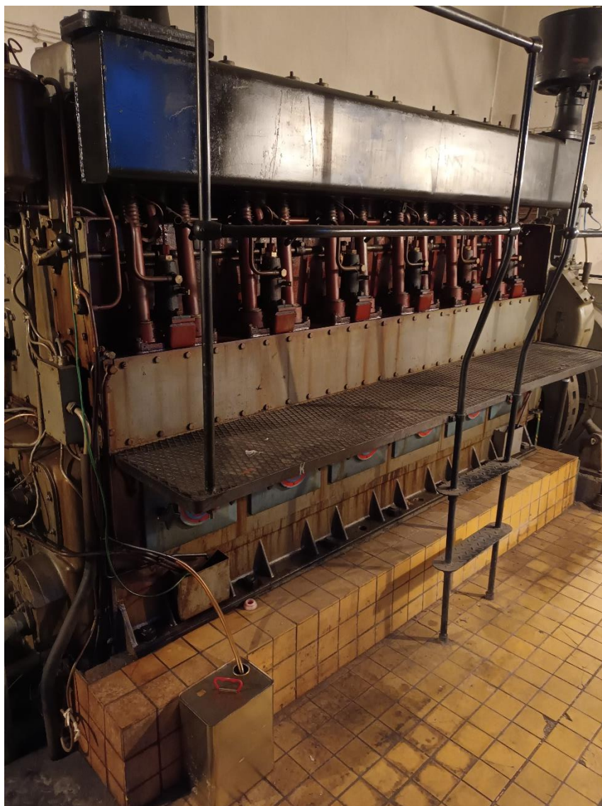
Obrázek 13 Motor dieselgenerátoru v NsP Kadaň [zdroj vlastní]
