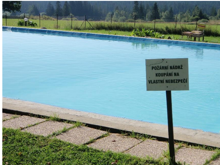
Obrázek 4 Víceúčelový zdroj požární vody (zdroj: autor)
