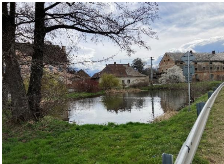
Obrázek 40 Požární nádrž Bílý Potok (zdroj: autor)
