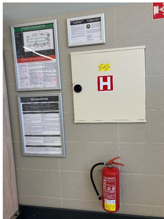
Obrázek 21 Nástěnný hydrant vestavěný (zdroj: autor)
