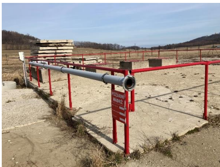
Obrázek 11 Uzavřená požární nádrž (zdroj: autor)
