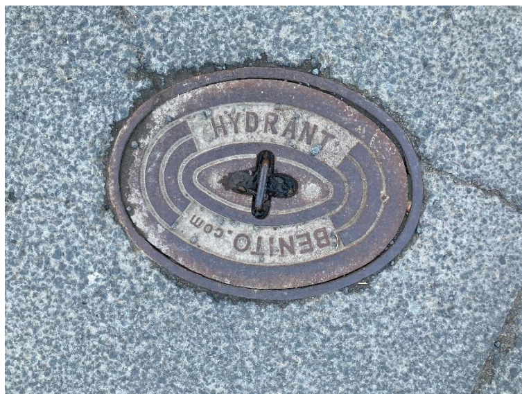
Obrázek 17 Podzemní hydrant (zdroj: autor)
