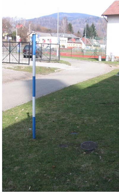
Obrázek 18 Podzemní hydrant - značení (zdroj: autor)
