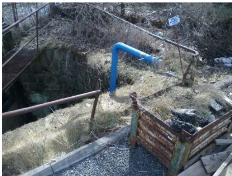
Obrázek 2 sací potrubí na toku (zdroj: autor)
