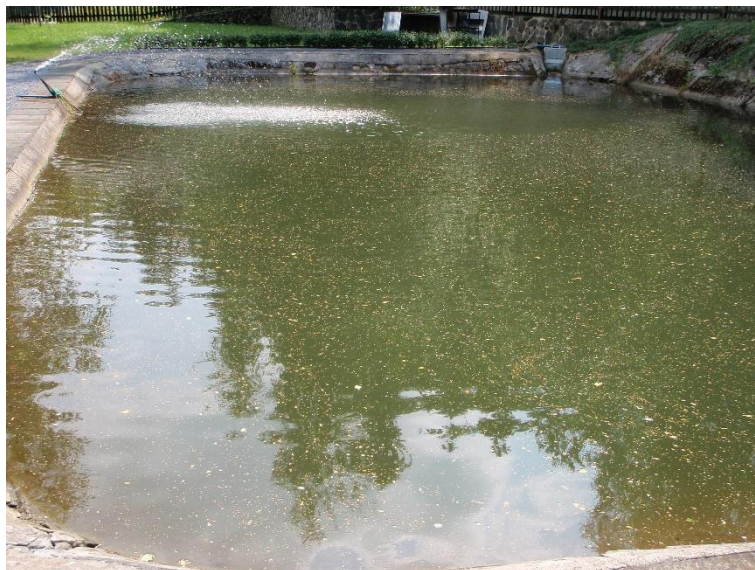
Obrázek 6 Otevřená požární nádrž (zdroj: autor)
