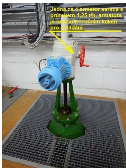
Obr. 3. Aerační armatura, minimálního průtoku korytem Vltavy z přehrady Hněvkovice.
