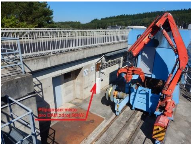
Obr. 4. a 5. Připojovací místo (MC) pro vnější připojení mobilního diesel-generátoru 50kW, skříň rozvodny z pře-hrady Hněvkovice.
