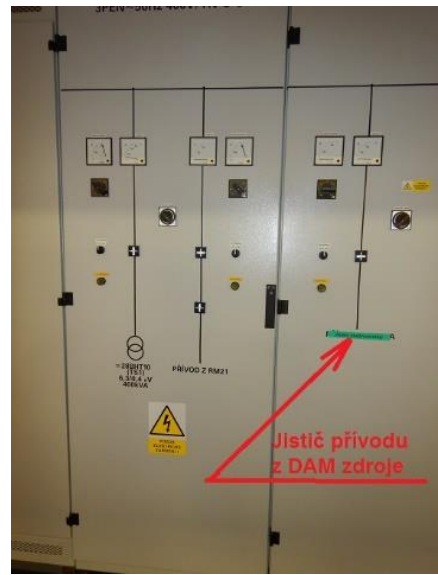
Obr. 4. a 5. Připojovací místo (MC) pro vnější připojení mobilního diesel-generátoru 50kW, skříň rozvodny z pře-hrady Hněvkovice.
