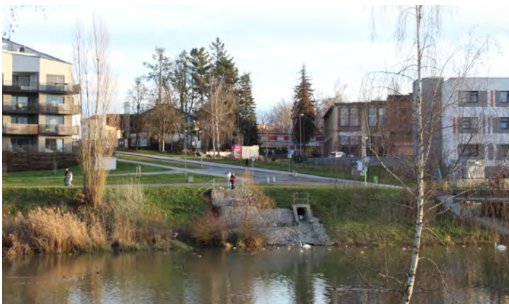
Obr.č.293: Napojení stezky pravého břehu řeky na ulici Zahradní u papírny, foto: Boříková Hana
