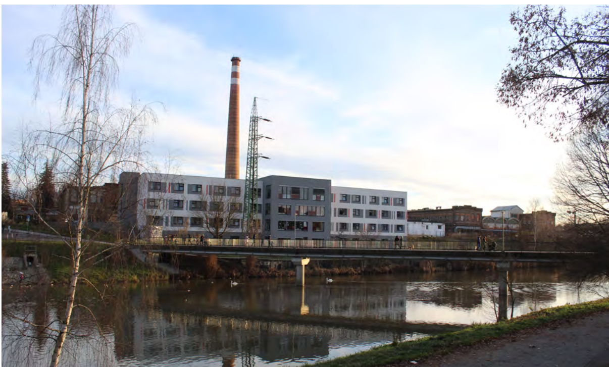
Obr.č.292: Celkový pohled na papírnu přes řeku s Papírenskou lávkou a Domovem pro seniory v popředí, foto: Boříková Hana
