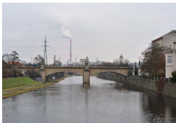
Obr.č.490: Pohled z Lochotínské lávky na Saský most (v pozadí vodárenská věž), foto: Boříková Hana
