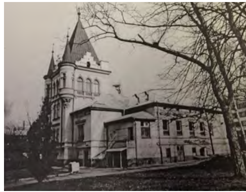
Obr.č.258: Vila Piette před demolicí; zdroj: Západočeské muzeum v Plzni
