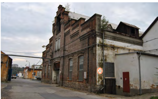
Obr.č.264: Hala bývalé kotelny, foto: Boříková Hana
