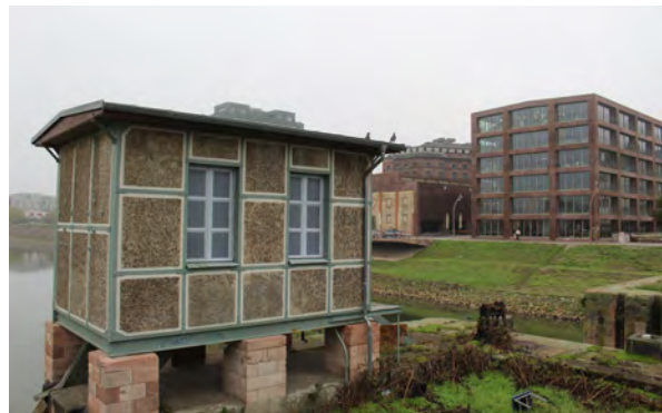
Obr.č.138: Strojovna Teuffelsbrücke, foto: Boříková Hana
