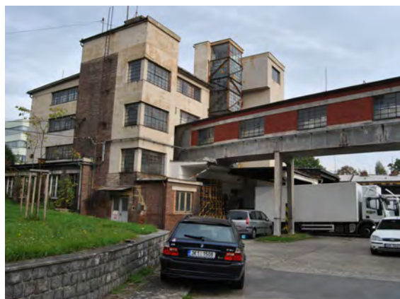
Obr.č.263: Budova expedičního skladu dokončená v roce 1933; foto: Boříková Hana
