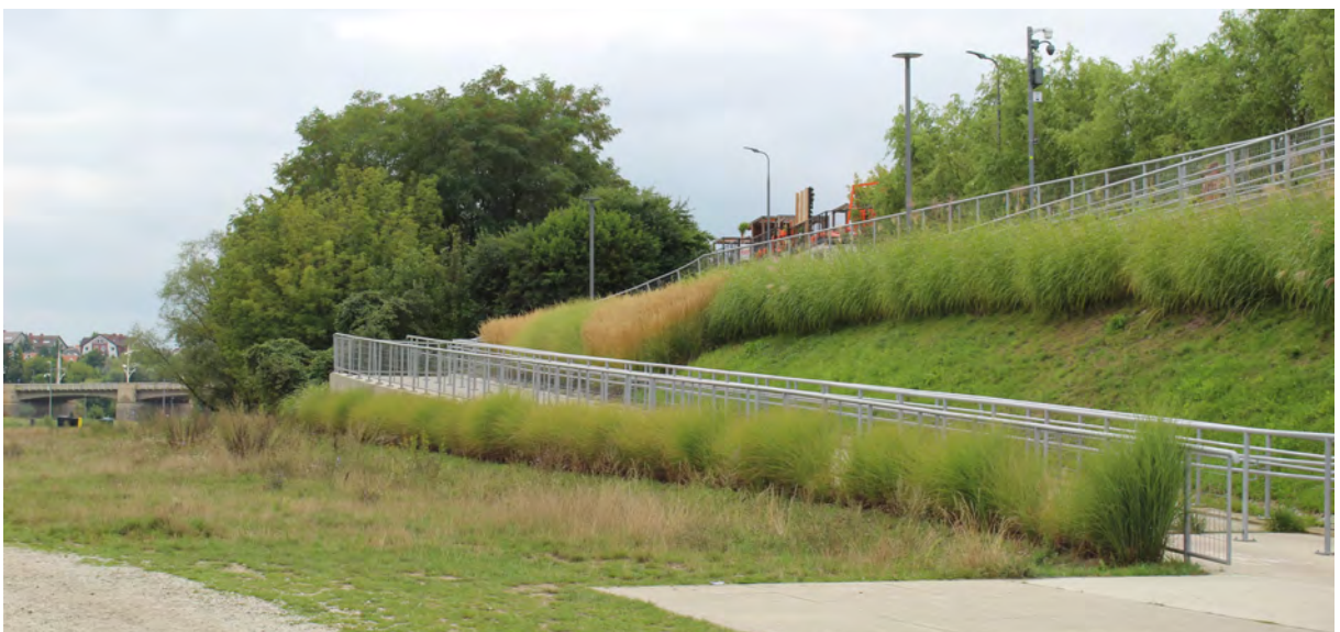
Obr.č.73: Propojení řeky s horní úrovní v místě napojení na park Staré koryto, foto: Boříková Hana
