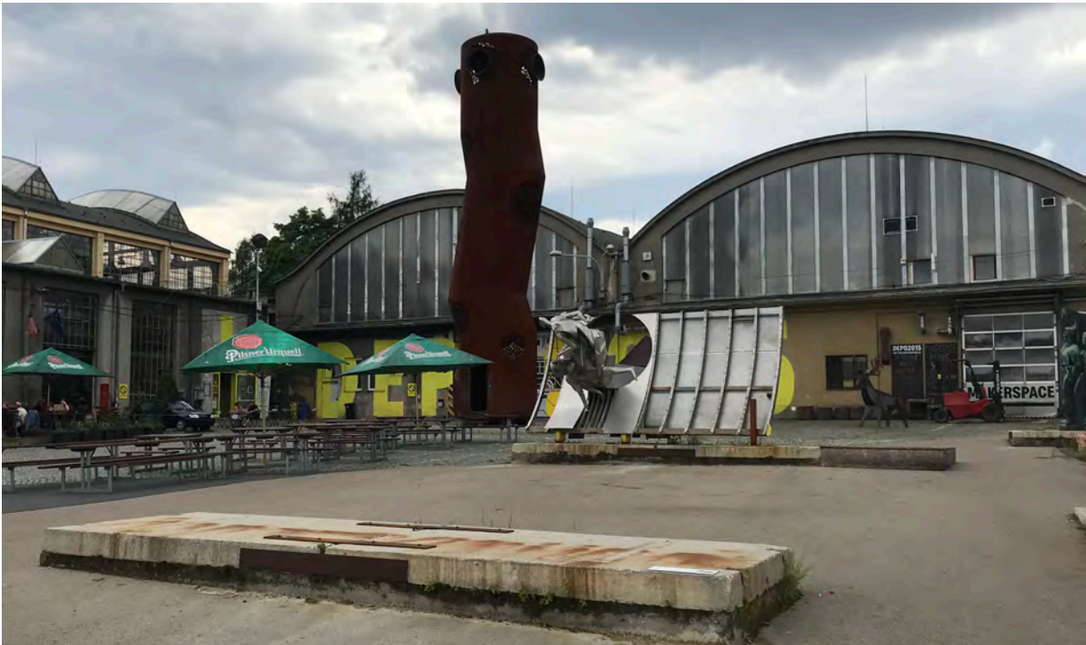
Obr.č.296: Současný stav Ústředních dílen a autobusové haly, foto: Boříková Hana
