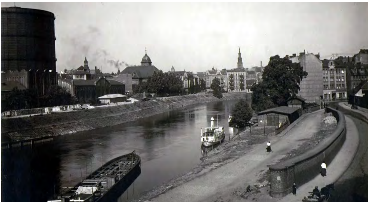
Obr.č.62: Pohled na plynárnu z protějšího břehu směrem ke Starému městu (1930), zdroj: https://poznan.fandom.com/wiki/Rzeka_Warta/Historia
