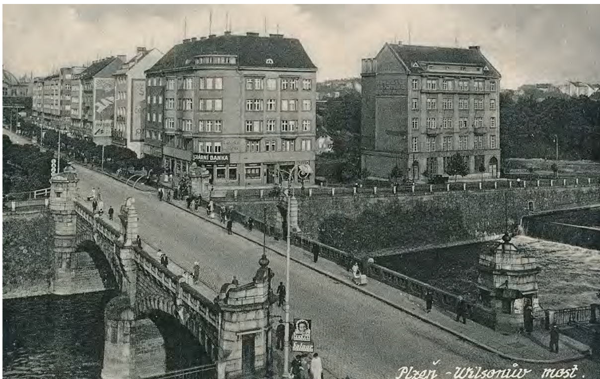
Obr.č.356: Pohled na objekt Elektrických podniků města Plzně (vpravo) přes Wilsonův most; zdroj: Archiv města Plzně
