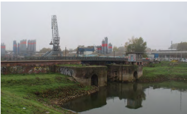
Obr.č.137: Současný stav Teuffelsbrücke, foto: Boříková H.
