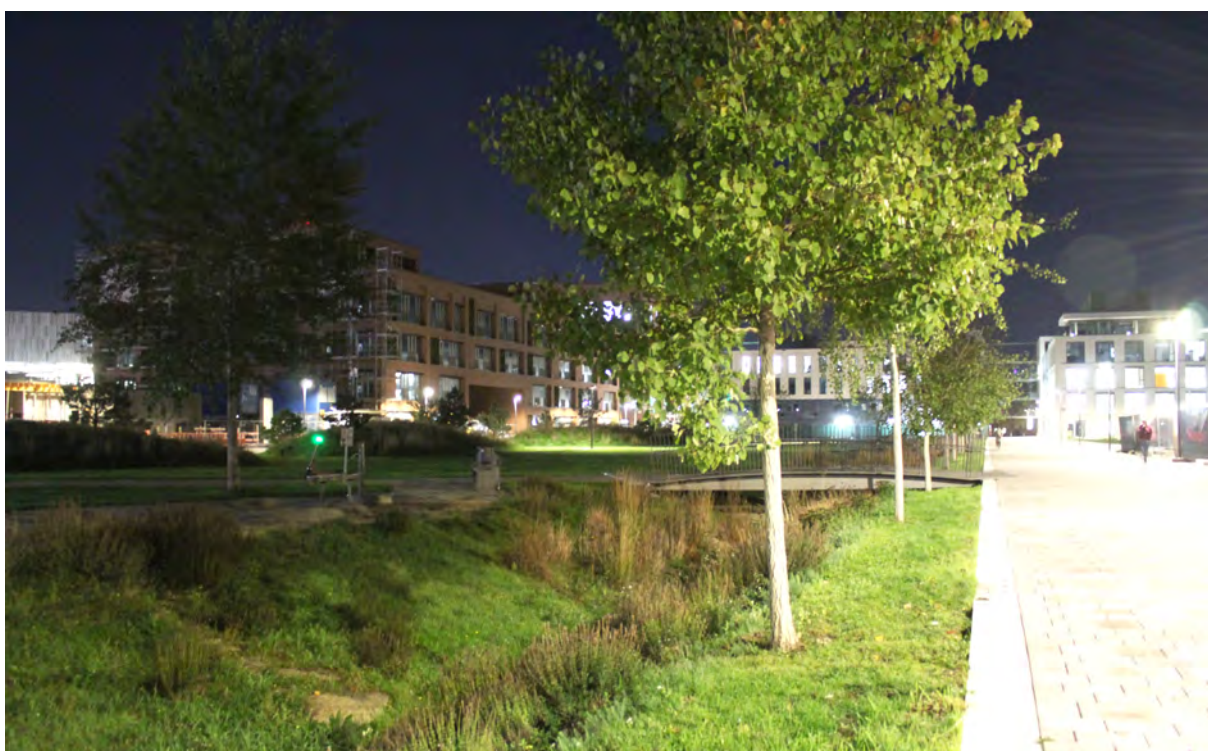
Obr.č. 103-105: Výstavba Neckar Parku a sídlo archivu (vpravo nahoře), autor: Boříková Hana
