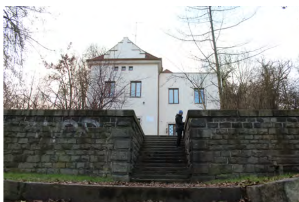
Obr.č.240: Pohled na bývalý pavilon restaurace a vodárnu pitné vody, foto: Boříková Hana
