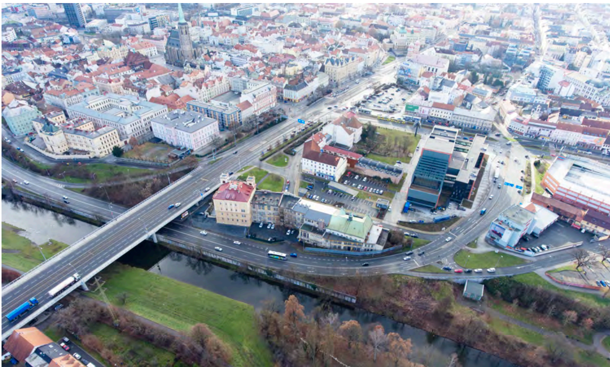
Obr.č.541: Křižení Tyršovy ulice a mostu Gen. Pattona (vlevo hist. jádro města), foto: Boříková Hana
