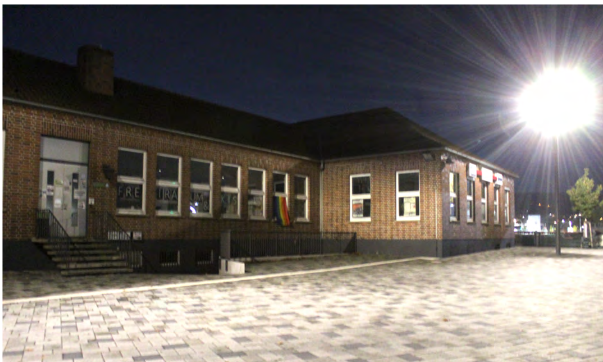
Obr.č.109-111: Objekt bývalého nákladového nádraží adaptován pro účely kulturního centra (dole), veřejné prostranství mezi objektem Městského státního archivu a objektem Kulturinsel jako vstupní prostor do revitalizovaného území (vlevo nahoře), komunitní zahrada projektu Kulturinsel (vpravo nahoře); autor: Bořiková Hana
