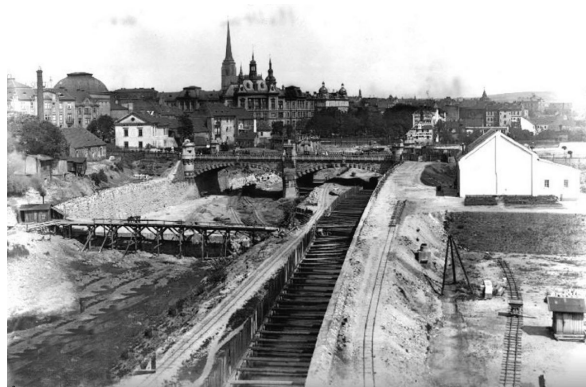
Obr.č.352: Výstavba nového jezu a regulace řeky Radbuzy - v pozadí Wilsonův most (1920); zdroj: Archiv města Plzně
