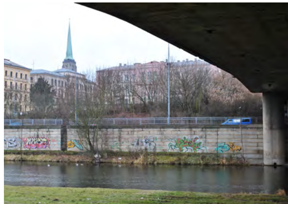
Obr.č.494: Podmostní prostor Gen. Pattona v kontextu nábřeží, foto: Boříková Hana
