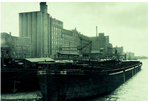
Obr.č.159: Pohled na Küpperův mlýn po roce 1912; zdroj: https://www.innenhafen-portal.de/standort/kueppersmuehle/
