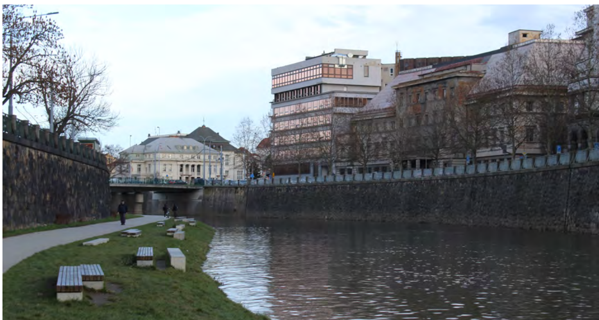
Obr.č.372: Pohled z náplavky na budovu sídla Krajské policie na Denisově nábřeží (vpravo bývalé Městské lázně); foto: Boříková Hana
