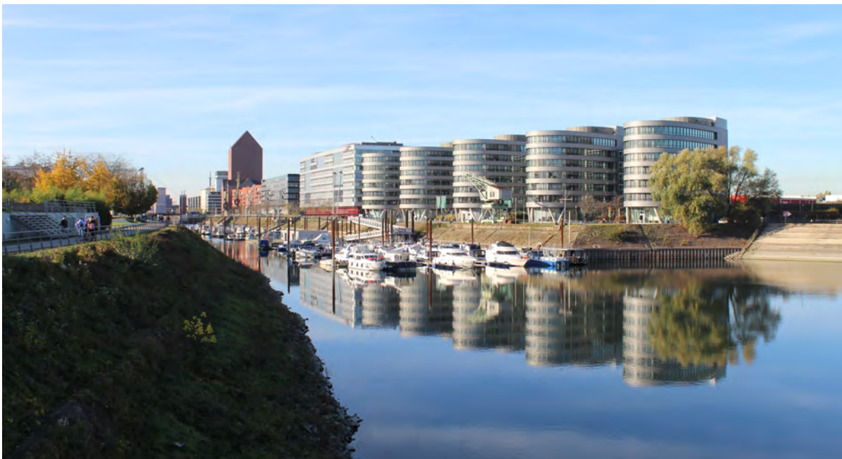
Obr.č. 166: Pohled na ústí kanálu v pozadí s objektem bývalého špýcharu, foto: Boříková Hana
