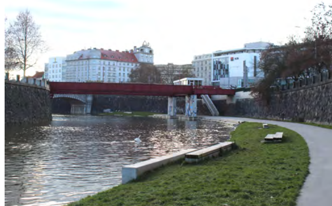
Obr.č.392: Celkový pohled na nově realizovanou náplavku řeky Radbuzy s kavárnou, foto: Boříková Hana
