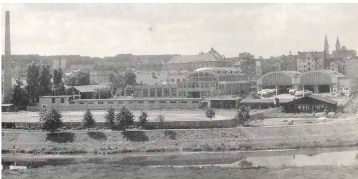
Obr.č.269: Nové ústřední dílny a autobusová hala (30. léta 20. stol.), zdroj: Archiv města Plzně
