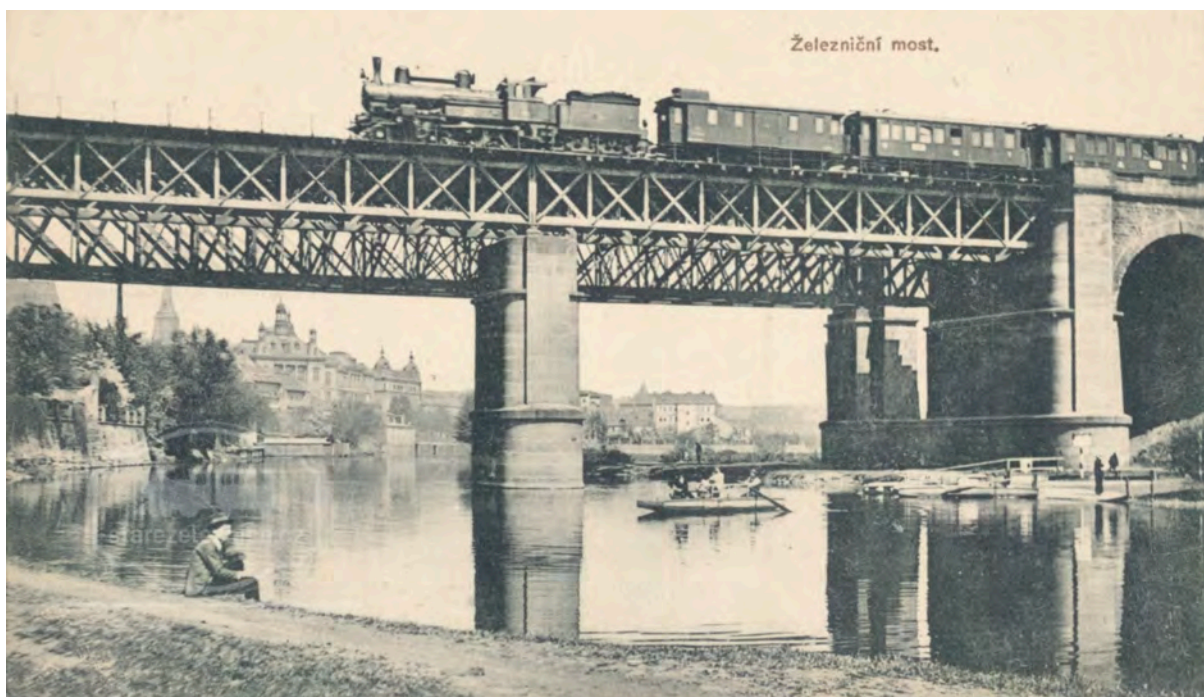
Obr.č.204: Pohled na železniční most přes řeku Radbuzu směrem do centra města (1907) zdroj: https://www.starezeleznice.cz/stare-zeleznice-mosty.php
