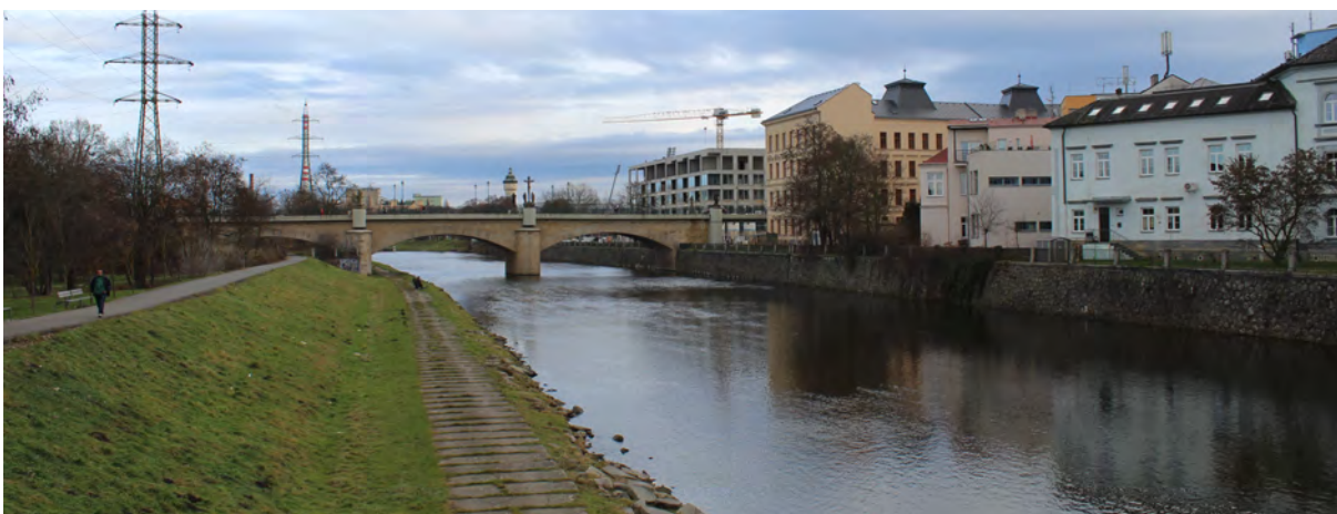
Obr.č.491: Pohled na regulované koryto řeky Mže (vlevo Saský most), foto: Boříková Hana
