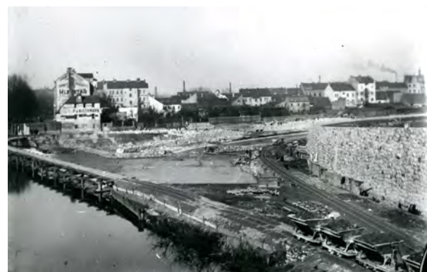
Obr.č.353: Výstavba regulace řeky Radbuzy poblíž Wilsonova mostu (1920); zdroj: Archiv města Plzně
