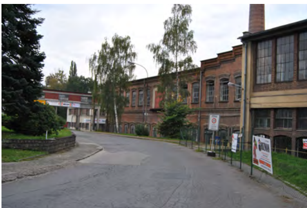
Obr.č.262: Vjezdu do areálu ze Zahradní ulice. Vpravo hala bývalé třídní papíru z roku 1884 - 1897 (dnes Kulturní centrum Papírna), v pozadí přemostění z expedičního skladu; foto: Boříková Hana
