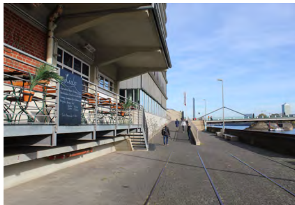
Obr.č.153: Soudobé využití původních zásobovacích ramp, foto: Boříková Hana
