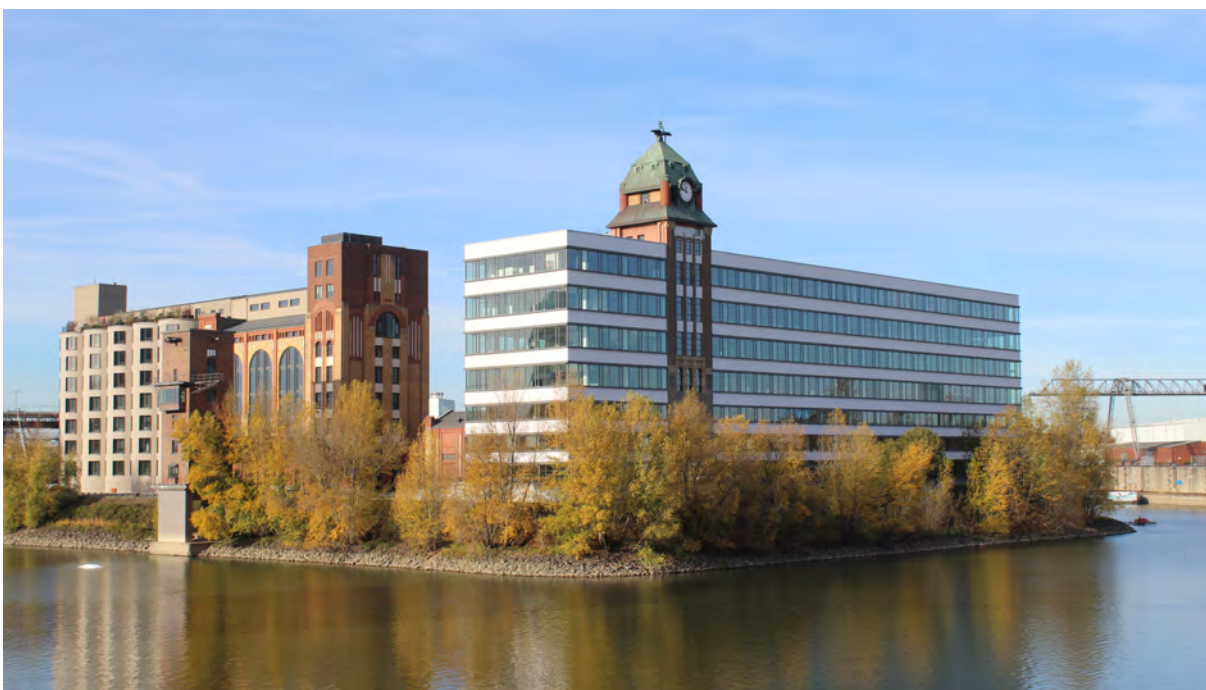
Obr.č.156: Adaptované objekty bývalého dřevařského a bezpečnostního přístavu pro kancelářské účely, foto: Boříková Hana
