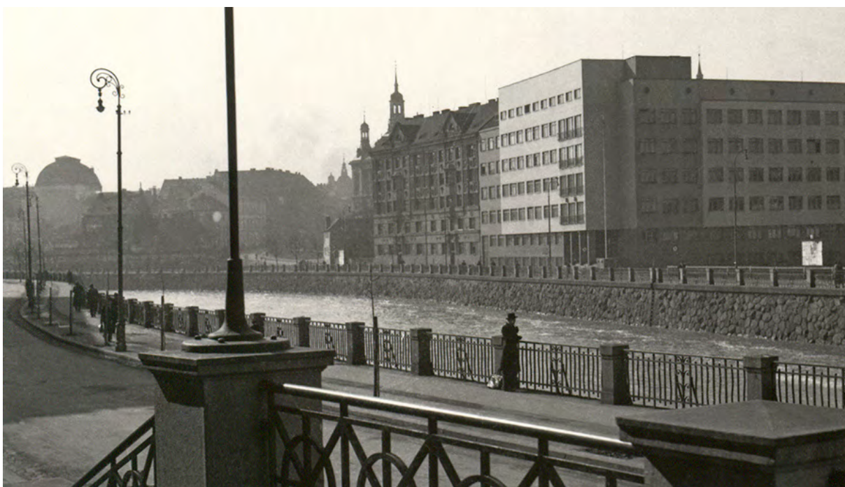
Obr.č.366: Pohled na budovu policejního ředitelství z Denisova nábřeží (rok 1943 - sídlo Gestapo), autor: Mirko Křen; zdroj: https://pam.plzne.cz/objekt/c1-1778-budova-policejního-reditelství
