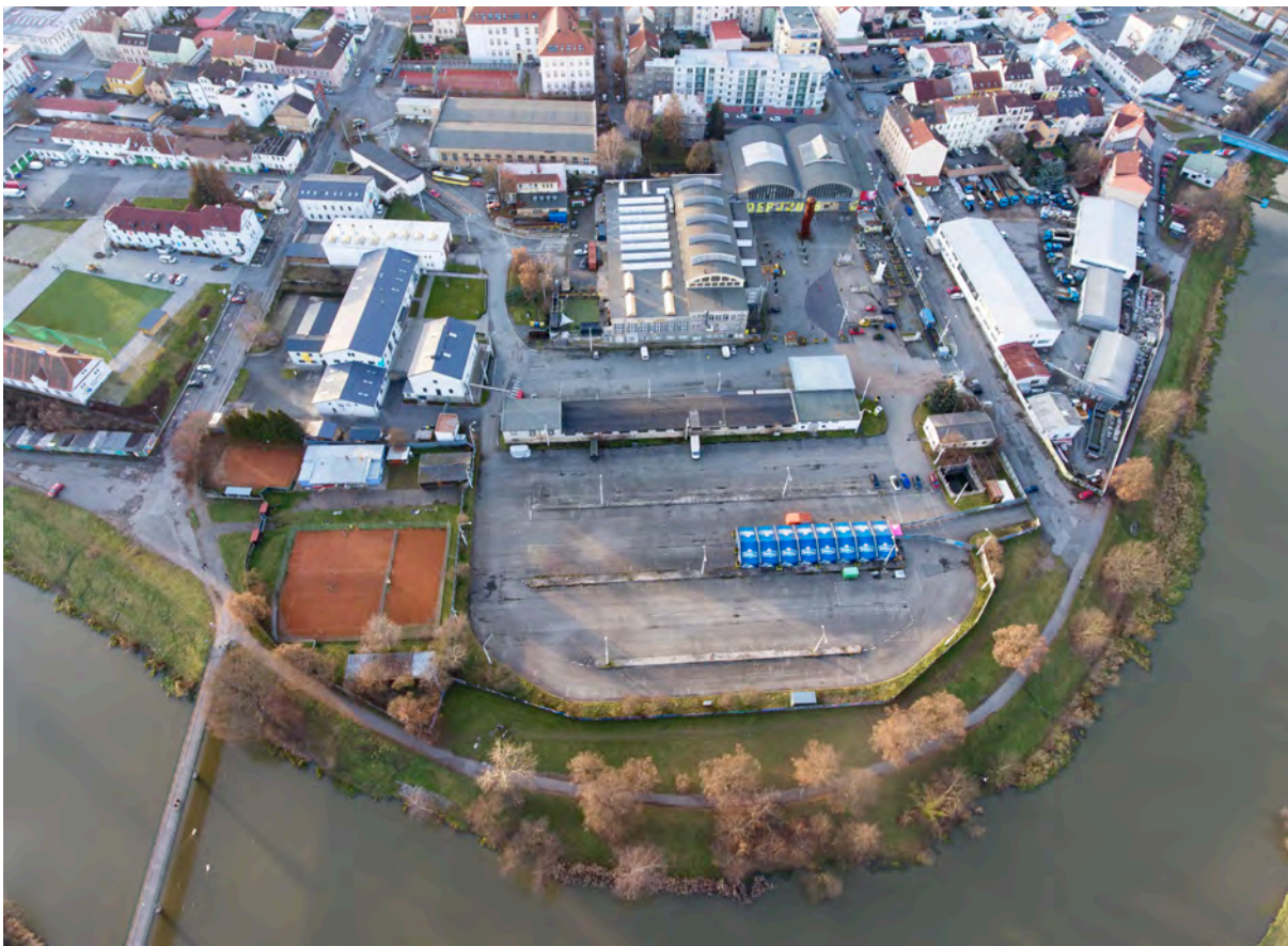
Obr.č.250: Pohled na současný areál DEPO 2015 - bývalá vozovna, stání a dílny Elektrických podniků města Plzně, foto: Boříková Hana
