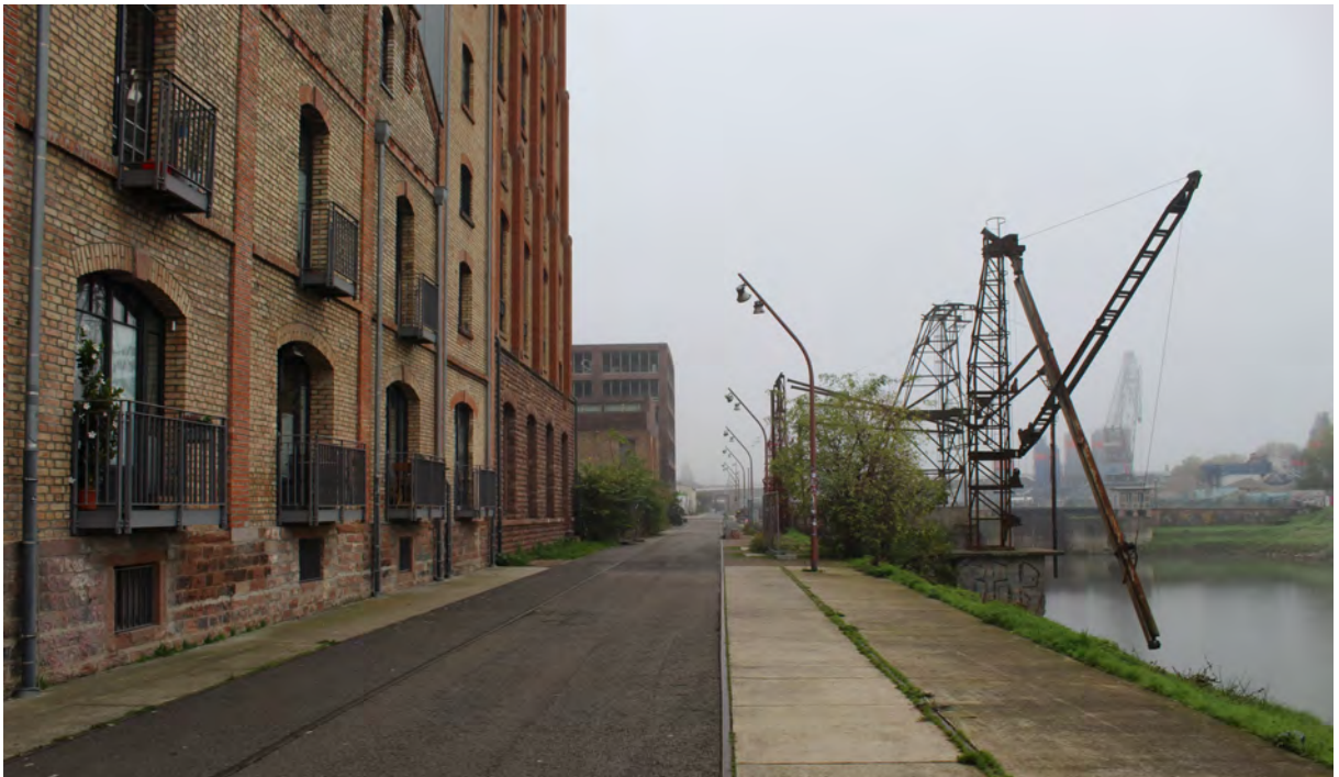
Obr.č.140: Parter objektů v kontextu s břehem kanálu, foto: Boříková Hana
