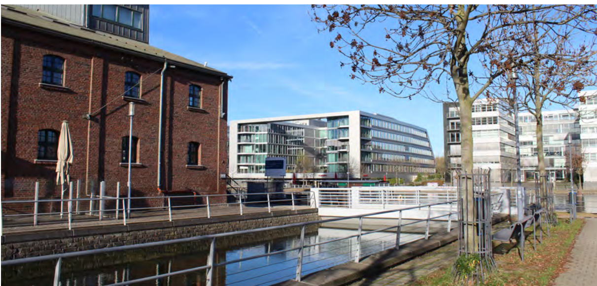
Obr.č.174: Propojující vodní prvek s doplněnými příčnými pěšími mostky, foto: Boříková Hana
