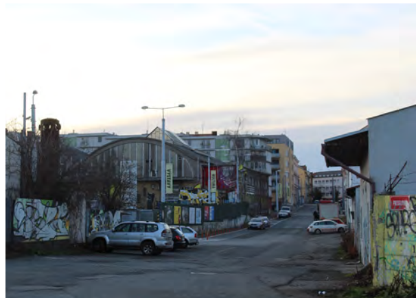
Obr.č.298: Průhled ul. Presslova s hlavním vstupem do areálu DEPO 2015, foto: Boříková Hana
