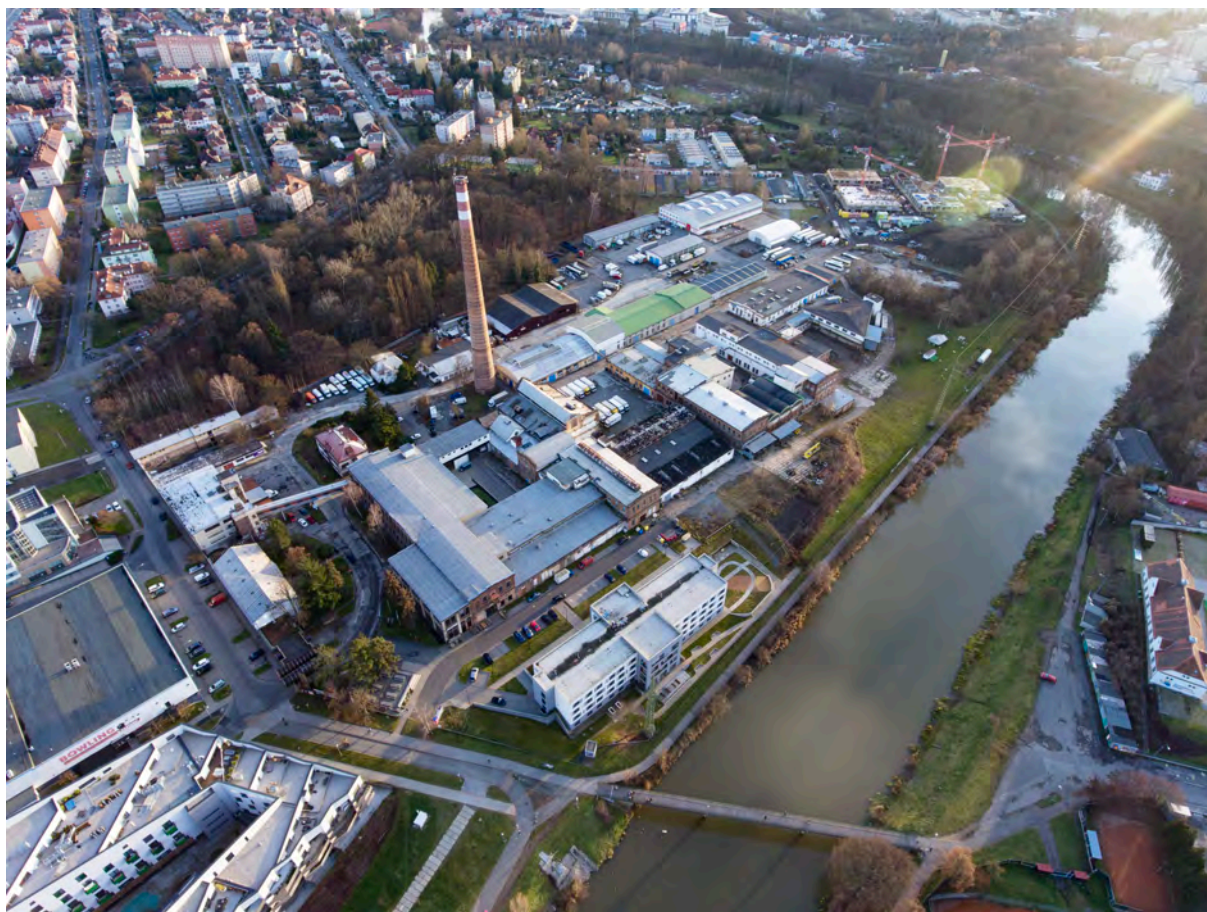
Obr.č.249: Pohled na lokalitu ve směru od centra města - areál papírny, foto: Boříková Hana
