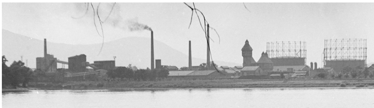
Obr.č.83: Plynárna v Budapešti na počátku 20. století, zdroj: https://pestbuda.hu/en/cikk/20220131_when_gas_no_longer_came_from_the_factory_this_is_how_budapest_switched_to_the_new_heating_method
