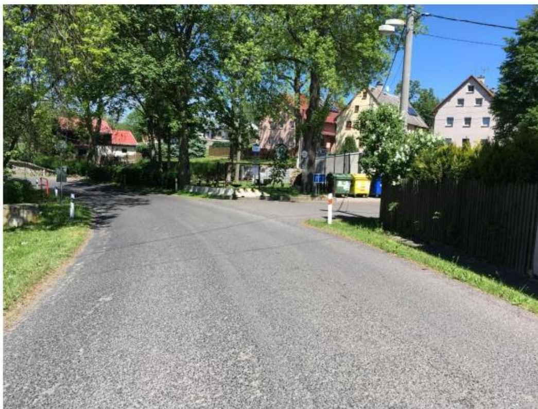
typická část komunikace - průjezdná
