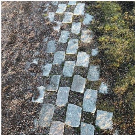
Zpevněné povrchy a jejich přechody v jiné zpevněné nebo v nezpevněné povrchy, netradiční propojení přírodních a přírodě blízkých materiálů. Město Uppsala, Švédsko
