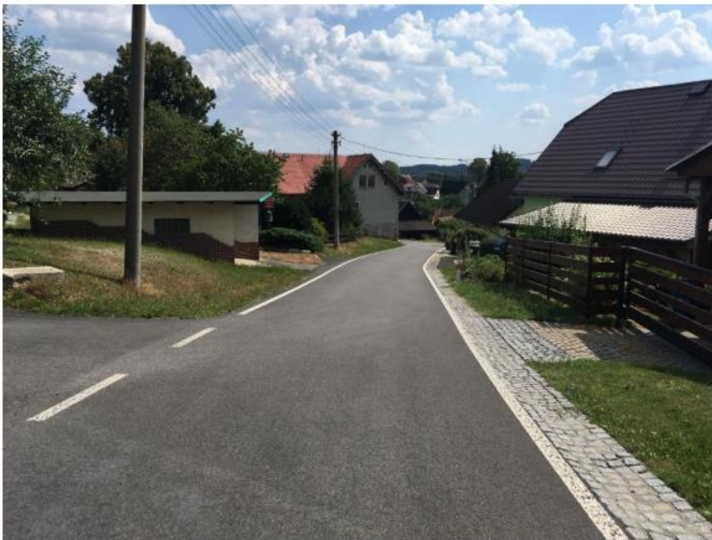
Obslužná komunikace s přídlažbou
