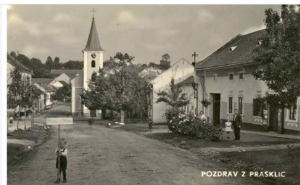
Obr. 1 Prasklice – ukázka postupného přechodu mezi povrchy – tzv. měkké hrany.
