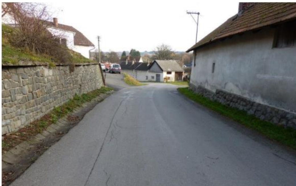
Řešení komunikace ve zúženém místě – dodržení průjezdného profilu
