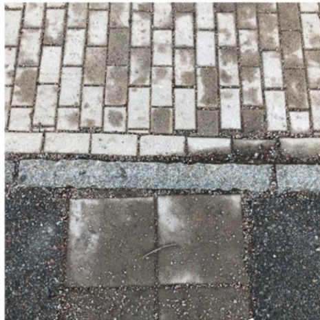
Zpevněné povrchy a jejich přechody v jiné zpevněné nebo v nezpevněné povrchy, netradiční propojení přírodních a přírodě blízkých materiálů. Město Uppsala, Švédsko
