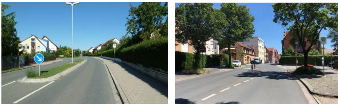
Obr. 16 - a) Místo pro přecházení - dělicí ostrůvek (Groswiesmannsdorf – okolí Norimberku). b) Středový ostrůvek (Stein – okolí Žitavy).
