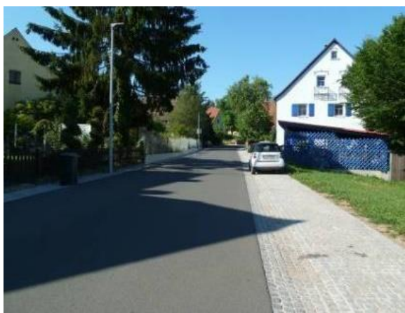
Obr. 19 - a) Přídlažba na komunikaci (Anwanden – okolí Norimberku). b) Přídlažba definující šířku komunikace (Hartau – okolí Žitavy).
