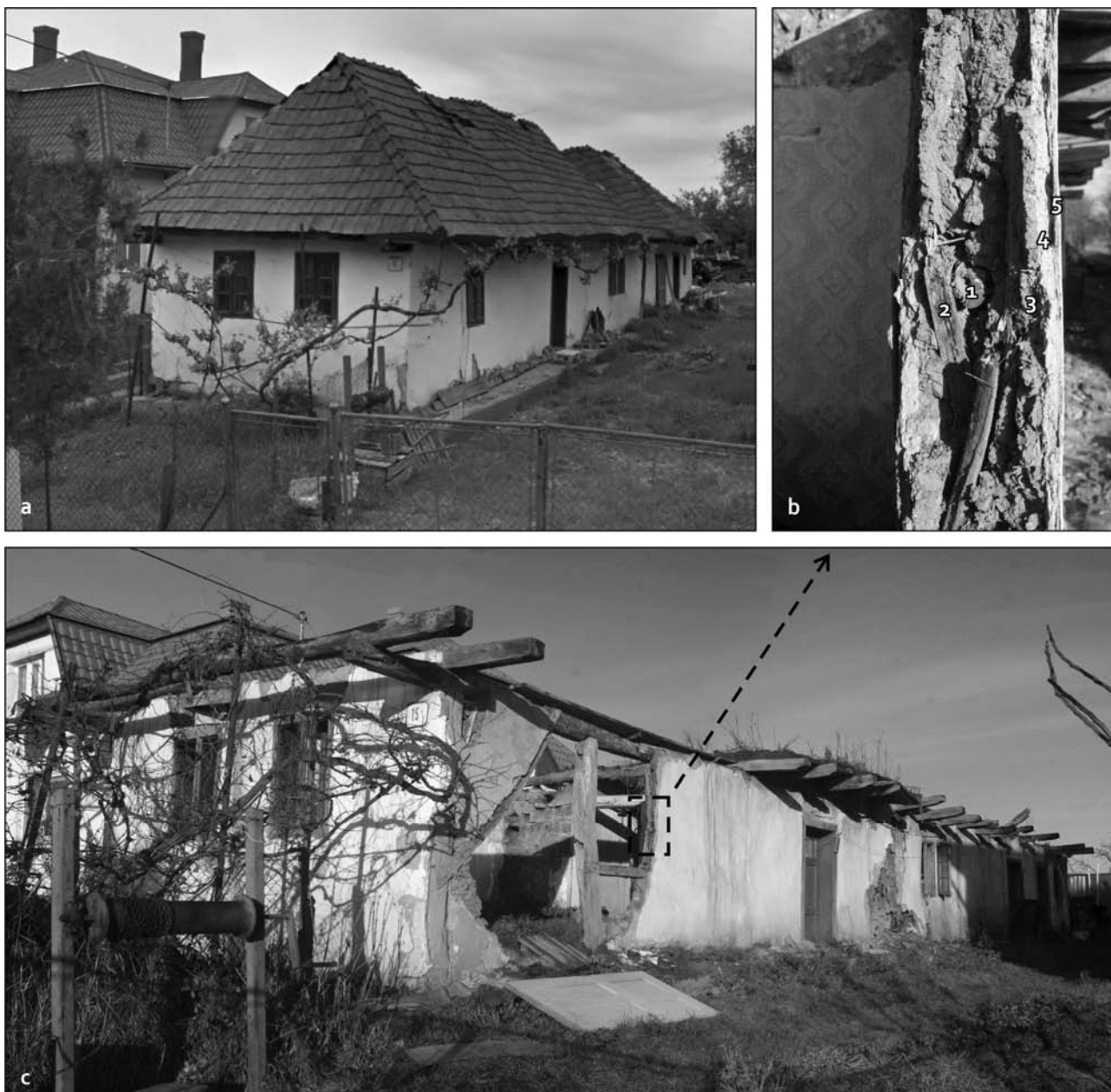
Obr. 4: Plechotice (okr. Trebišov), Hlavná 15/22, dom od JV, od ulice: a – stav v máji 2012; b – prirodzený rez južnou stenou prednej izby (hrúbka 18 cm): 1 – horizontálna palica ako osnova výpletu, 2 – vertikálny výplet, „patiki“, 3 – mazanica, 4 – hlinená omietka, 5 – vrstvy maľoviek a hlinených vyrovnávok; c – stav v decembri 2014 (a: www.google.com/maps ; b, c: foto autor).
