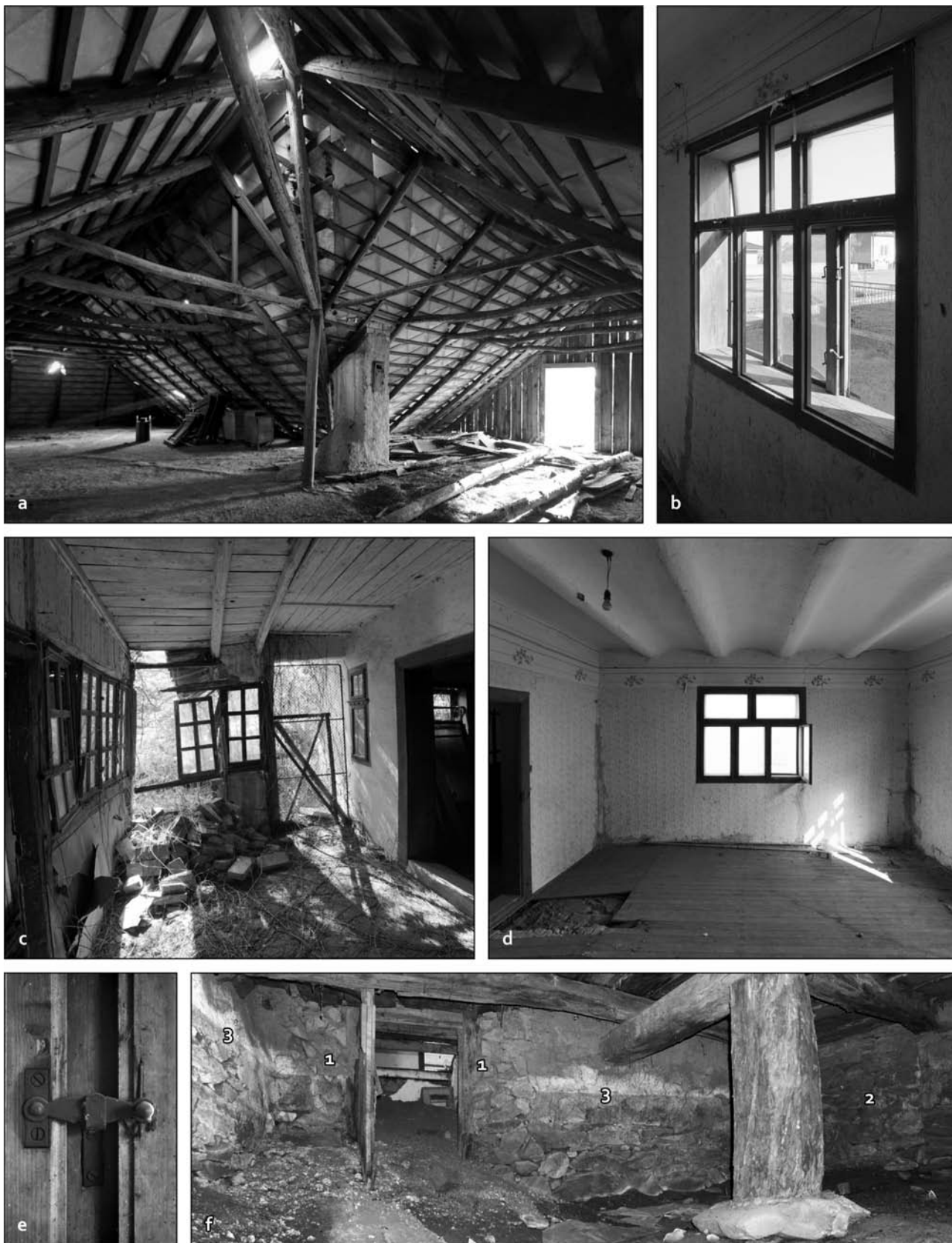
Obr. 12: Plechotice (okr. Trebišov), Čel'ovská 96/18, „Stara karčma“: a – krov, pohľad zo SV kúta, vľavo uličné krídlo, vpravo dvorové, po roke 1980 skrátené krídlo; b – južné okno uličného krídla; c – letná kuchyňa v kúte dvorového (vpravo) a uličného krídla, vľavo veranda, na podlahe deštrukcia pece so sporákom; d – južná miestnosť uličného krídla, pôvodne južná polovica sálu, pohľad k východnej, uličnej stene, vľavo priečka rozdeľiaca sálu v 50. rokoch; e – francúzsky obrtlík na okne uličného krídla; f – pivnica pod prednou izbou v SV kúte domu: 1 – ostenia druhotne vyburaného otvoru v južnom múre pre prístup z uličného krídla, 2 – zamurovaný starší vstup zo západu, 3 – hladina pôvodne z roku 2010, nad ňou zachovaná hlinená omietka (foto autor 2020).
