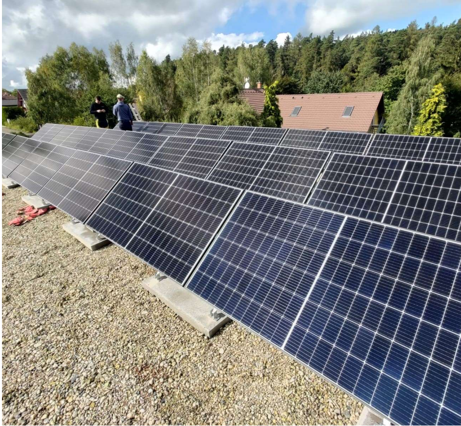
Obrázek 9 Umístění fotovoltaických panelů na samostatných konstrukcích
