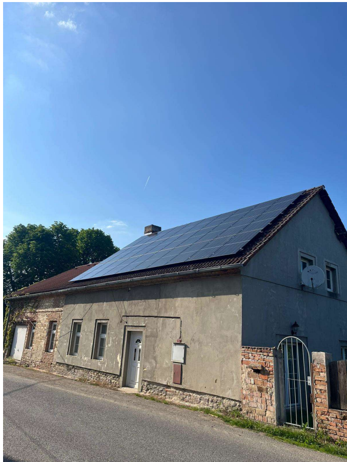
Obrázek 8 Umístění fotovoltaických panelů na střeše domu
