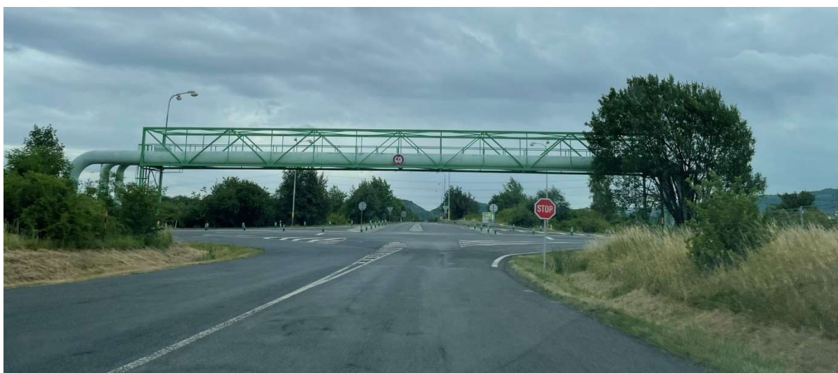
Obrázek 7 - Rameno ze směru od průmyslové zóny Verne (severní rameno)
