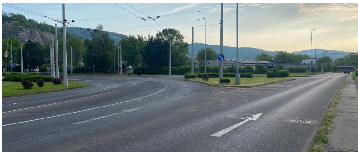
Obrázek 12 – Rozvětvení ulice Děčínská
