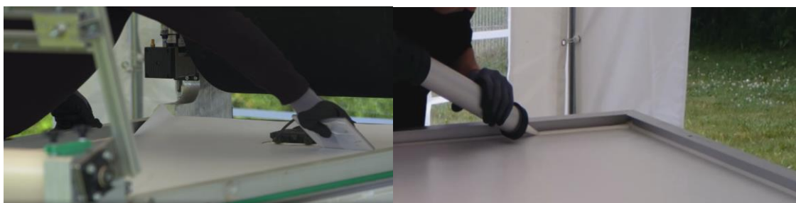
Obrázek 24: Utěsnění folie, [14]
