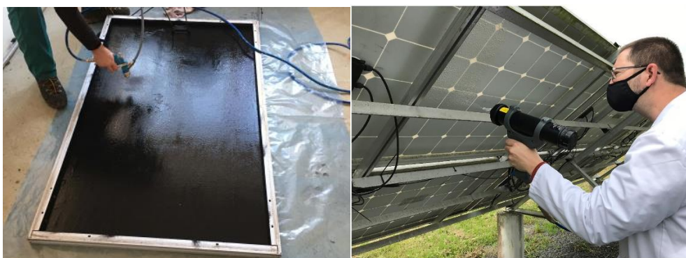
Obrázek 21: Nanesení siliconu tryskou v dílně (vlevo) a v terénu (vpravo), [12][15]
