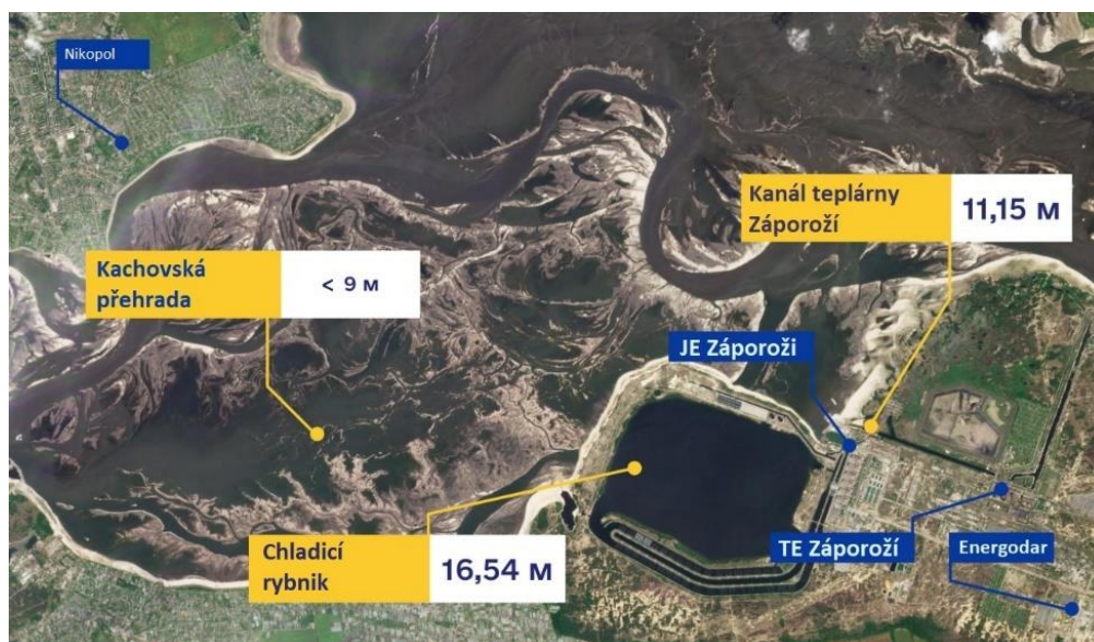
Obr. 4 Stav úrovně vody na JE Záporoží po vybuchnu na Kachovské přehradě (dne 7.7.2023) [19]
