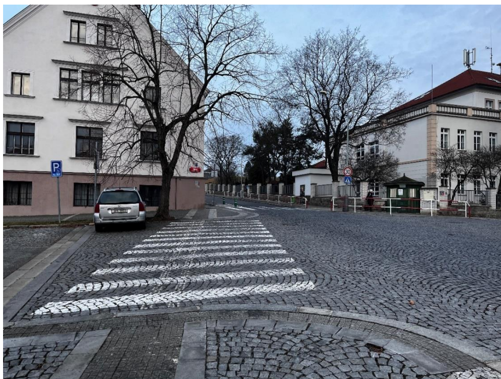
Obrázek 13 - Nevyhovující přechod přes ulici Farní v řešené křižovatce
