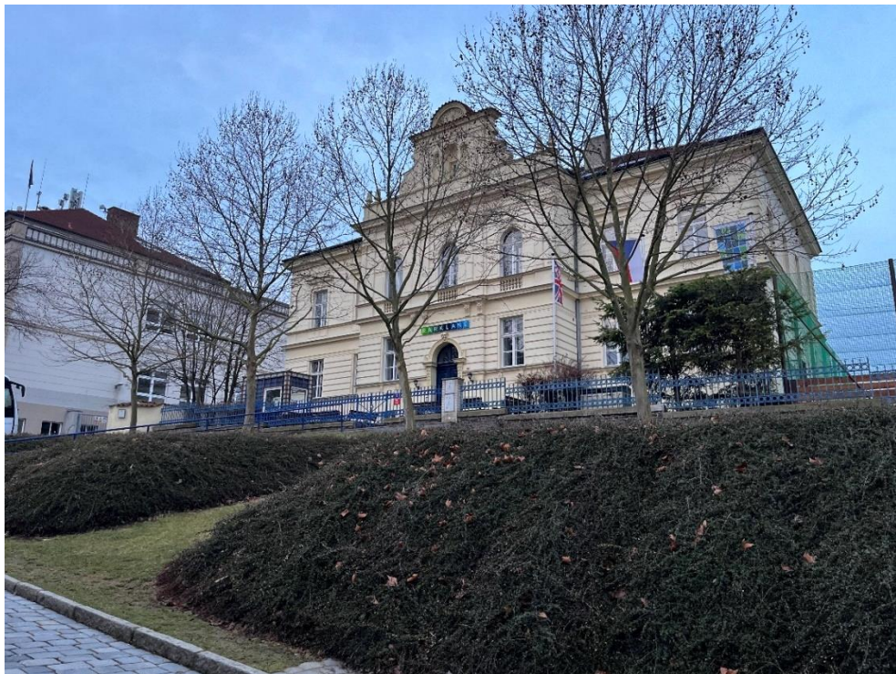
Obrázek 7 - Park Lane International School při pohledu z ulice Norbertov
