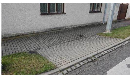
Obrázek 48 - Absence barevného zvýraznění prvků OOSPO na přechodu v ulici Polabská (zdroj: autor)
