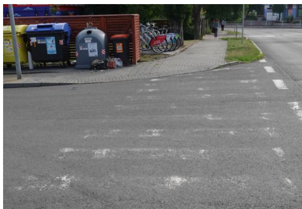
Obrázek 60 - Neadekvátní provedení prvků pro OOSPO (zdroj: autor)
