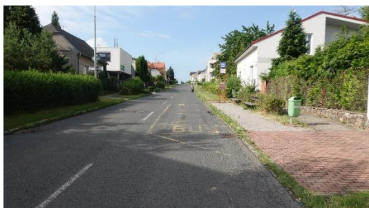
Obrázek 54 - Opatřebované VDZ V 2a, V 11a, V 12a, absence VDZ V 4 v ulici Všetatská (zdroj: autor)
