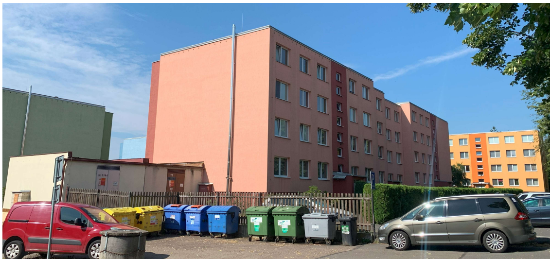
Obrázek 6: panelové domy jižně od Ringhofferova náměstí tvoří významný zdroj a cíl dopravy
