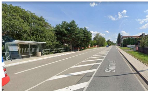
Obrázek 11: nynější stav po výstavbě chodníků a optimalizaci vodorovného značení 23
