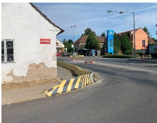
Obrázek 37: malý poloměr nároží a nevhovující rozhledové poměry
