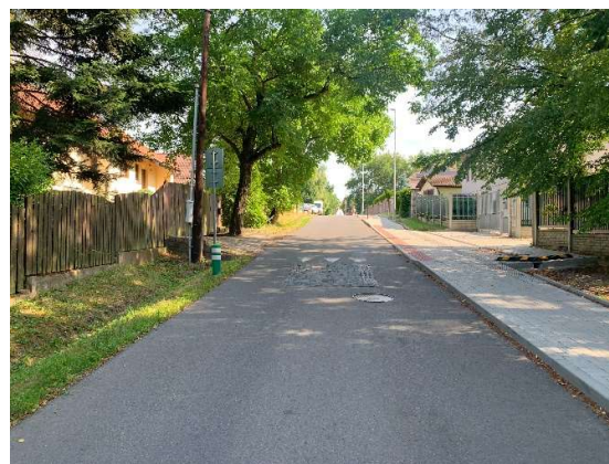
Obrázek 36: rekonstrukce komunikace a nový zpomalovací polštář
