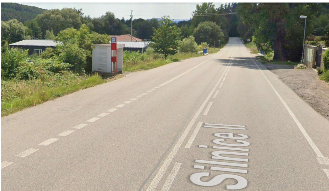
Obrázek 12: nevyhovující přístup pro pěší na autobusovou zastávku Kamenice, Kuklík na frekventované silnici II/603; absence chodníku a přechodu pro chodce 23
