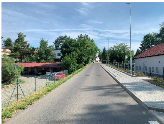
Obrázek 35: šířka komunikace po rekonstrukci dosahuje pouze 4 metrů
