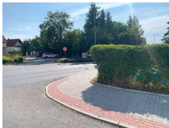
Obrázek 38: malý poloměr nároží a nevhovující rozhledové poměry
