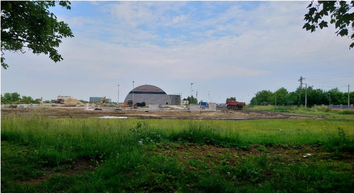
Obrázek 17: Příprava infrastruktury pro stavbu nových rodinných domů v lokalitě Háje (červen 2023).
