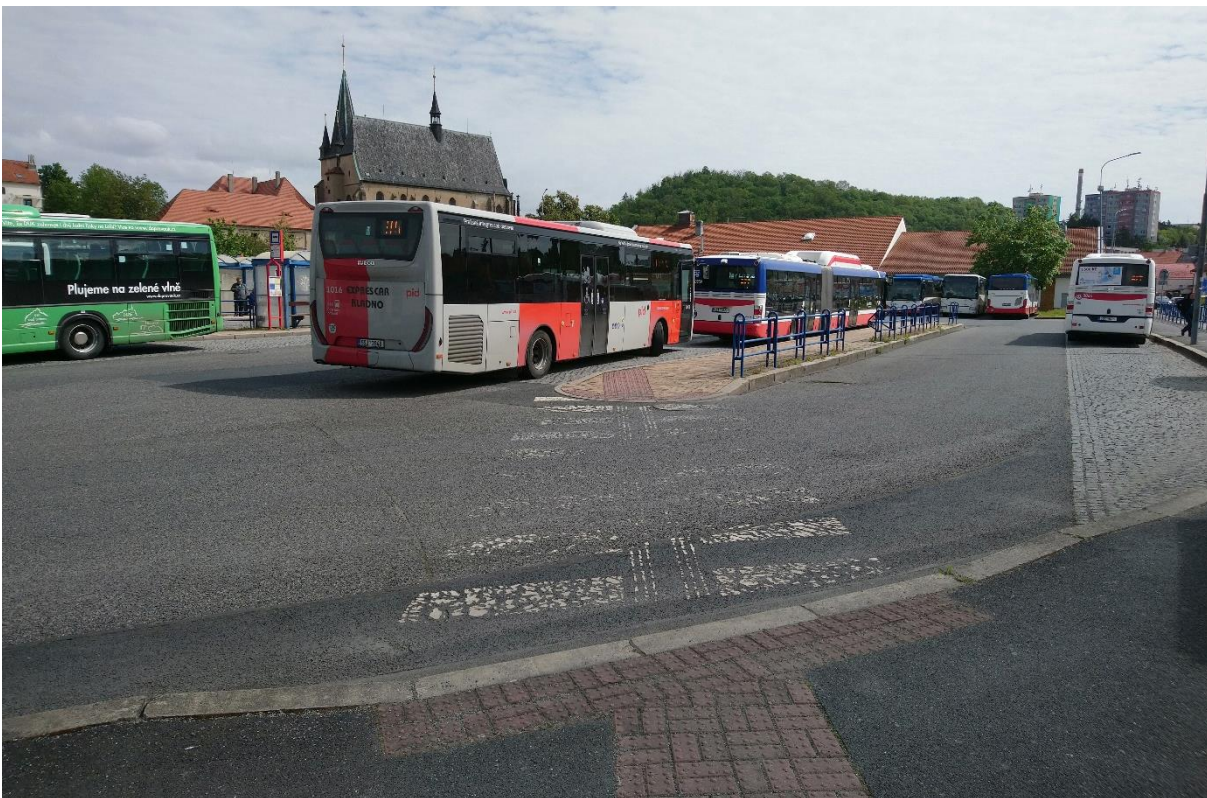
Obrázek 28: Jiný příklad neadekvátně provedeného přechodu pro chodce (deficit č. 18). Zde je mj. problémem nedostatečná šířka navazující chodníkové plochy na protější straně.
