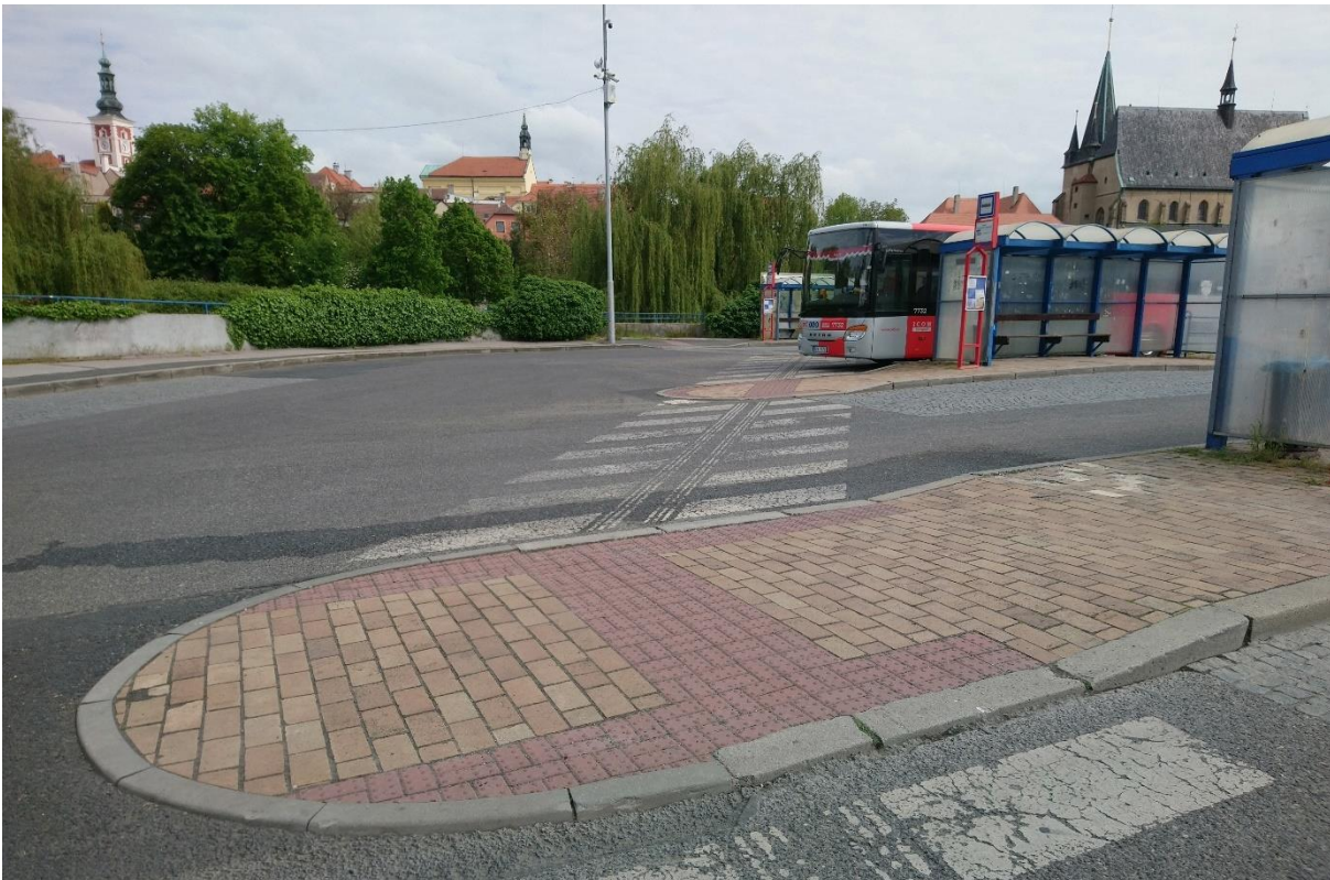
Obrázek 27: Chybné provedení prvků pro OOSPO na přechodu pro chodce (deficit č. 15). Za povšimnutí stojí také nesprávně zaparkovaný autobus – odstavná stání jsou nekomfortně přístupná pouze couváním, řidiči se tak často uchylují k jednoduššímu a rychlejšímu řešení.
