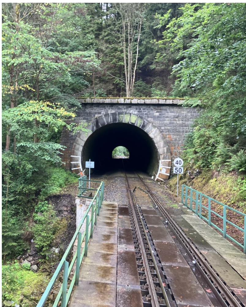
Obrázek 14: Vlaský tunel dimenzovaný pro druhou traťovou kolej, [autor]
