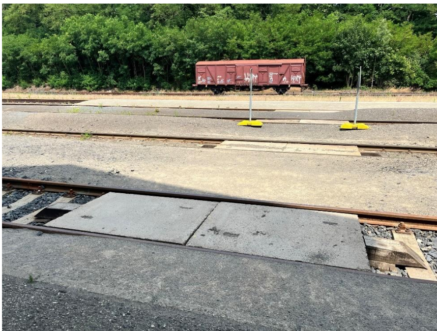
Obrázek 14 Prostřední úroňový přechod k nástupištím v ŽST Lužná u Rakovníka (zdroj: [Jáchym Thon, 10.7.2023])
