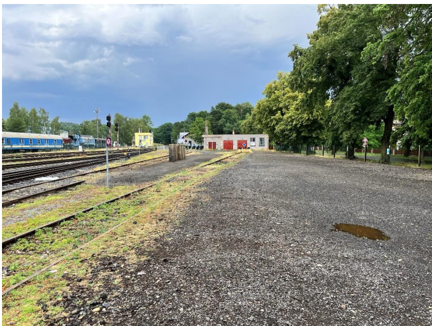
Obrázek 10 Pohled na zpevněnou plochu u koleje č. 9a směrem k řevničovskému zhlaví (zdroj: [Jáchym Thon, 10.7.2023])
