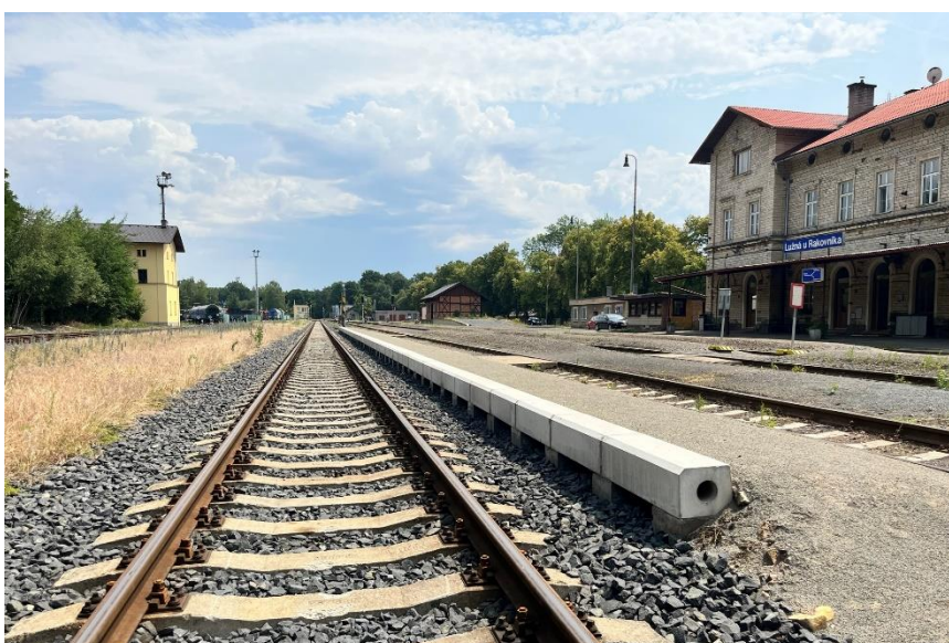
Obrázek 8 Nástupní hrana zpevněná betonovými kvádry na nástupišti č. 4 u koleje č. 2 (zdroj: [Jáchym Thon, 10.7.2023])
