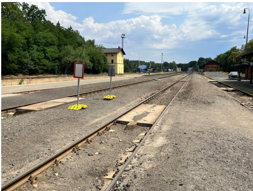
Obrázek 7 Pohled na nástupiště od VB ve směru řevničovského zhlaví (zdroj: [Jáchym Thon, 10.7.2023])
