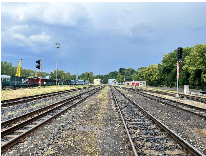
Obrázek 12 Pohled na odjezdová a seřadovací návěstidla před řevničovským zhlavím (zdroj: [Jáchym Thon, 10.7.2023])
