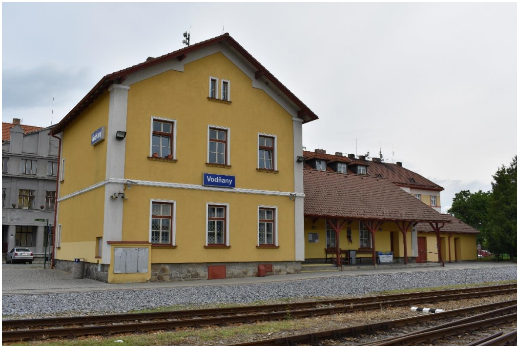
Obr. 6 - Budova železniční stanice Vodňany v Kampanově ulici (foto autora)
