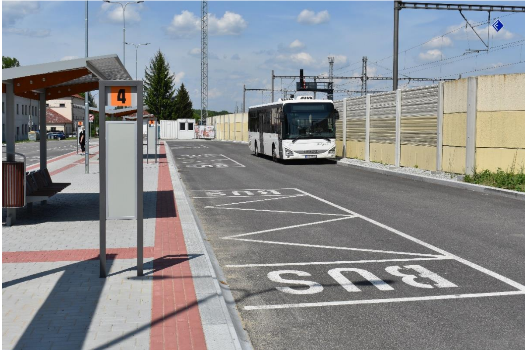
Obr. 23 - Pohled na stanoviště č. 4 — 6 přestupního terminálu v Soběslavi (foto autora)
