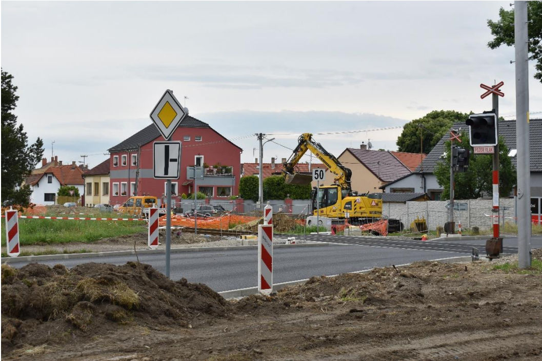
Obr. 10 - Aktuálně probíhající rekonstrukce (červen 2023) přejezdu v Kodádkově ulici (foto autora)
