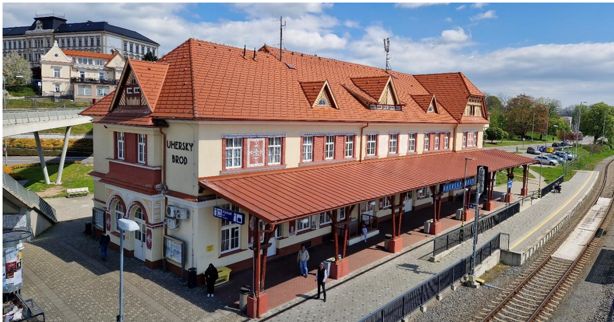
Obrázek 10 Výpravní budova ŽST Uherský Brod
