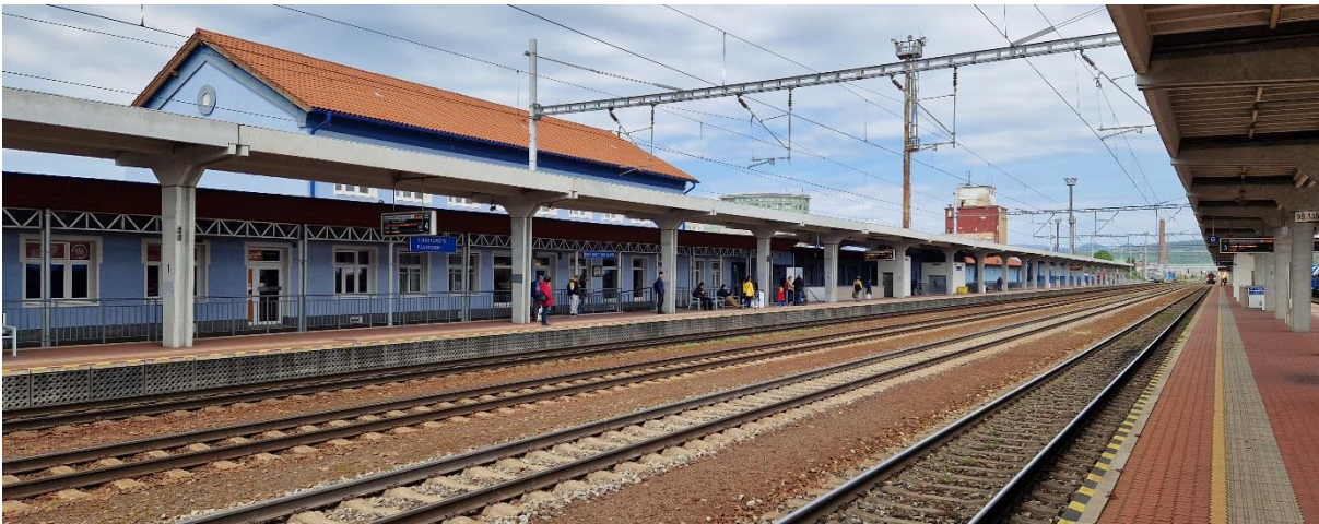
Obrázek 11 ŽST Nové Mesto nad Váhom, pohled z druhého nástupiště
