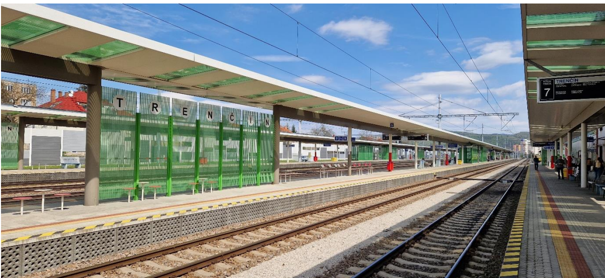
Obrázek 12 ŽST Trenčín, pohled z prvního nástupiště
