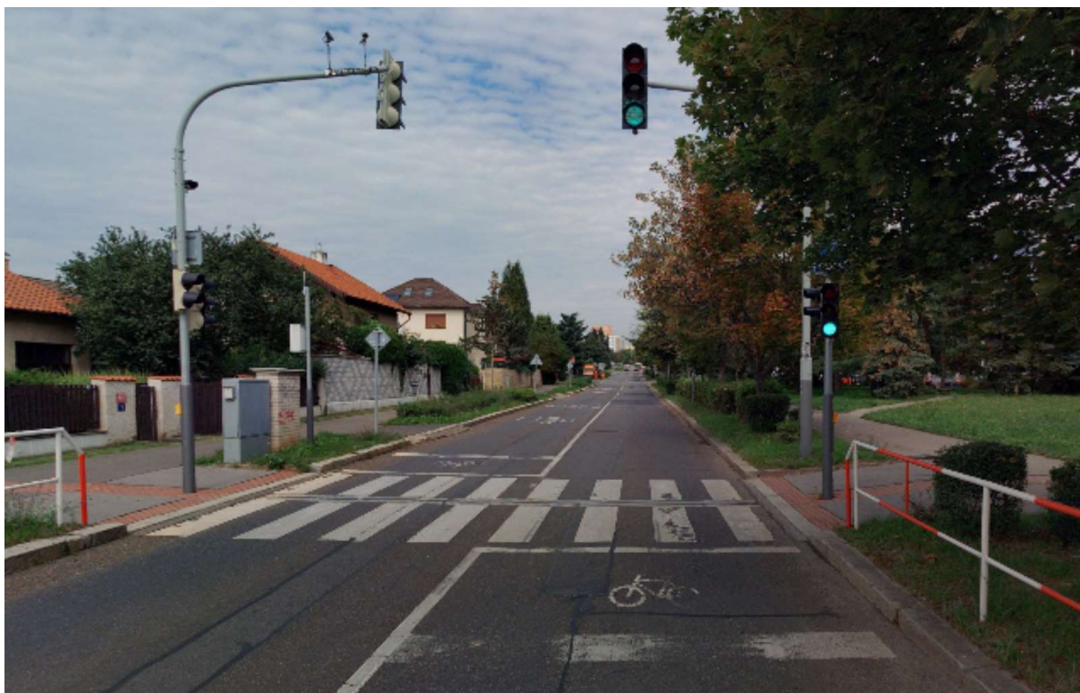
Obr. 5 - pohled na řízený přechod v Archimédově směrem k severu, zdroj: [8]
